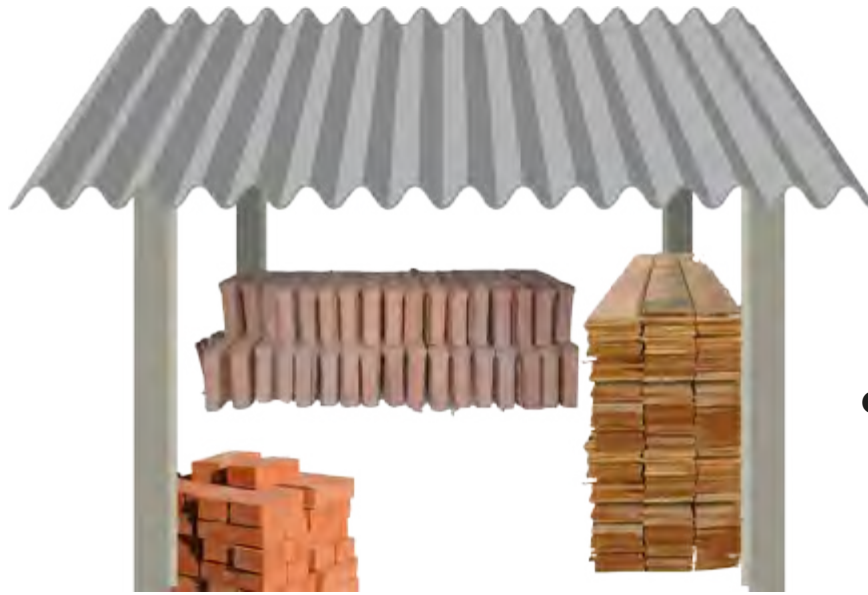
Material de construção organizado e coberto
