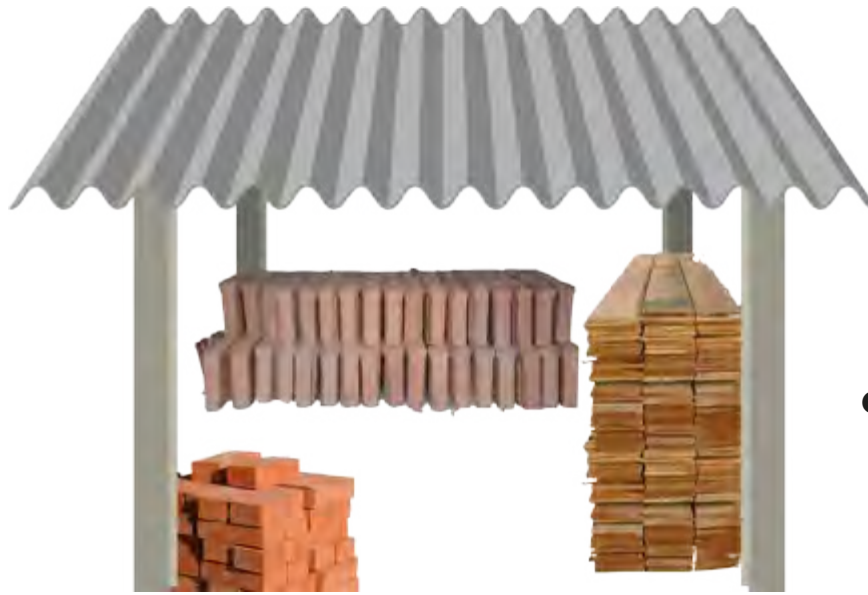
Material de construção organizado e coberto
