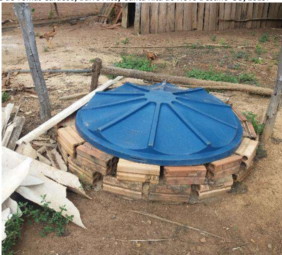
Foto 6.3 – Poço raso escavado com tampa de polietileno e mureta sem revestimento, na Comunidade de Tomás Cardoso, Barro Alto/ Santa Rita do Novo Destino-GO, 2019.
