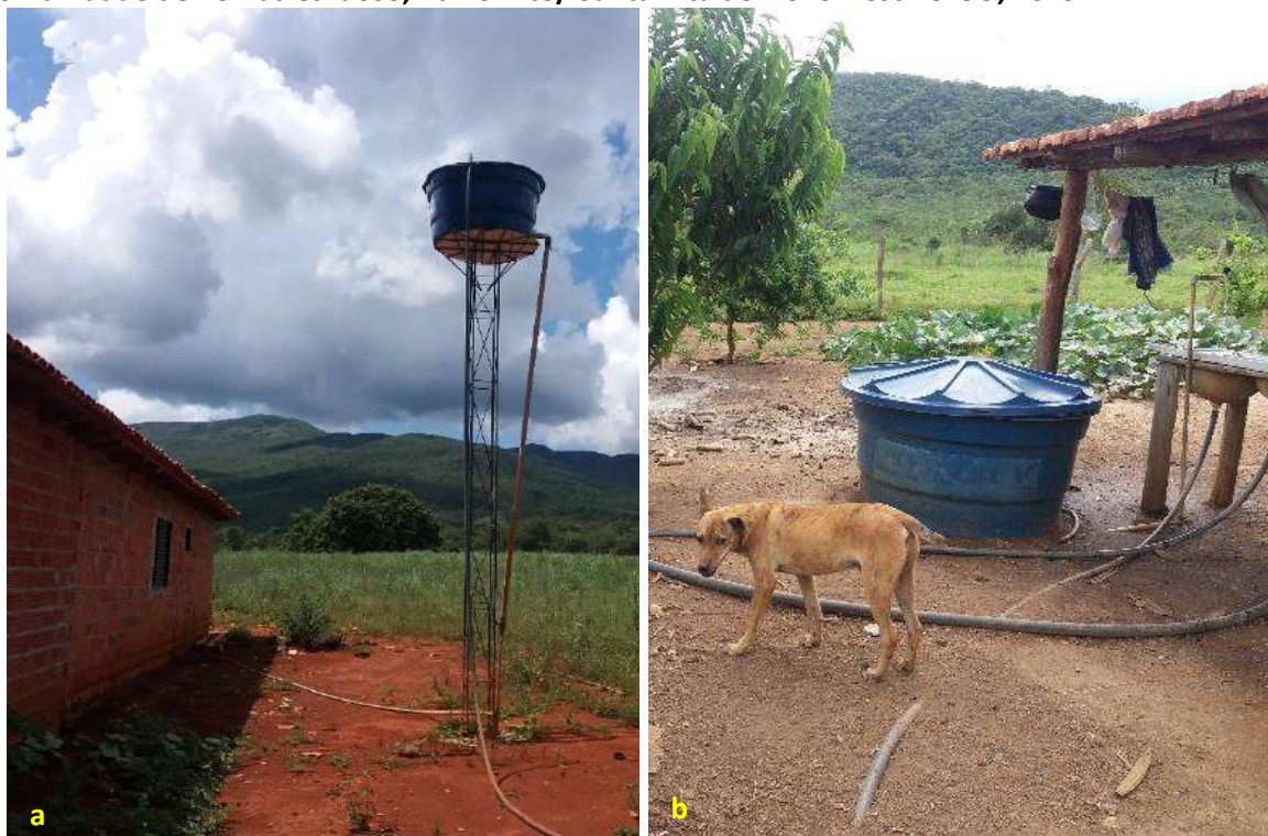
Foto 6.5 – Reservatório instalado sobre estrutura metálica (a) e outro apoiado ao solo (b), na Comunidade de Tomás Cardoso, Barro Alto/ Santa Rita do Novo Destino-GO, 2019.
