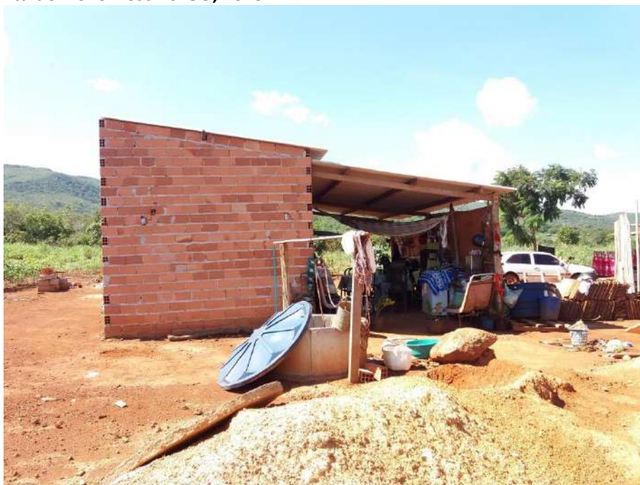
Foto 4.8 – Cobertura de telha de fibrocimento, identificada na Comunidade de Tomás Cardoso, Barro Alto/Santa Rita do Novo Destino-GO, 2019.
