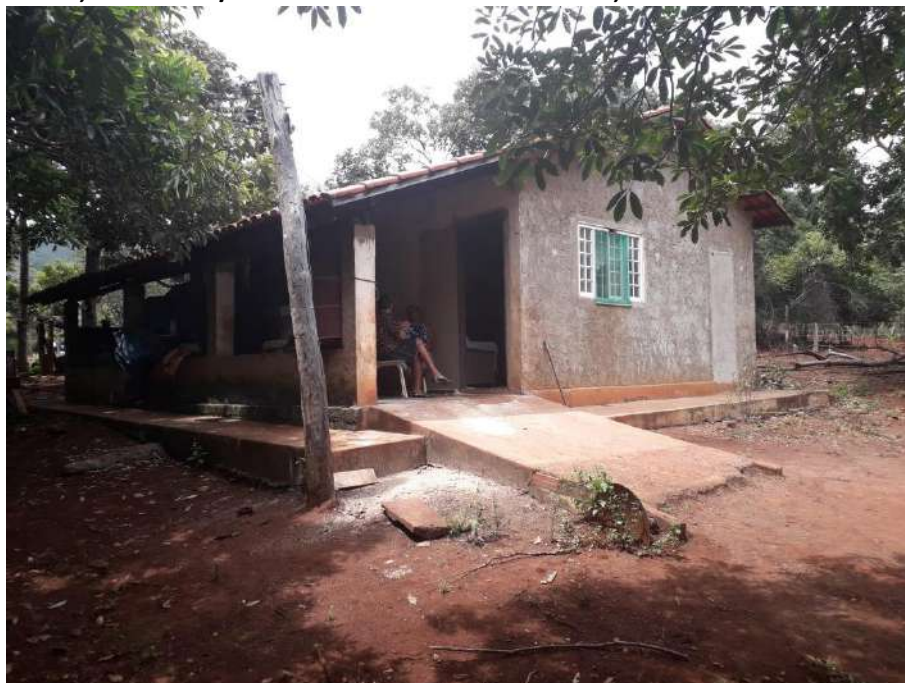
Foto 4.4 – Habitação construída de alvenaria com reboco sem pintura, identificada na Comunidade de Tomás Cardoso, Barro Alto/Santa Rita do Novo Destino-GO, 2019.
