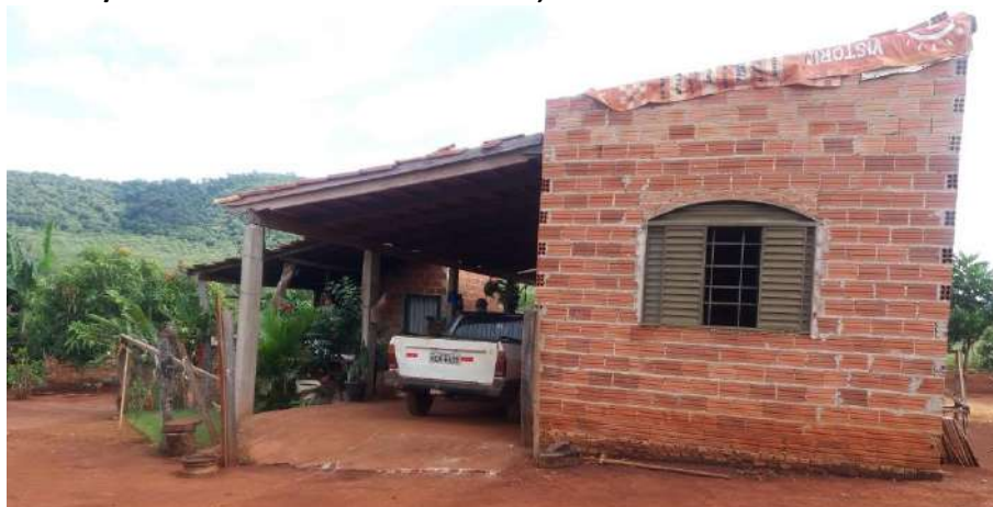
Foto 4.6 – Piso de residência constituído de concreto bruto, identificado na Comunidade de Tomás Cardoso, Barro Alto/Santa Rita do Novo Destino-GO, 2019.
