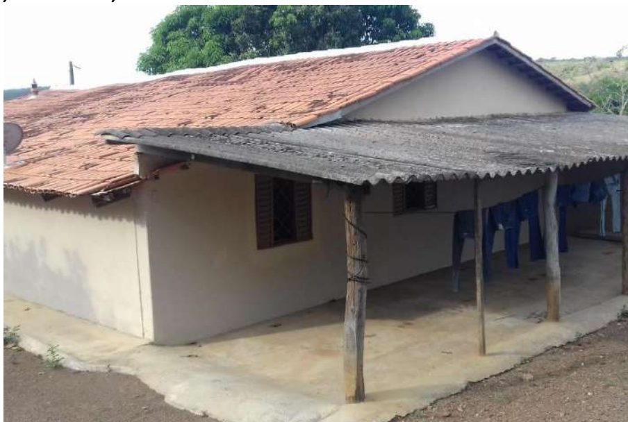
Foto 4.8 – Cobertura de telha de barro e fibrocimento, identificada na Comunidade São Sebastião da Garganta, Silvânia-GO, 2018.
