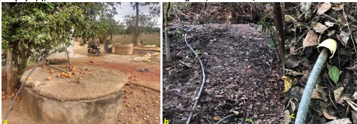
Foto 6.3 – Poço raso escavado com mureta de proteção e tampa de concreto (a), uma nascente sem dispositivos de proteção (b) e detalhamento da tubulação drenante sob essa nascente, considerado com poço (c), na Comunidade São Sebastião da Garganta, Silvânia-GO, 2018.
