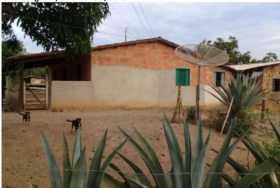
Foto 4.3 – Habitação construída de alvenaria sem reboco e com reboco, identificada na Comunidade São Sebastião da Garganta, Silvânia-GO, 2018.
