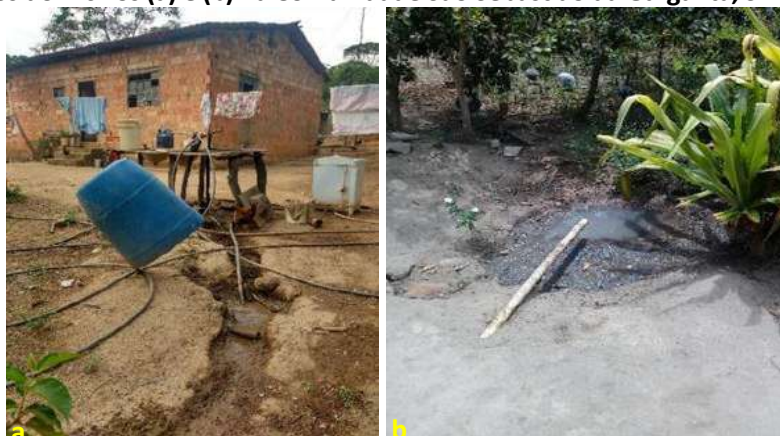
Foto 6.8 – Lançamento e acúmulo de água cinza proveniente da pia da cozinha diretamente no solo do quintal próximo aos domicílios (a) e (b) na Comunidade São Sebastião da Garganta, Silvânia-GO, 2018.
