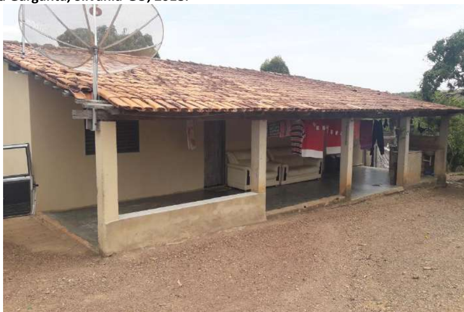
Foto 4.5 – Piso de residência constituído de cimento queimado, identificado na Comunidade São Sebastião da Garganta, Silvânia-GO, 2018.
