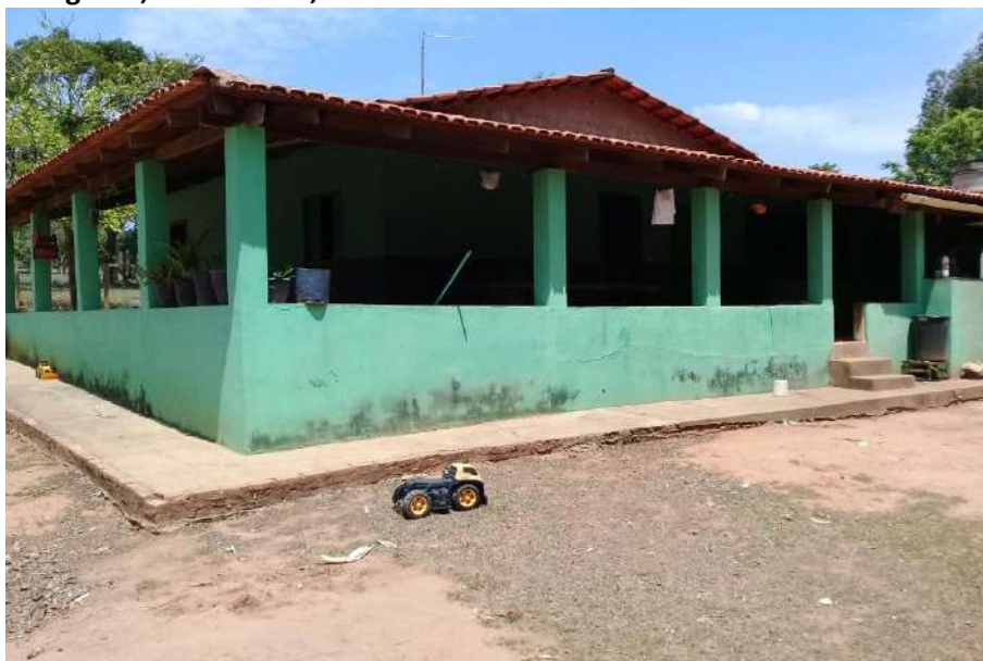
Foto 4.4 – Habitação construída de alvenaria com reboco e pintura, identificada na Comunidade São Sebastião da Garganta, Silvânia-GO, 2018.
