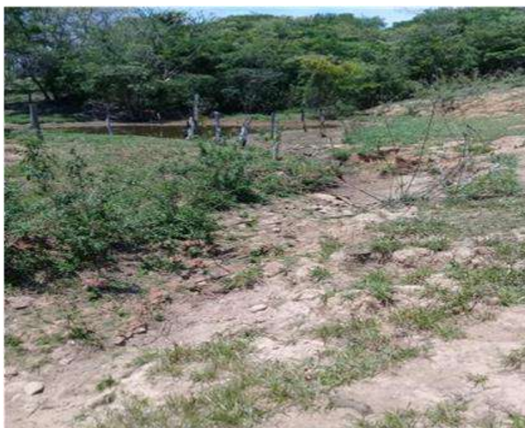
Foto 6.21 – Exemplo de processo erosivo em lote da Comunidade São Sebastião da Garganta, Silvânia-GO, 2018.
