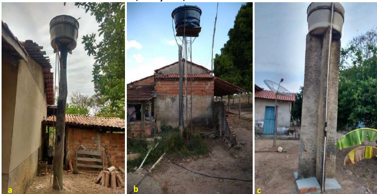
Foto 6.5 – Reservatório em fibrocimento sobre estrutura de madeira (a), reservatório em polietileno sobre estrutura metálica (b), Reservatório em fibrocimento sobre estrutura de alvenaria (c), Comunidade Sebastião Rosa da Paz, Uruaçu-GO, 2018.
