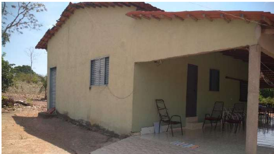
Foto 4.4 – Piso de cerâmica, identificado nas habitações da Comunidade Sebastião Rosa da Paz, Uruaçu-GO, 2018.
