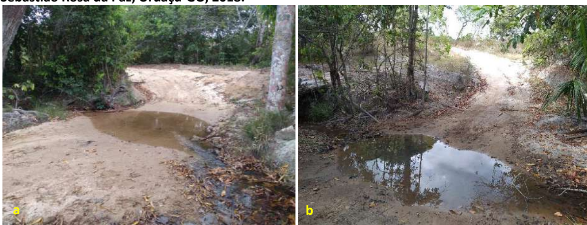
Foto 6.17 – Pontos de alagamento (ponto de passagem de córregos) na via de acesso à Comunidade Sebastião Rosa da Paz, Uruaçu-GO, 2018.
