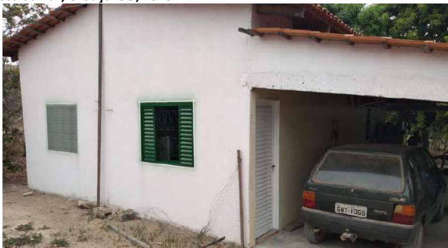
Foto 4.1 – Habitação construída de alvenaria com reboco e pintura, identificada na Comunidade Sebastião Rosa da Paz, Uruaçu-GO, 2018.
