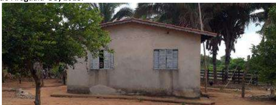
Foto 4.6 – Habitação construída de alvenaria com reboco, identificada na Comunidade Rio Araguaia, São Miguel do Araguaia-GO, 2018.
