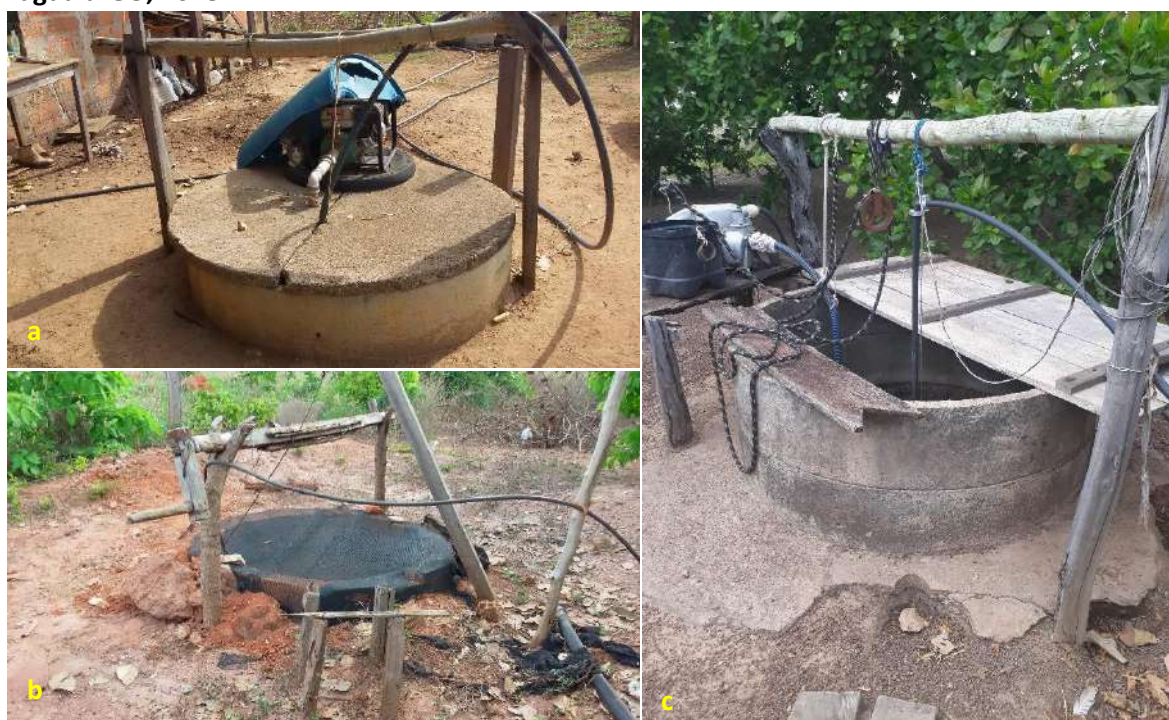
Foto 6.3 – Poço raso escavado com tampa em concreto (a), com mureta de proteção sem revestimento (b), e outro parcialmente calçado (c), na Comunidade Rio Araguaia, São Miguel do Araguaia-GO, 2018.
