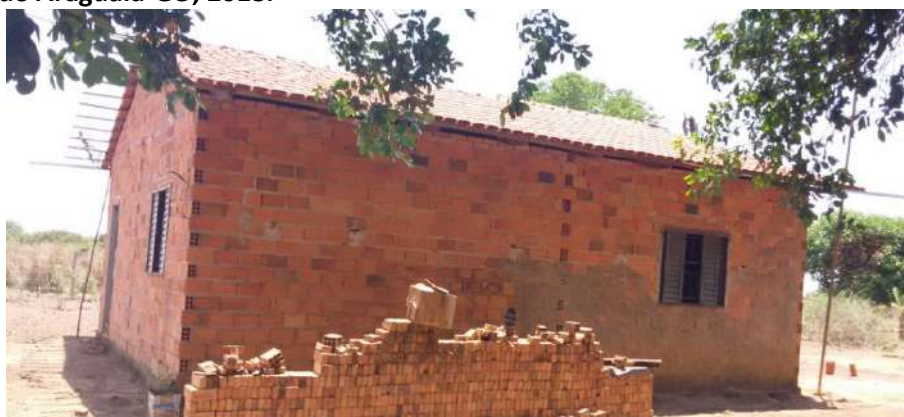
Foto 4.5 – Habitação construída de alvenaria sem reboco, identificada na Comunidade Rio Araguaia, São Miguel do Araguaia-GO, 2018.
