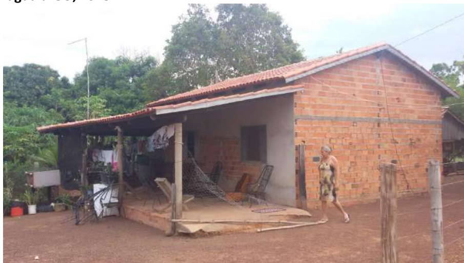
Foto 4.8 – Piso de concreto bruto, identificado nas habitações na Comunidade Rio Araguaia, São Miguel do Araguaia-GO, 2018.
