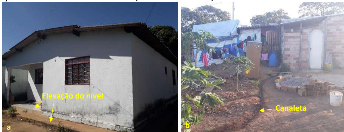
Foto 6.13 – Dispositivos de prevenção dos danos provocados pelas águas em residência (a) e em lote (b) da Comunidade Recantos Dourados, Abadia de Goiás-GO, 2019.
