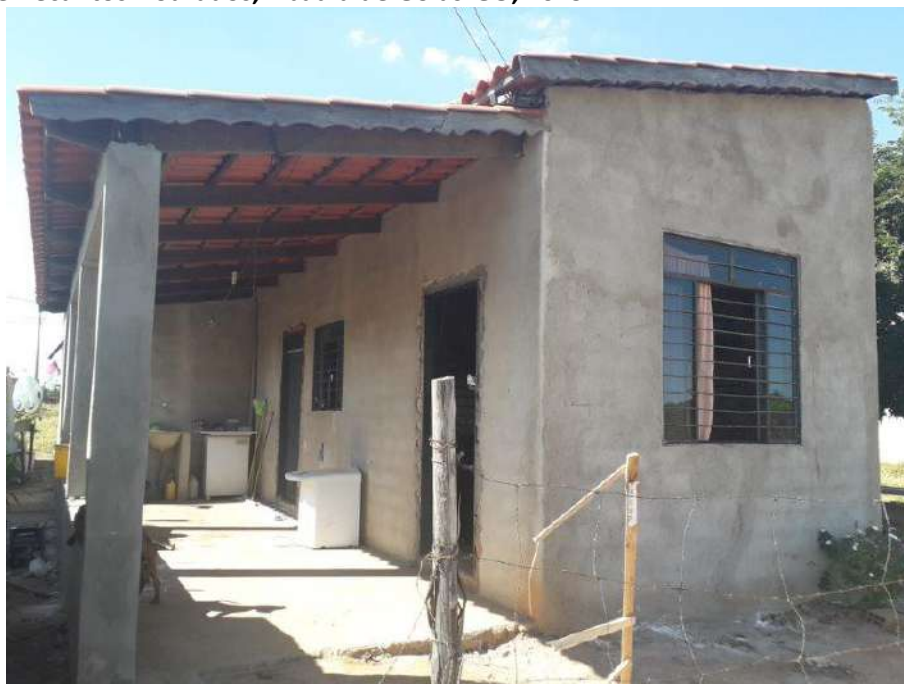
Foto 4.3 – Habitação construída de alvenaria com reboco, identificada nas habitações da Comunidade Recantos Dourados, Abadia de Goiás-GO, 2019.
