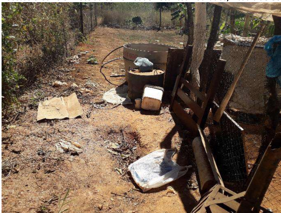
Foto 6.14 – Processo erosivo em lote da Comunidade Recantos Dourados, Abadia de Goiás-GO, 2019.
