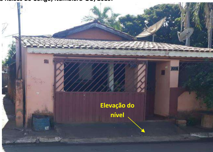
Foto 6.10 – Dispositivo de prevenção dos danos provocados pelas águas em residência da Comunidade Raízes do Congo, Itumbiara-GO, 2019.
