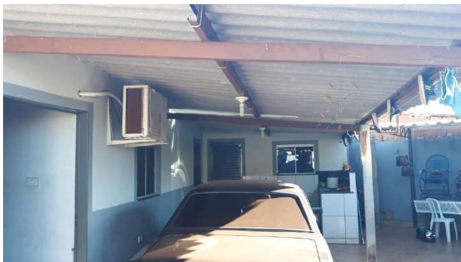
Foto 4.8 – Cobertura de fibrocimento identificada na Comunidade Raízes do Congo, Itumbiara-GO, 2019.
