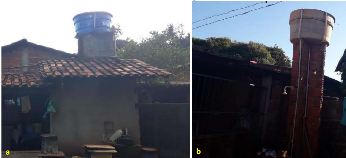
Foto 6.3 – Reservatórios domiciliares de polietileno (a) e de fibrocimento (b), instalados sobre estruturas em alvenaria, na Comunidade Raízes do Congo, Itumbiara-GO, 2019.
