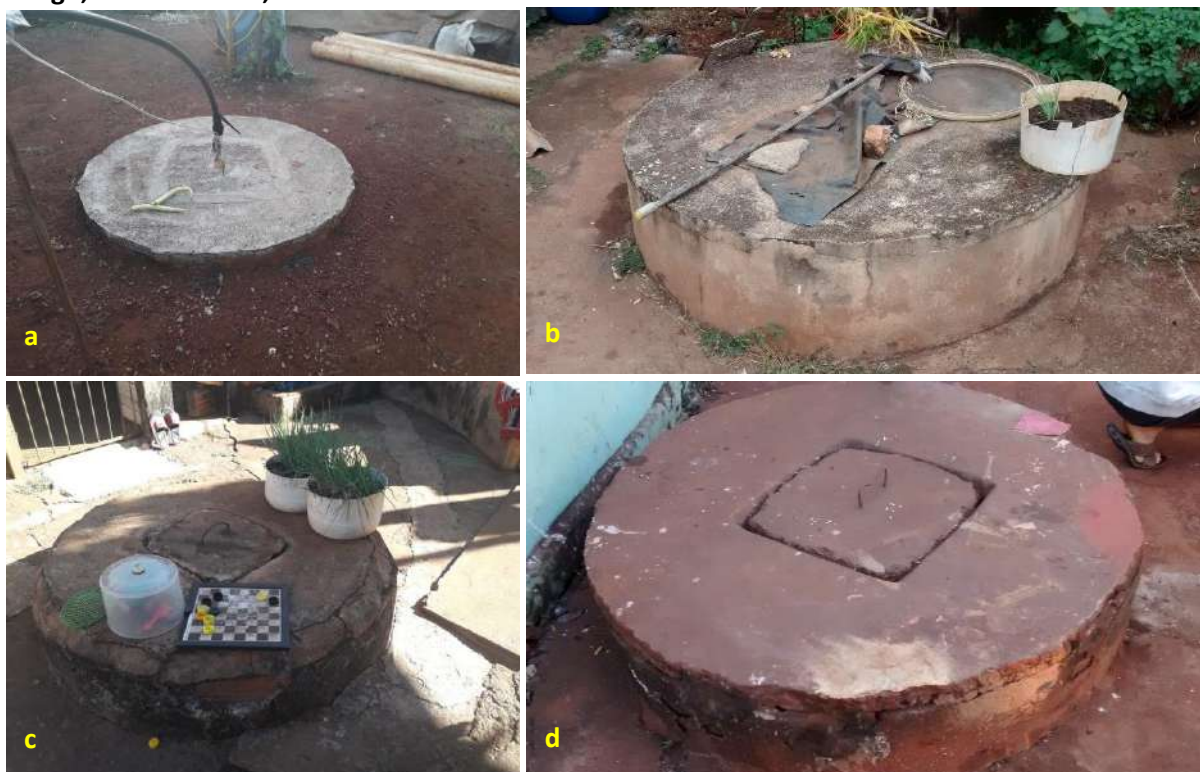
Foto 6.2 – Poços rasos escavados apenas com tampa de concreto (a), tampa de concreto e mureta de proteção (b), calçado ao redor e com abertura de inspeção (c) e (d), na Comunidade Raízes do Congo, Itumbiara-GO, 2019.
