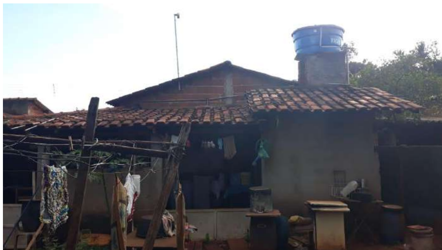
Foto 4.7 – Cobertura de telha de barro, identificada na Comunidade Raízes do Congo, Itumbiara-GO, 2019.
