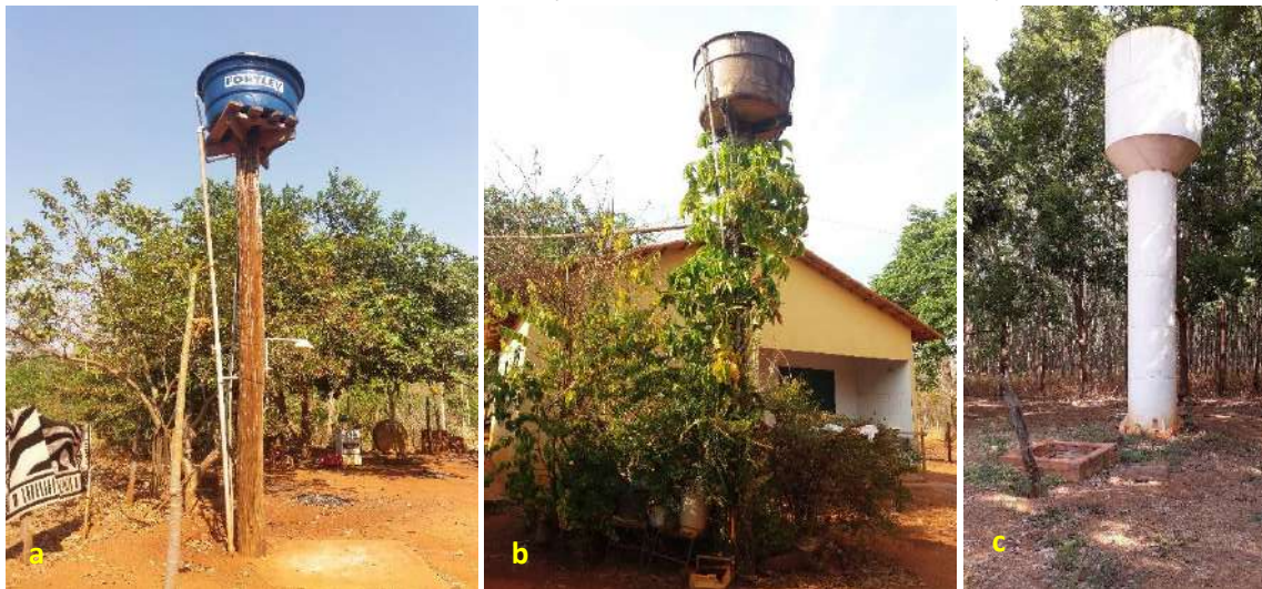
Foto 6.11 – Reservatório de polietileno (a) e reservatório de fibrocimento (b) sobre estruturas de madeira e de alvenarias, respectivamente, e reservatório tipo taça construído em material metálico (c) na Comunidade de Quilombo de Pombal, Santa Rita do Novo Destino-GO, 2019.
