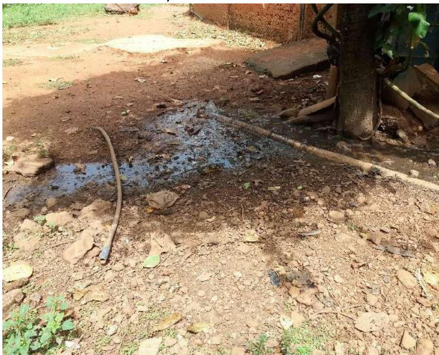
Foto 6.14 – Lançamento e acúmulo de água cinza proveniente da pia da cozinha e/ou tanque de lavar roupas diretamente no solo do quintal próximo aos domicílios na Comunidade de Quilombo de Pombal, Santa Rita do Novo Destino-GO, 2019.
