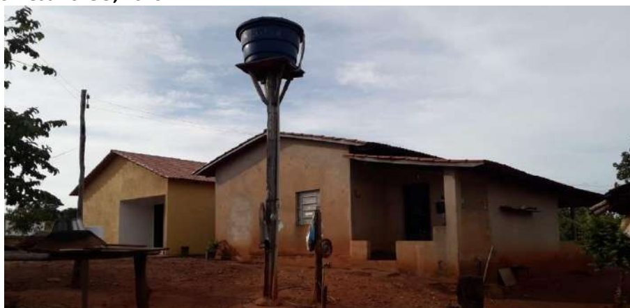
Foto 4.13 – Cobertura de telha de barro, identificada na Comunidade de Quilombo de Pombal, Santa Rita do Novo Destino-GO, 2019.
