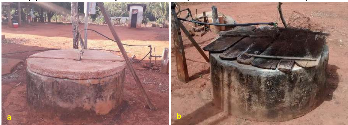
Foto 6.5 – Poços rasos escavados com mureta e tampa de concreto (a) e tampa improvisada de madeira (b) na Comunidade de Quilombo de Pombal, Santa Rita do Novo Destino-GO, 2019.
