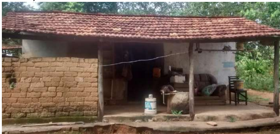
Foto 4.10 – Piso de concreto bruto, identificado na Comunidade de Quilombo de Pombal, Santa Rita do Novo Destino-GO, 2019.
