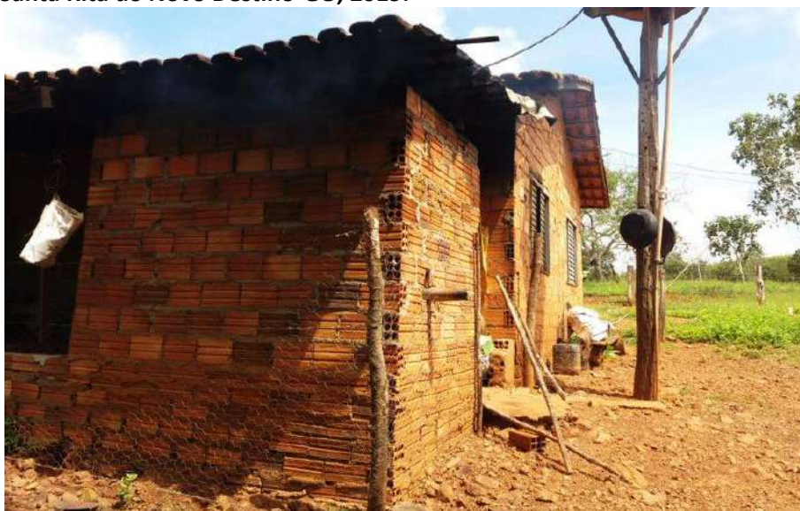
Foto 4.9 – Habitação construída de alvenaria sem reboco, identificada na Comunidade de Quilombo de Pombal, Santa Rita do Novo Destino-GO, 2019.
