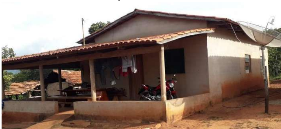
Foto 4.8 – Habitação construída de alvenaria com reboco, identificada na Comunidade de Quilombo de Pombal, Santa Rita do Novo Destino-GO, 2019.
