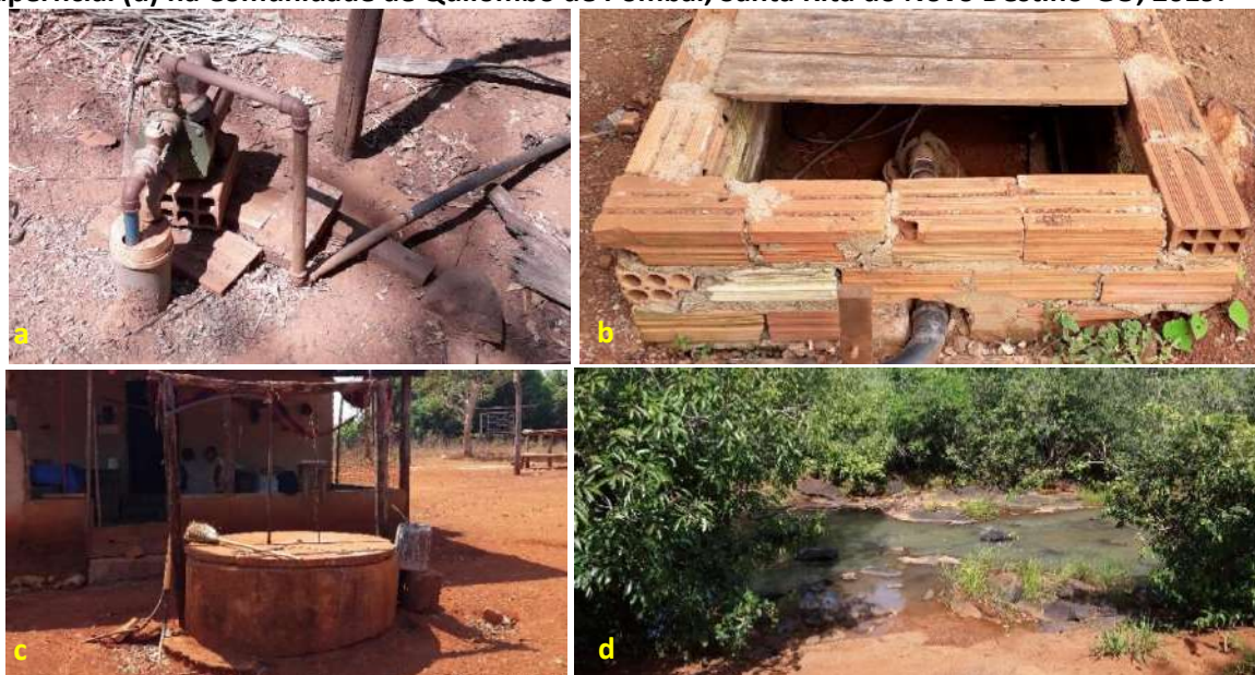
Foto 6.1 – Poço tubular raso (a), poço tubular profundo (b), poço raso escavado (c) e manancial superficial (d) na Comunidade de Quilombo de Pombal, Santa Rita do Novo Destino-GO, 2019.
