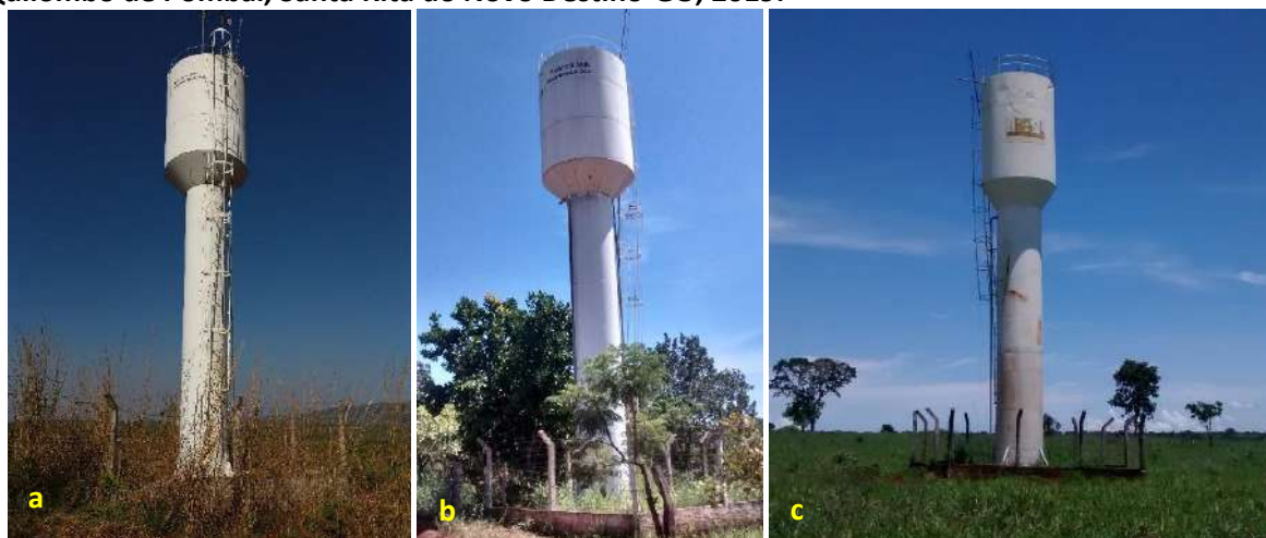
Foto 6.4 – Reservatórios coletivos, R1 (a), R2 (b) e R3 (c), do tipo taça em material metálico e devidamente cercados, que abastecem, respectivamente, o SAA1, SAA2 e SAA3 da Comunidade de Quilombo de Pombal, Santa Rita do Novo Destino-GO, 2019.
