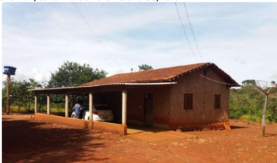
Foto 4.12 – Cobertura de telha de barro e telha fibrocimento, identificada na Comunidade de Quilombo de Pombal, Santa Rita do Novo Destino-GO, 2019.
