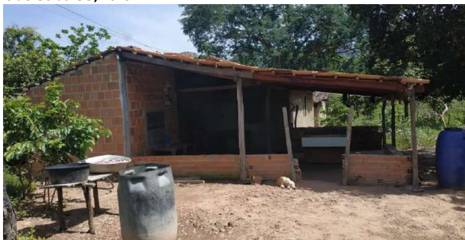
Foto 4.7 – Habitação construída de alvenaria sem reboco, identificada na Comunidade de Pelotas, Monte Alegre de Goiás-GO, 2019.
