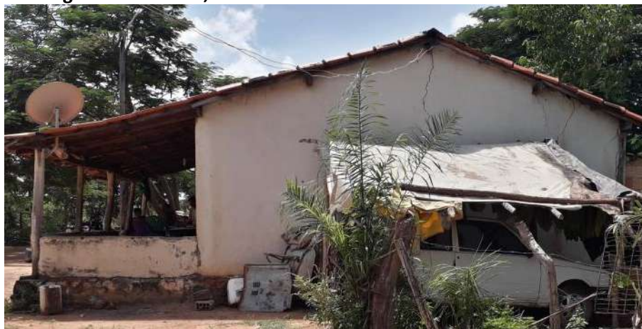
Foto 4.8 – Habitação construída de alvenaria com reboco e pintura, identificada na Comunidade de Pelotas, Monte Alegre de Goiás-GO, 2019.
