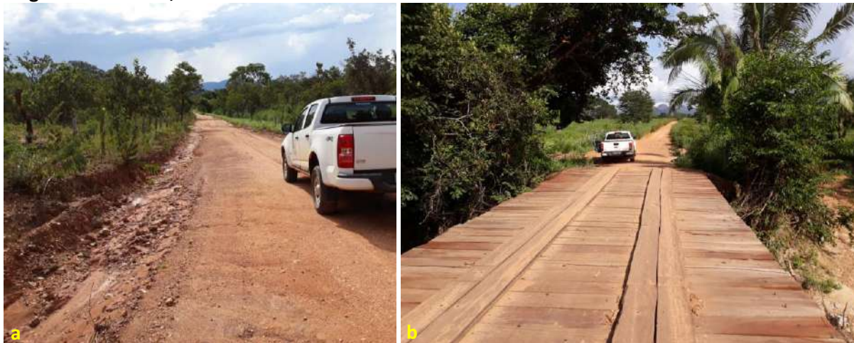
Foto 6.16 – Via de acesso (a) e ponte sobre fundo de vale (b) na Comunidade de Pelotas, Monte Alegre de Goiás-GO, 2019.
