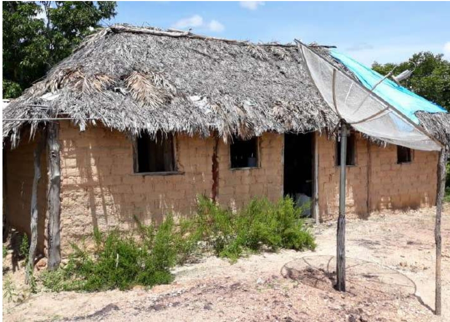
Foto 4.14 – Cobertura de palha, identificada na Comunidade de Pelotas, Monte Alegre de Goiás-GO, 2019.
