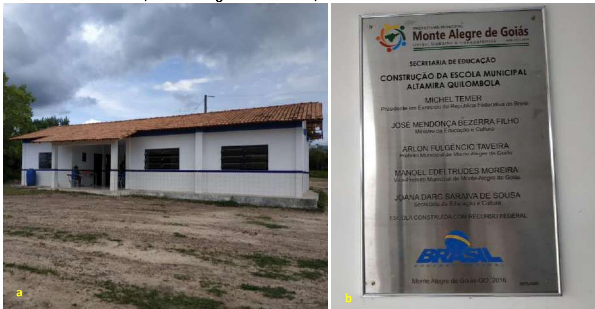
Foto 4.1 – Escola Municipal Altamira Quilombola (a) e sua placa de construção (b), identificada na Comunidade de Pelotas, Monte Alegre de Goiás-GO, 2019.
