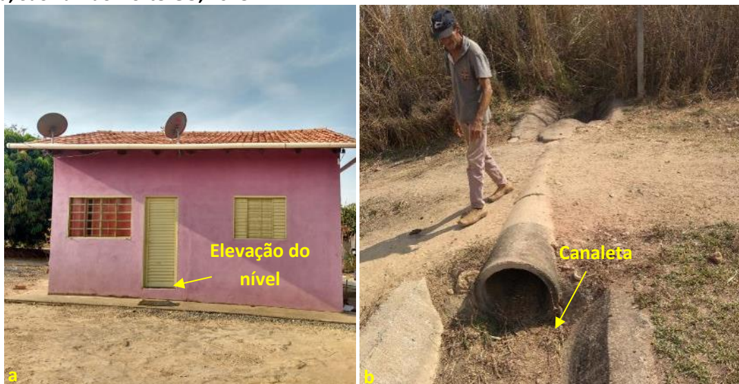
Foto 6.18 – Dispositivos de prevenção dos danos provocados pelas águas, na Comunidade Monte Moria, São Luiz do Norte-GO, 2018.
