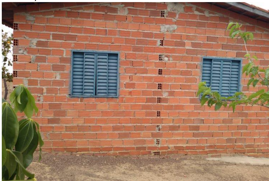
Foto 4.4 – Habitação construída de alvenaria sem reboco, identificada na Comunidade Monte Moria, São Luiz do Norte-GO, 2018.
