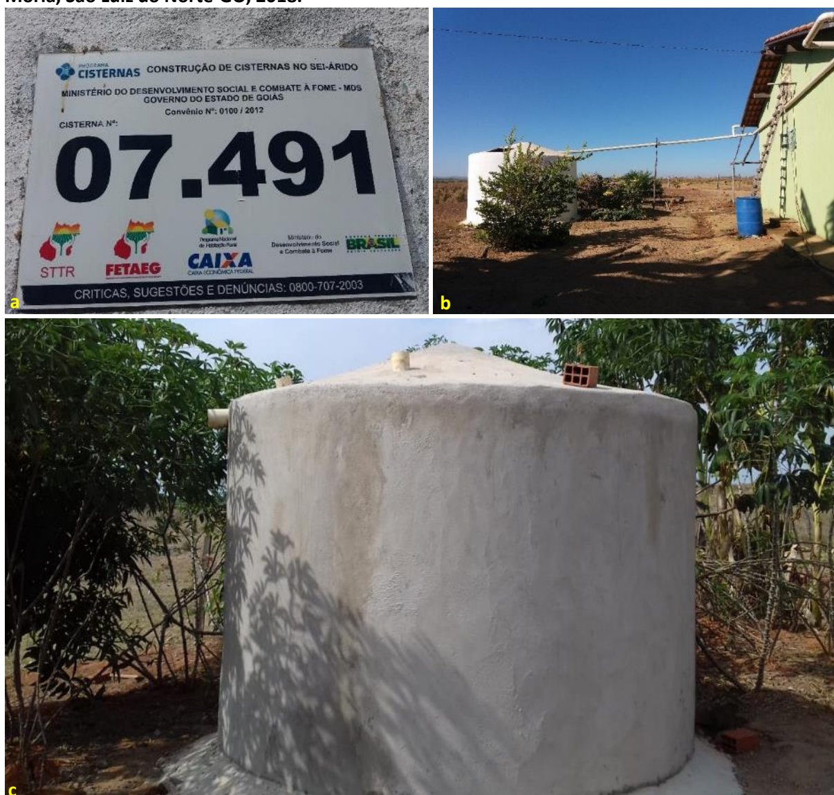
Foto 6.3 – Placa de identificação do Programa Cisternas (a), sistema para captação de água de um domicílio (b) e detalhe da cisterna para armazenamento da água de chuva (c), Comunidade Monte Moria, São Luiz do Norte-GO, 2018.
