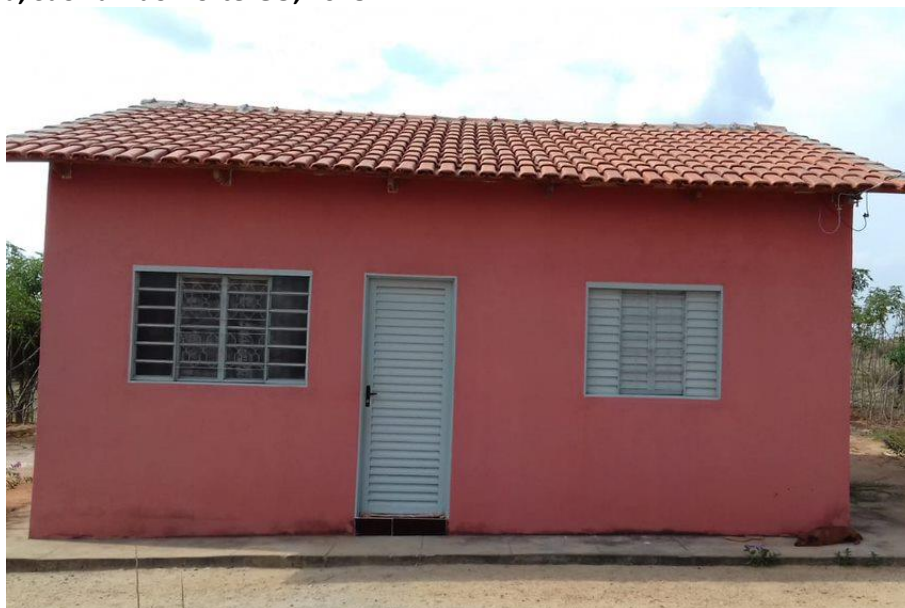
Foto 4.3 – Habitação construída de alvenaria com reboco e pintura, identificada na Comunidade Monte Moria, São Luiz do Norte-GO, 2018.
