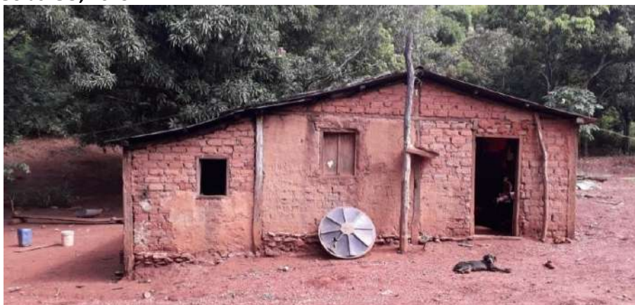
Foto 4.8 – Habitação construída de adobe, identificada na Comunidade de Mimoso (Queixo Dantas), Mimoso de Goiás-GO, 2019.
