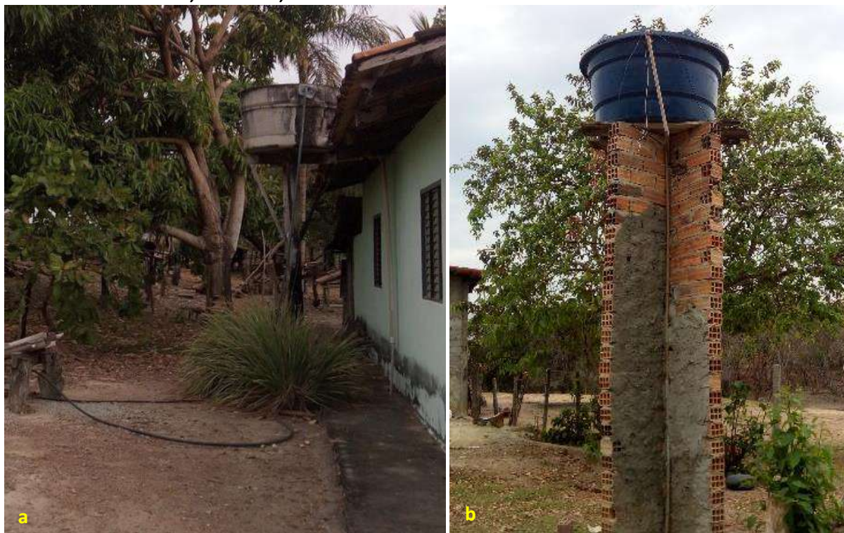
Foto 6.5 - Reservatórios domiciliares instalados sobre estrutura em madeira (a) ou alvenaria (b), na Comunidade Limoeiro, Faina-GO, 2018.
