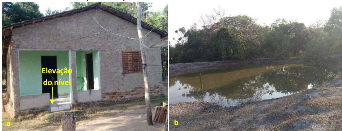
Foto 6.21 – Dispositivos de prevenção dos danos provocados pelas águas em residência (a) e lote (b) da Comunidade Limoeiro, Faina-GO, 2018.
