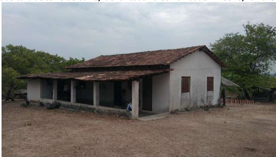
Foto 4.6 – Cobertura de telha de barro, identificada na Comunidade Limoeiro, Faina-GO, 2018.
