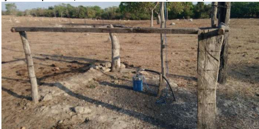
Foto 6.3 – Poço tubular profundo, na Comunidade Limoeiro, Faina-GO, 2018.
