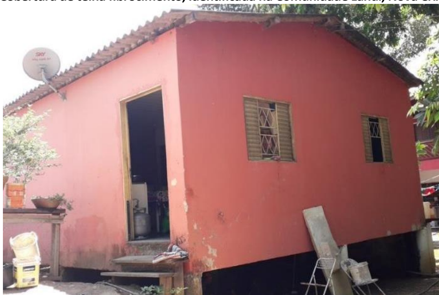
Foto 4.11 – Cobertura de telha fibrocimento, identificada na Comunidade Landi, Nova Crixás-GO, 2019.
