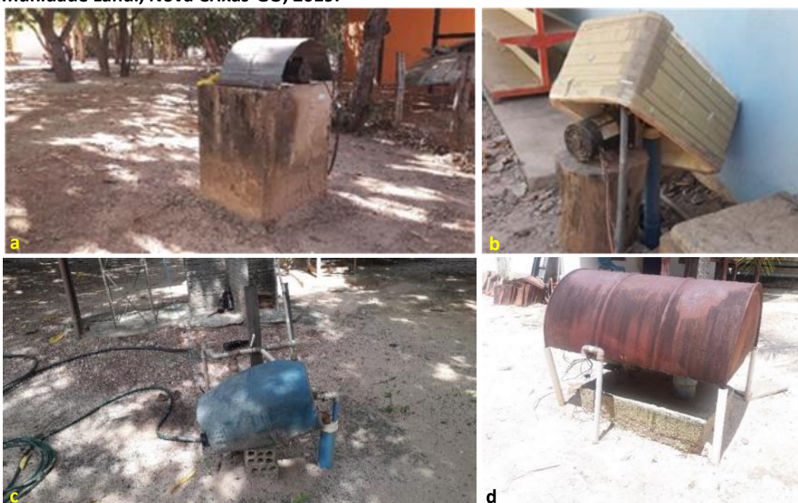
Foto 6.2 – Poço tubular raso tampado com material metálico (a), ou de forma improvisada, utilizando caixa de isopor (b) ou bombona cortada em material plástico (c) ou tambor metálico (d), na Comunidade Landi, Nova Crixás-GO, 2019.
