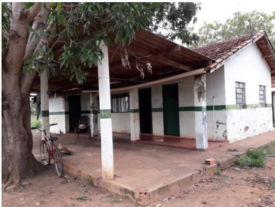
Foto 4.9 – Piso de cimento queimado e concreto bruto, identificado na Comunidade Landi, Nova Crixás-GO, 2019.
