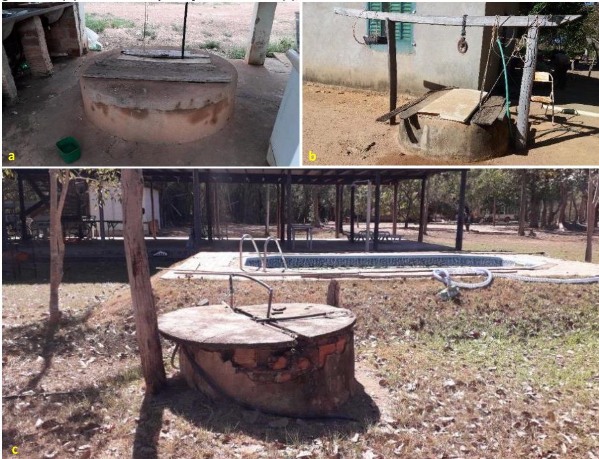
Foto 6.3 – Poço raso escavado com mecanismos de proteção (a), tampado com madeira e porta de geladeira (b) e mureta de proteção danificada (c), Comunidade Landi, Nova Crixás-GO, 2019.
