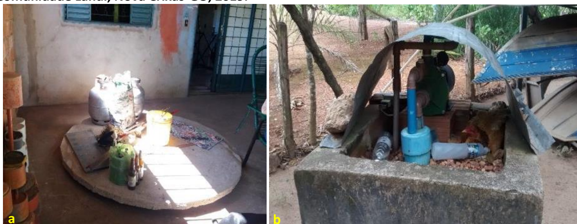
Foto 6.1 – Poço raso escavado (a) e poço tubular raso - minipoço (b) utilizados em domicílios da Comunidade Landi, Nova Crixás-GO, 2019.
