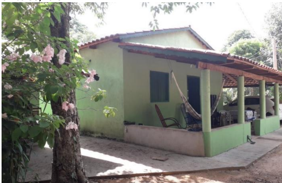
Foto 4.7 – Habitação construída de alvenaria com reboco e pintura, identificada na Comunidade Landi, Nova Crixás-GO, 2019.
