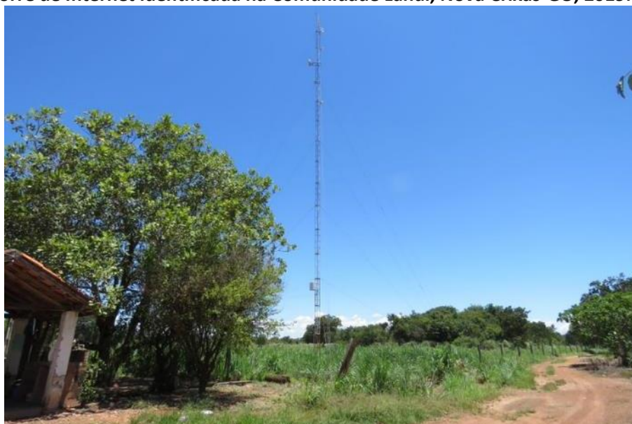
Foto 4.6 – Torre de Internet identificada na Comunidade Landi, Nova Crixás-GO, 2019.
