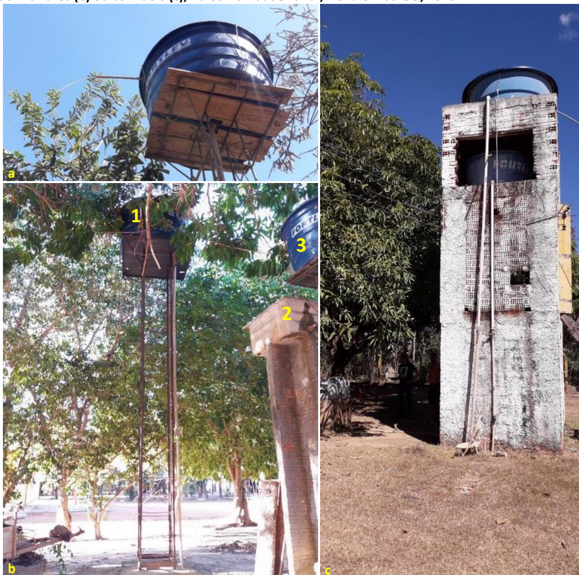
Foto 6.4 – Reservatório domiciliar dotado de extravasor (a) e domicílio com três reservatórios domiciliares (b) ou com dois (c), na Comunidade Landi, Nova Crixás-GO, 2019.
