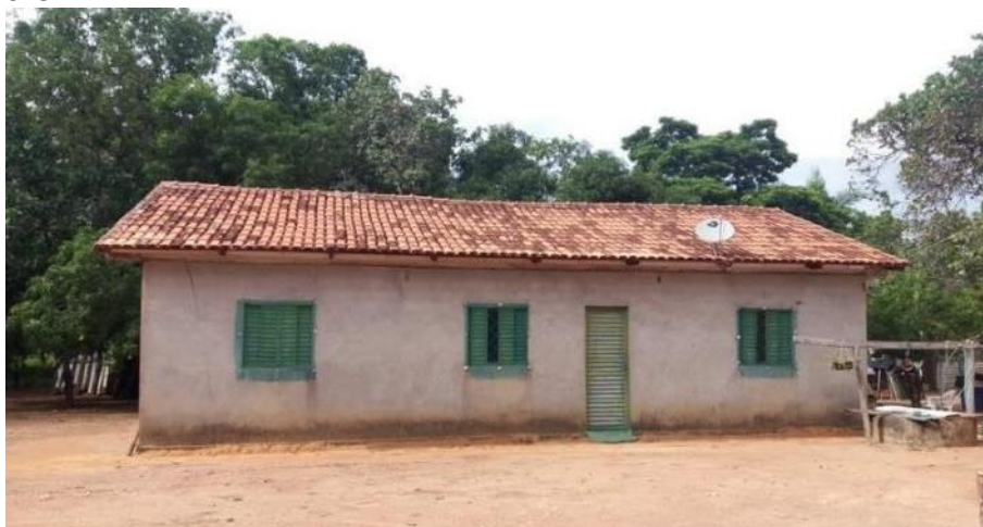
Foto 4.8 – Habitação construída de alvenaria com reboco, identificada na Comunidade Landi, Nova Crixás-GO, 2019.
