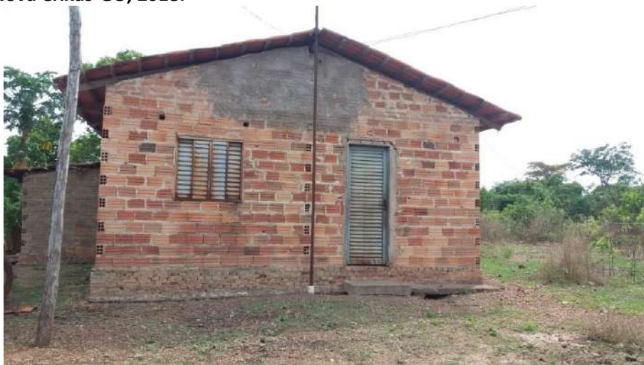
Foto 4.8 – Habitação construída de alvenaria sem reboco, identificada na Comunidade Lagoa Genipapo, Nova Crixás-GO, 2018.
