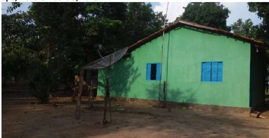
Foto 4.6 – Habitação construída de alvenaria com reboco e pintura, identificada na Comunidade Lagoa Genipapo, Nova Crixás-GO, 2018.
