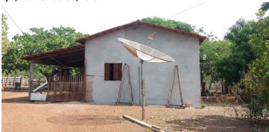
Foto 4.7 – Habitação construída de alvenaria com reboco sem pintura, identificada na Comunidade Lagoa Genipapo, Nova Crixás-GO, 2018.
