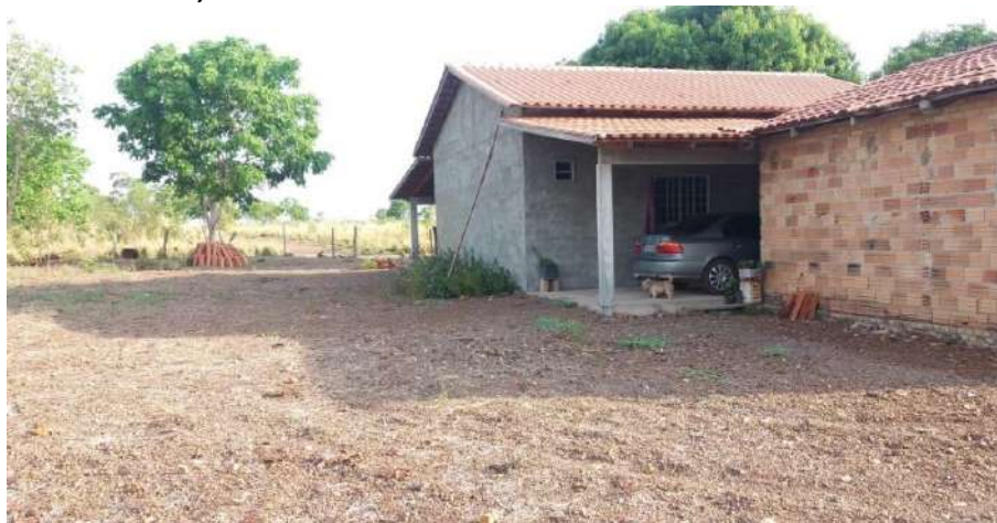
Foto 4.9 – Piso de residência constituído de concreto bruto, identificado na Comunidade Lagoa Genipapo, Nova Crixás-GO, 2018.
