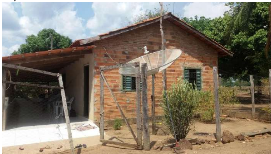
Foto 4.10 – Piso de residência constituído de cerâmica, identificado na Comunidade Lagoa Genipapo, Nova Crixás-GO, 2018.
