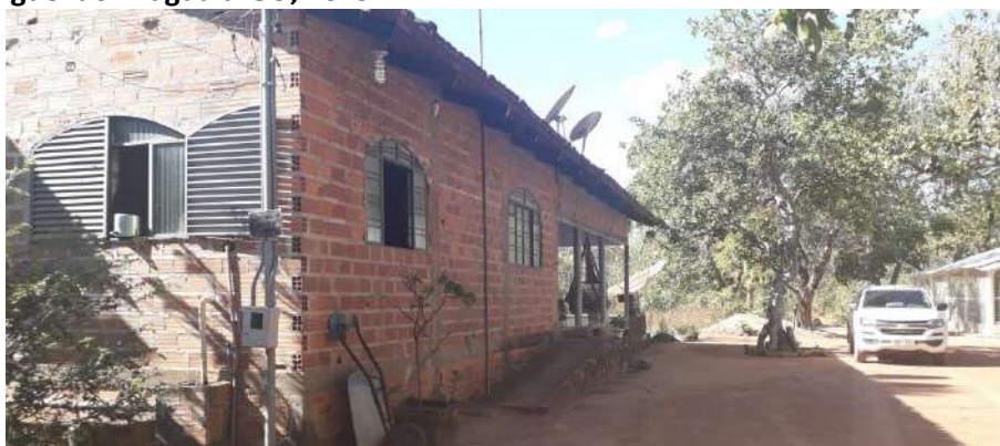
Foto 4.3 – Habitação construída de alvenaria sem reboco, identificada na Comunidade Lagoa do Lago, São Miguel do Araguaia-GO, 2019.
