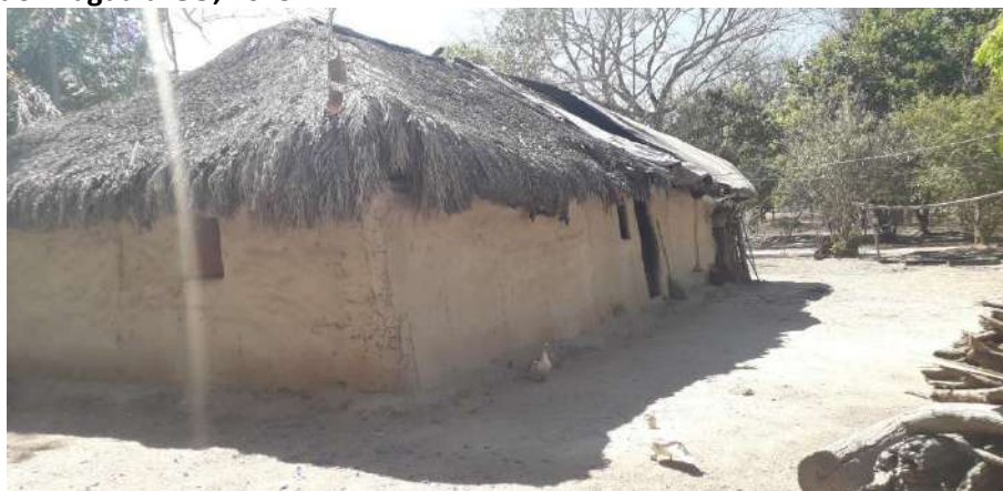
Foto 4.5 – Extensão habitacional construída de adobe, identificada na Comunidade Lagoa do Lago, São Miguel do Araguaia-GO, 2019.
