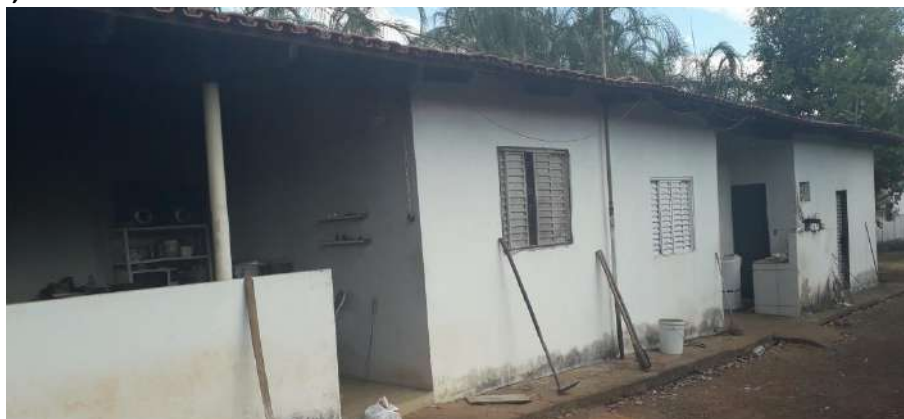
Foto 4.8 – Cobertura de telha de barro, identificada na Comunidade Lagoa do Lago, São Miguel do Araguaia-GO, 2019.
