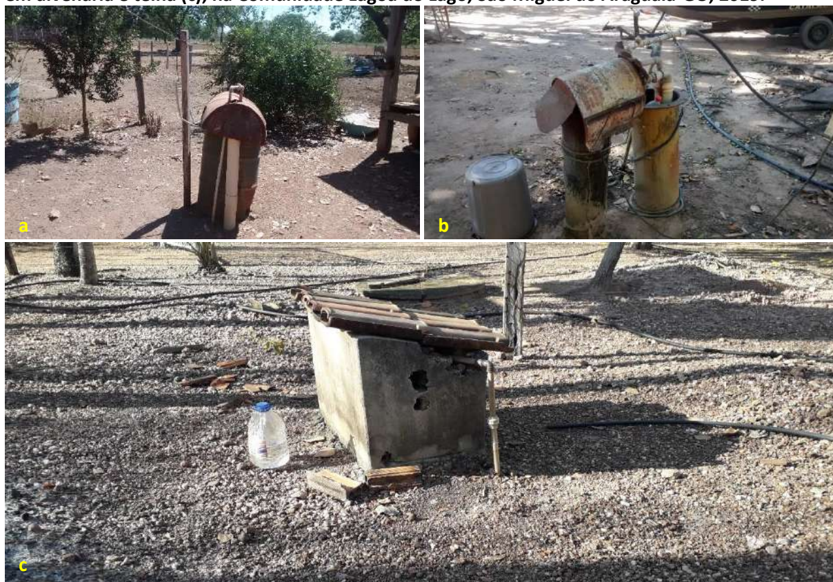
Foto 6.2 – Poço tubulares rasos protegidos por estruturas metálica (a), lata (b) e outro por estrutura em alvenaria e telha (c), na Comunidade Lagoa do Lago, São Miguel do Araguaia-GO, 2019.
