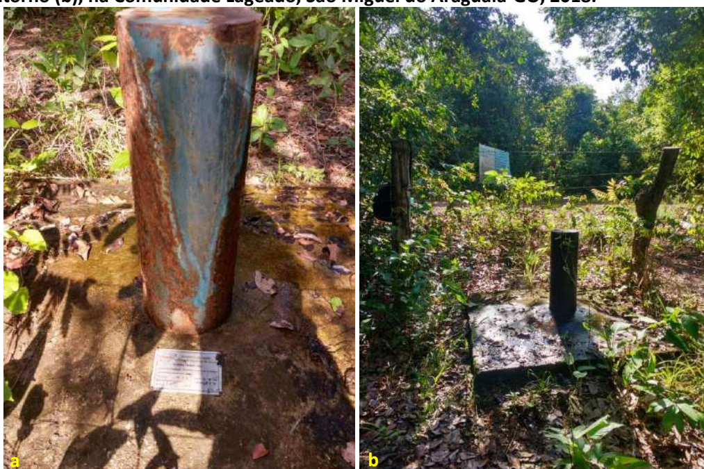
Foto 6.2 – Poço tubular profundo inativo (a), cercado com cerca e com calçamento de concreto no seu contorno (b), na Comunidade Lageado, São Miguel do Araguaia-GO, 2018.
