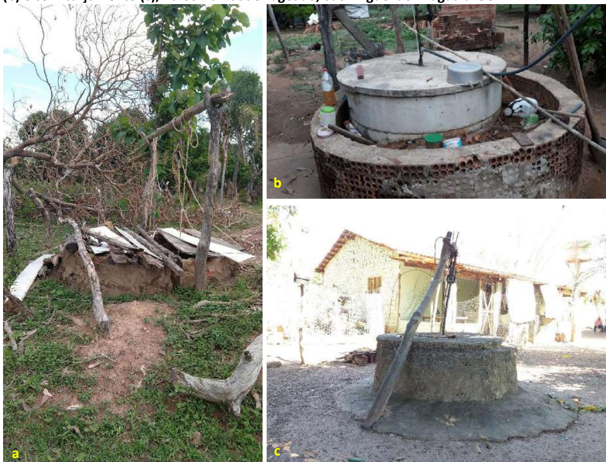
Foto 6.4 – Poço raso escavado com cobertura inadequada e cercado (a), com estrutura de alvenaria (b) e com calçamento (c), na Comunidade Lageado, São Miguel do Araguaia-GO.
