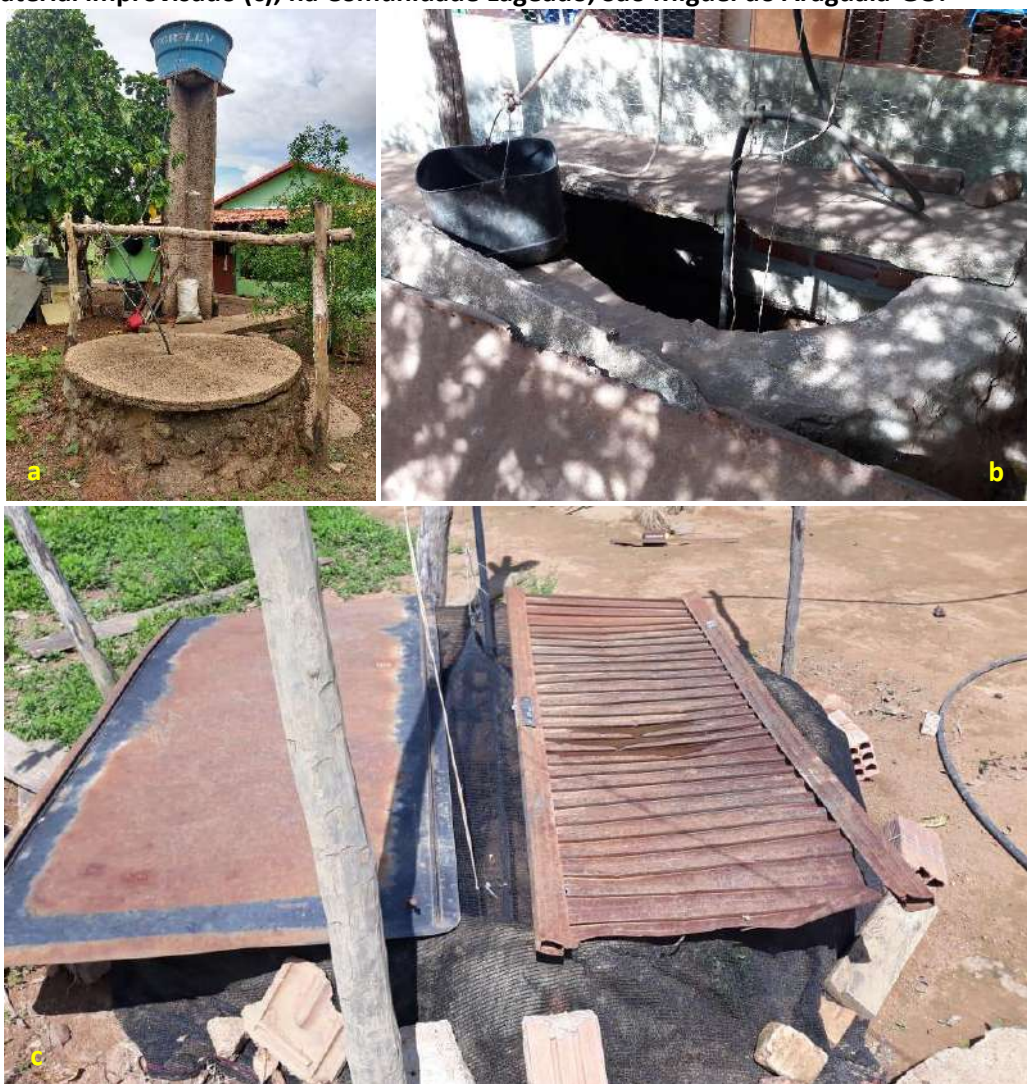
Foto 6.3 – Poço raso escavado com tampa de concreto (a), parcialmente tampado (b) ou tampado com material improvisado (c), na Comunidade Lageado, São Miguel do Araguaia-GO.
