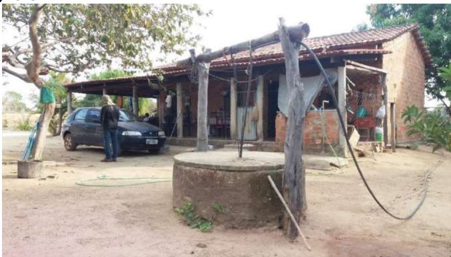
Foto 6.1 – Poço raso escavado utilizado em um domicílio da Comunidade Lageado, São Miguel do Araguaia-GO, 2018.
