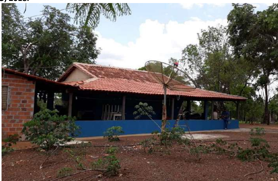
Foto 4.9 – Cobertura de telha de barro, identificada na Comunidade Lageado, São Miguel do Araguaia-GO, 2018.
