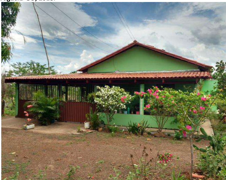
Foto 4.6 – Habitação construída com reboco e pintura, identificada na Comunidade Lageado, São Miguel do Araguaia-GO, 2018.
