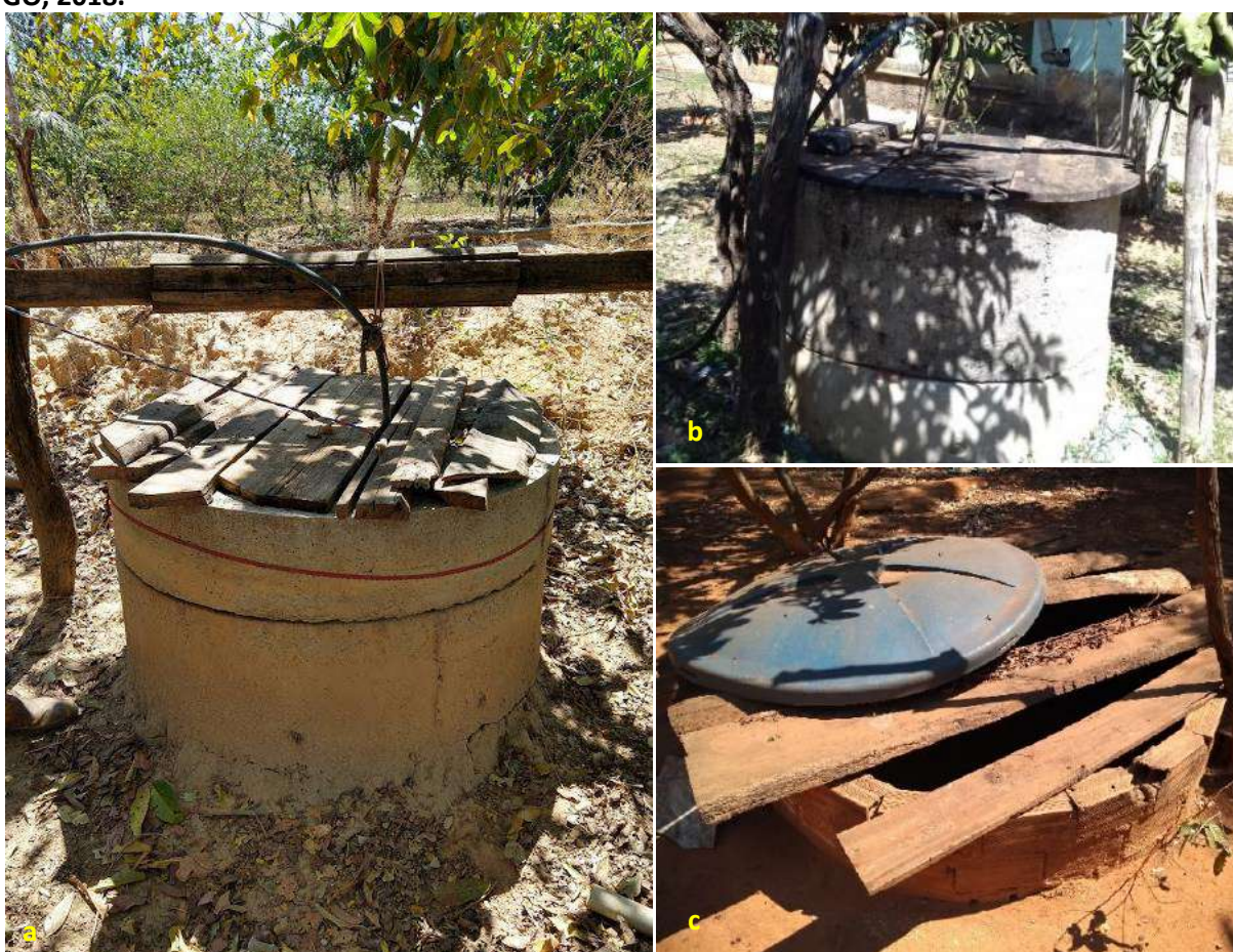
Foto 6.5 – Poço raso escavado tampado com tábuas de madeira (a), com tampa de material concreto (b) e um poço raso escavado desativado pelo morador (c), na Comunidade José Martí, Niquelândia-GO, 2018.
