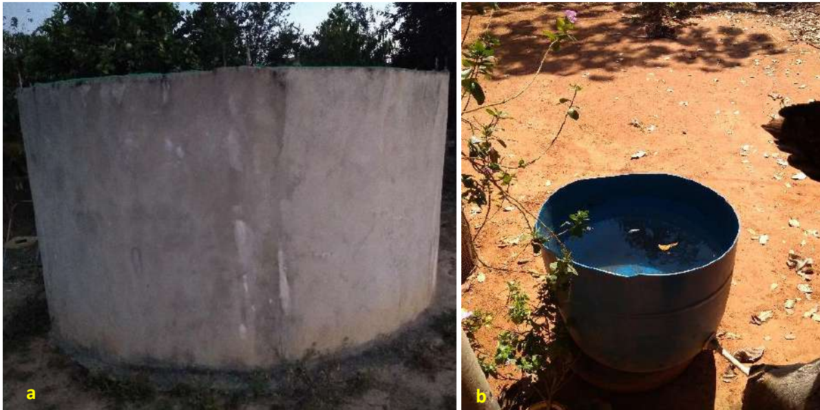
Foto 6.6 – Cisterna em concreto utilizada para armazenar água proveniente da chuva (a) e outra em parte de uma bombona de polietileno (b), na Comunidade José Martí, Niquelândia-GO, 2018.
