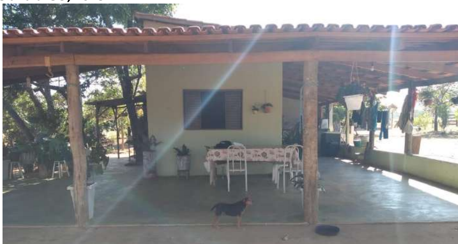
Foto 4.9 – Piso de residência constituído de cimento queimado, identificado na Comunidade José Martí, Niquelândia-GO, 2018.
