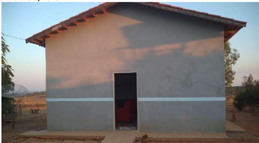
Foto 4.4 – Habitação construída de alvenaria com reboco e pintura, identificada na Comunidade José Martí, Niquelândia-GO, 2018.
