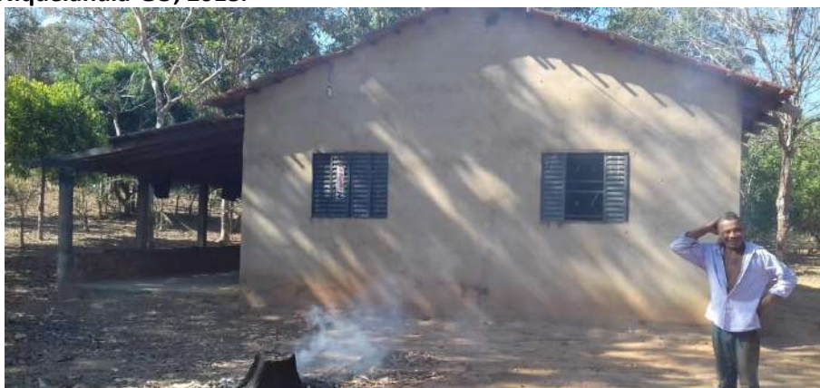
Foto 4.5 – Habitação construída de alvenaria com reboco sem pintura, identificada na Comunidade José Martí, Niquelândia-GO, 2018.
