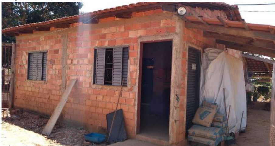
Foto 4.6 – Habitação construída de alvenaria sem reboco, identificada na Comunidade José Martí, Niquelândia-GO, 2018.
