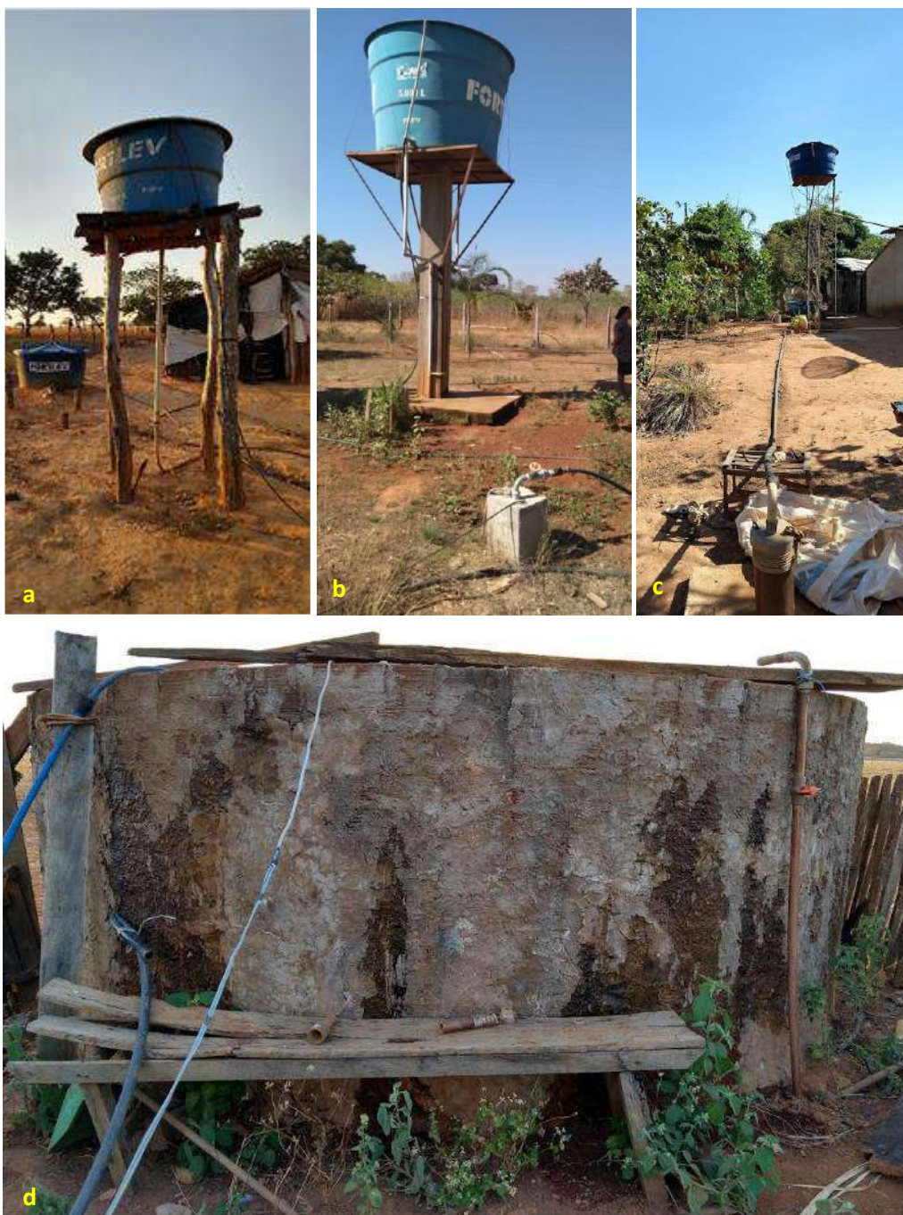
Foto 6.8 – Reservatório domiciliar instalado sobre estrutura de madeira(a), concreto (b), estrutura metálica (c) e outro apoiado diretamente no solo (d), na Comunidade José Martí, Niquelândia-GO, 2018.
