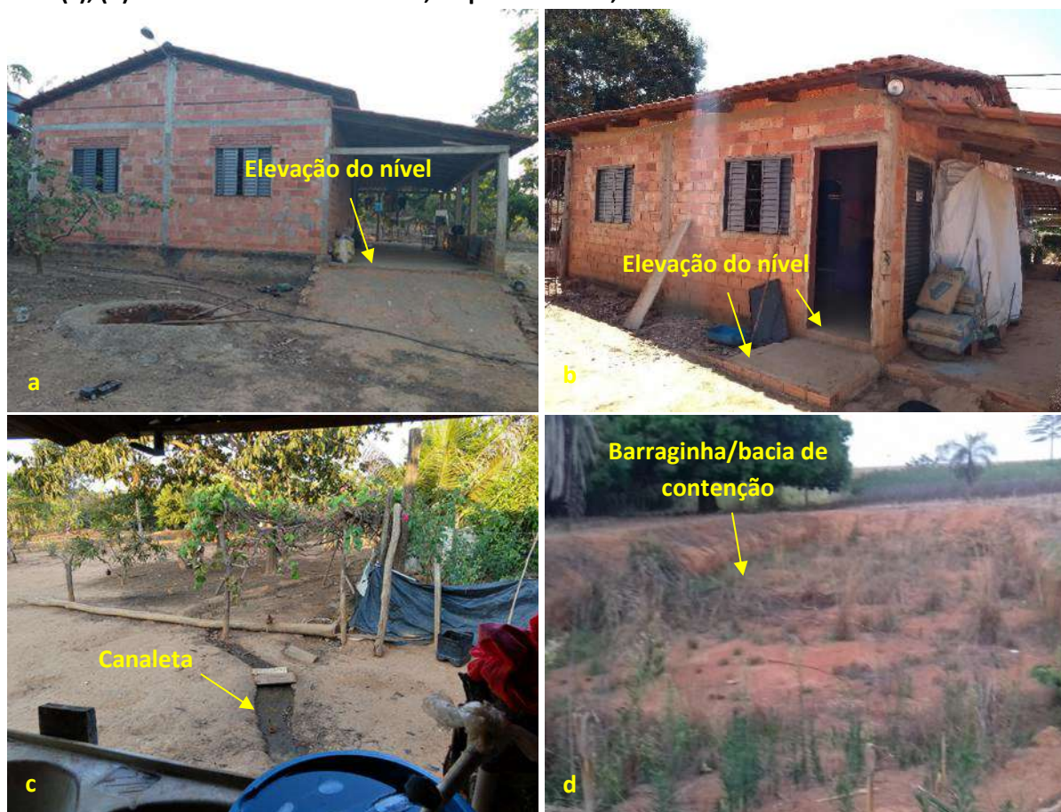
Foto 6.22 – Dispositivos de prevenção dos danos provocados pelas águas em residências (a), (b) e lotes (c), (d) da Comunidade José Martí, Niquelândia-GO, 2018.
