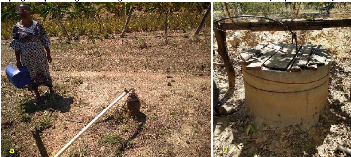
Foto 6.1 – Poço tubular profundo (a) e poço raso escavado (b) utilizados para a captação de água, empregados para a ingestão de algumas famílias da Comunidade José Martí, Niquelândia-GO, 2018.
