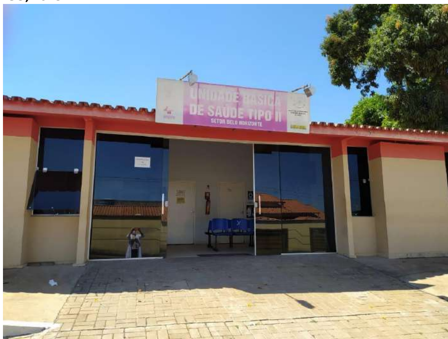
Foto 5.1 – Vista externa da UBS Tipo II Setor Belo Horizonte, referência da Comunidade José Martí, Niquelândia-GO, 2018.
