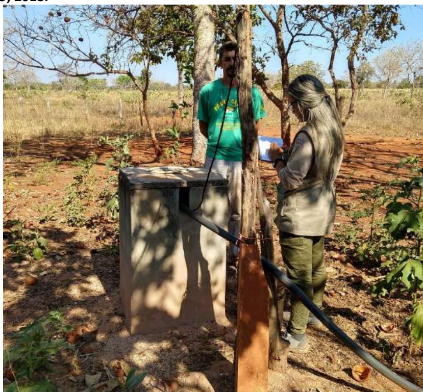
Foto 6.4 – Abrigo em alvenaria de um poço tubular profundo, ná Comunidade José Martí, Niquelândia-GO, 2018.
