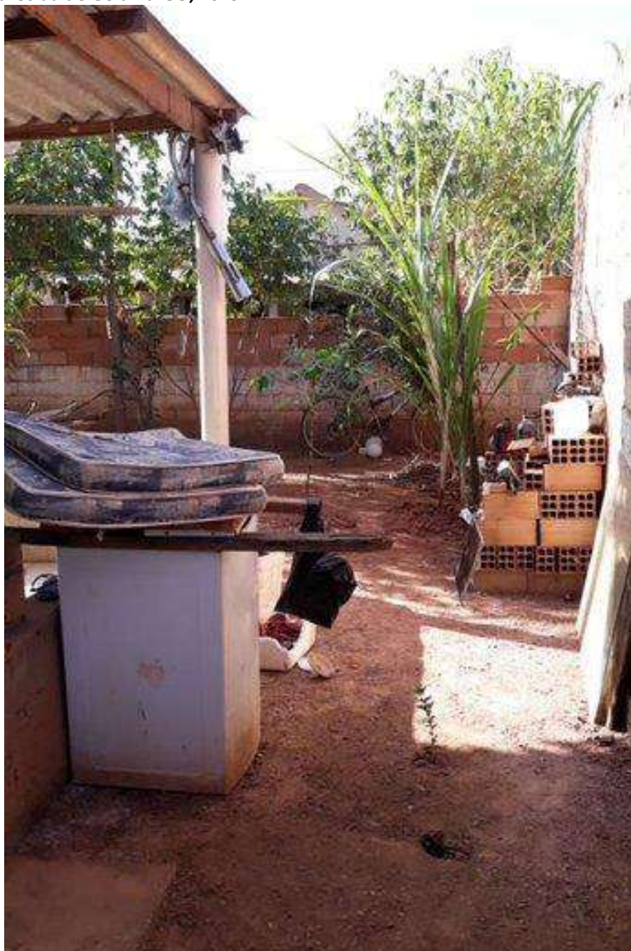
Foto 4.7 – Cobertura de telha de fibrocimento, identificada nas habitações da Comunidade de Jardim Cascata, Aparecida de Goiânia-GO, 2019.
