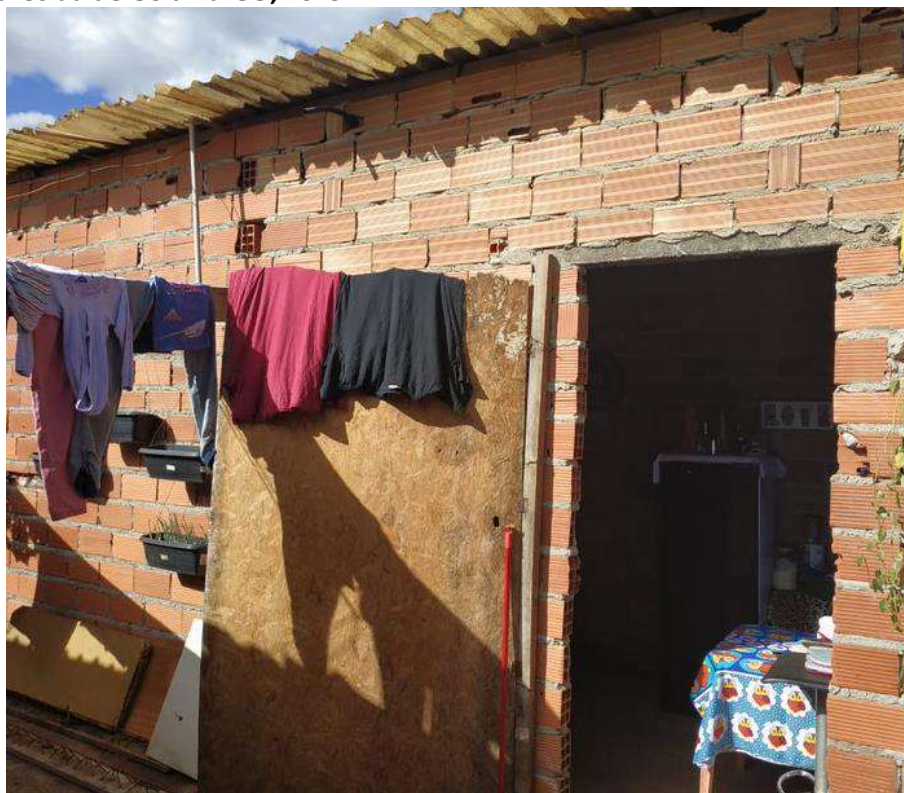
Foto 4.1 – Habitação construída de alvenaria sem reboco, identificada na Comunidade de Jardim Cascata, Aparecida de Goiânia-GO, 2019.
