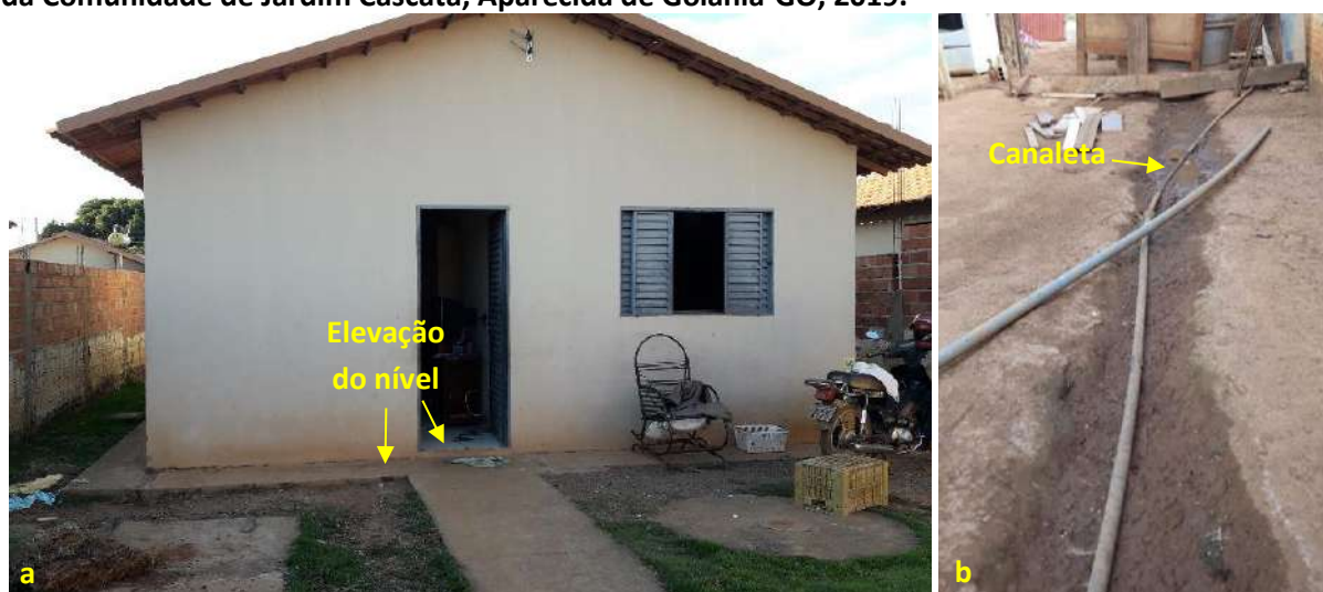
Foto 6.13 – Dispositivos de prevenção dos danos provocados pelas águas em residência (a) e lote (b) da Comunidade de Jardim Cascata, Aparecida de Goiânia-GO, 2019.
