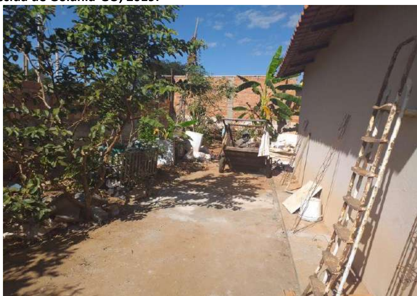
Foto 4.6 – Cobertura de telha de barro, identificada nas habitações da Comunidade de Jardim Cascata, Aparecida de Goiânia-GO, 2019.
