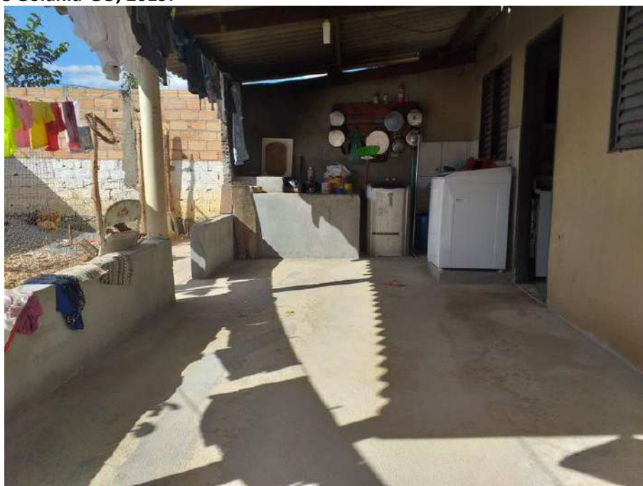
Foto 4.5 – Piso de concreto bruto, identificado nas habitações da Comunidade de Jardim Cascata, Aparecida de Goiânia-GO, 2019.
