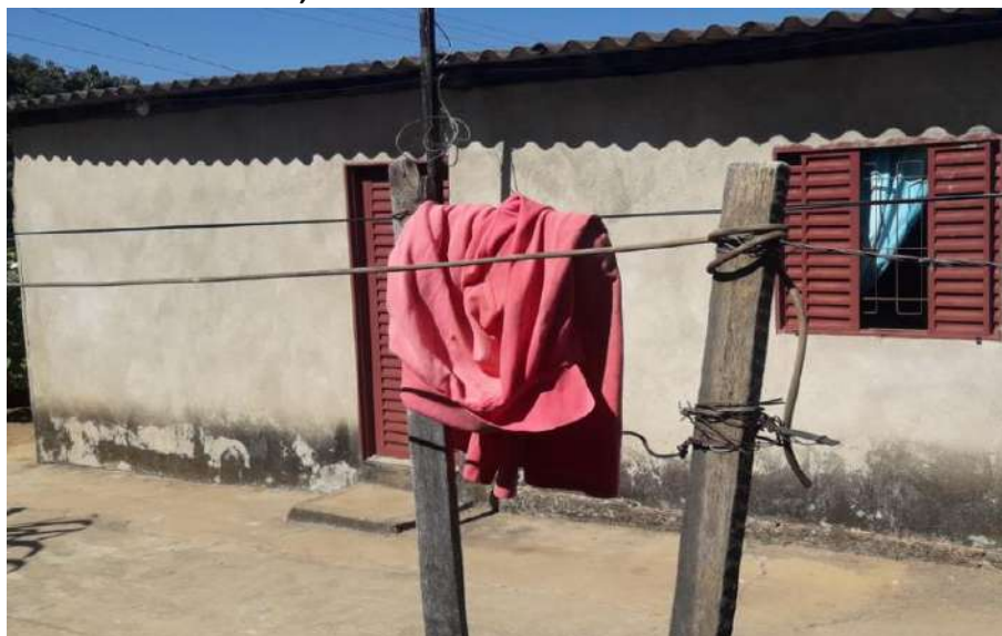
Foto 4.2 – Habitação construída de alvenaria com reboco, identificada na Comunidade de Jardim Cascata, Aparecida de Goiânia-GO, 2019.
