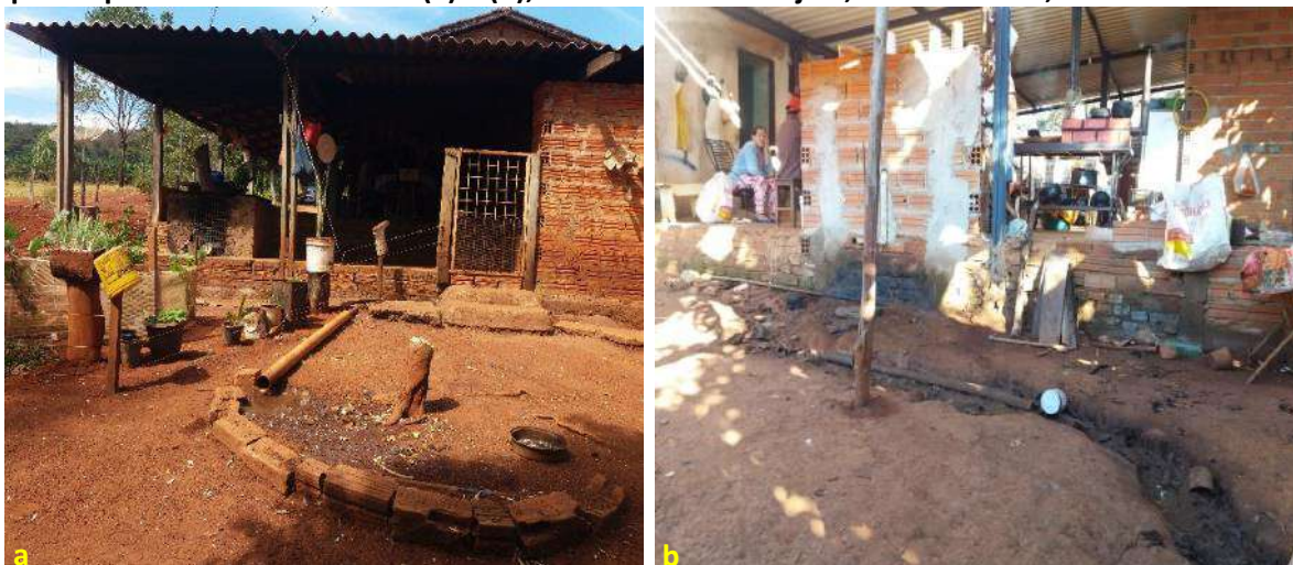
Foto 6.9 – Lançamento e acúmulo de água cinza proveniente da pia da cozinha diretamente no solo do quintal próximo aos domicílios (a) e (b), na Comunidade Itajá II, Goianésia-GO, 2018.
