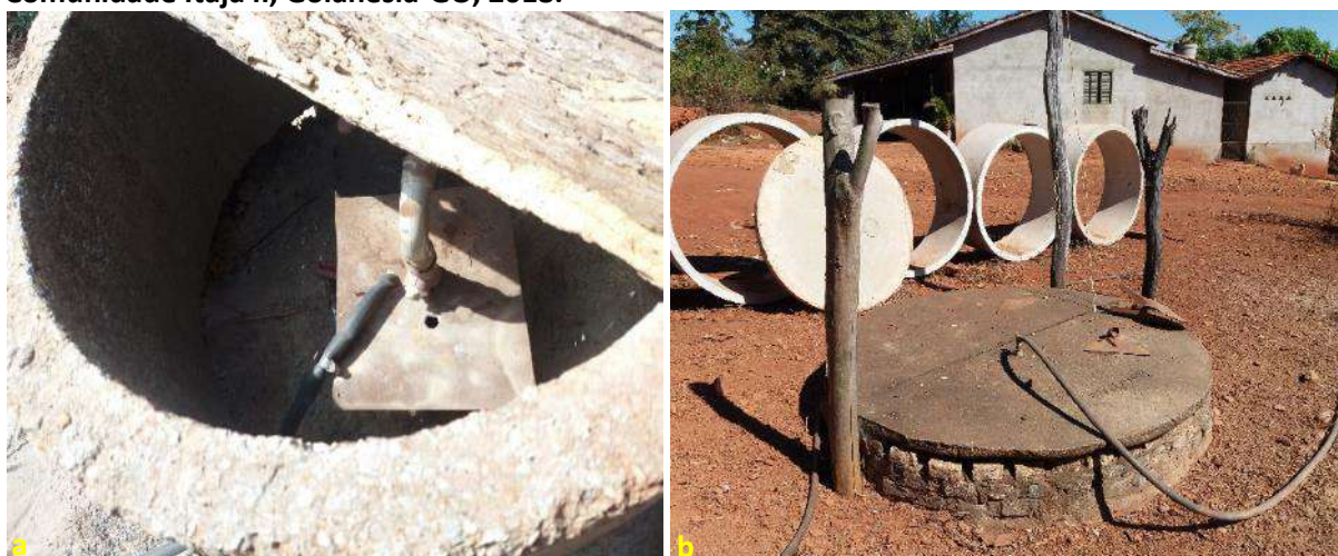
Foto 6.1 – Poço tubular profundo (a) e poço raso escavado (b) utilizados para obtenção de água na Comunidade Itajá II, Goianésia-GO, 2018.
