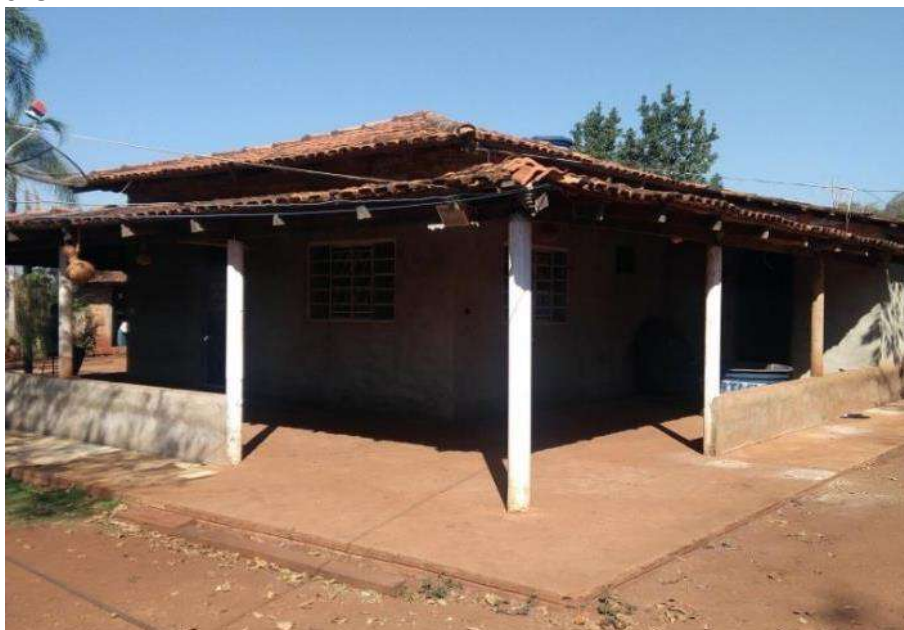
Foto 4.6 – Piso de residência constituído de concreto bruto, identificado na Comunidade Itajá II, Goianésia, 2018.
