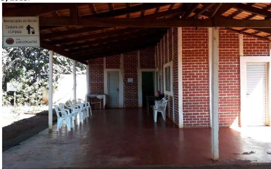
Foto 5.2 – Vista externa do núcleo Assentamento Presente de Deus “Casarão”, da Comunidade Itajá II, Goianésia-GO, 2018.
