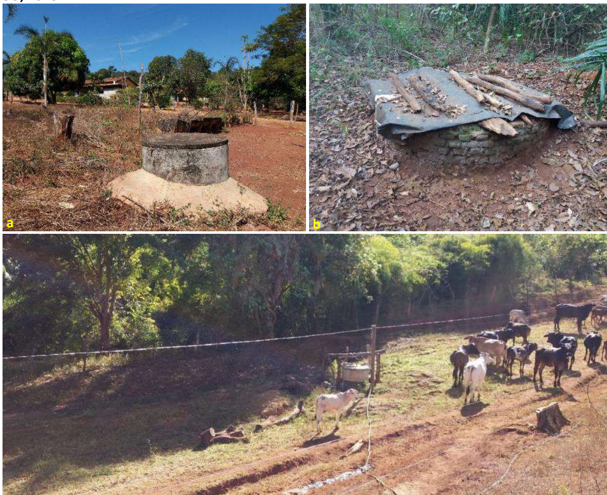
Foto 6.4 – Poços rasos escavados com tampa e mureta de proteção, com calçamento (a), ou tampado com material improvisado (b), ou com cerca de isolamento (c), na Comunidade Itajá II, Goianésia-GO, 2018.
