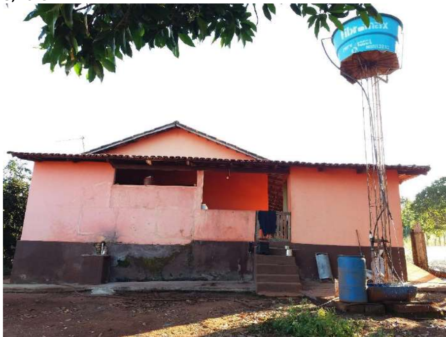
Foto 6.6 – Reservatório domiciliar de fibra de vidro com extravasor, na Comunidade Itajá II, Goianésia-GO, 2018.
