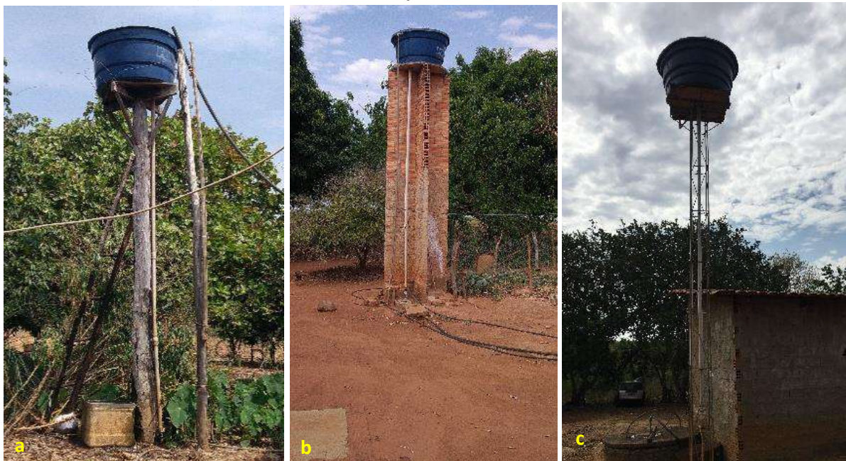
Foto 6.7 – Reservatórios domiciliares instalados sobre estrutura: em madeira (a), em alvenaria (b) e em estrutura metálica (c), na Comunidade Independência, Santa Rita do Novo Destino-GO, 2018.
