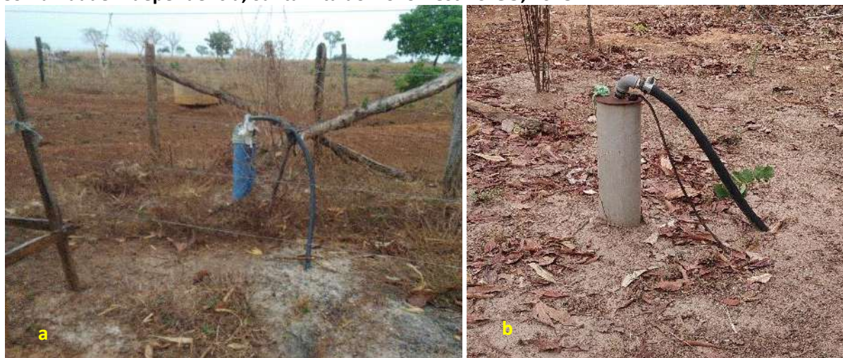
Foto 6.2 – Poço tubular profundo com cerca de proteção (a) e sem dispositivos de proteção (b), na Comunidade Independência, Santa Rita do Novo Destino-GO, 2018.
