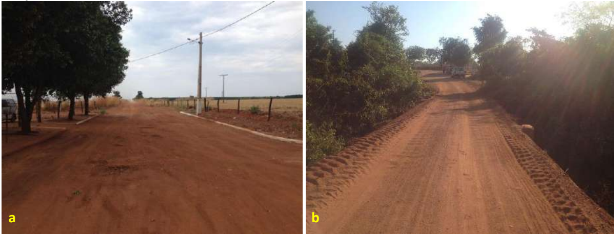
Foto 6.18 – Via não pavimentada (a) e ponte sobre fundo de vale (b) na via de acesso à Comunidade Independência, Santa Rita do Novo Destino-GO, 2018.
