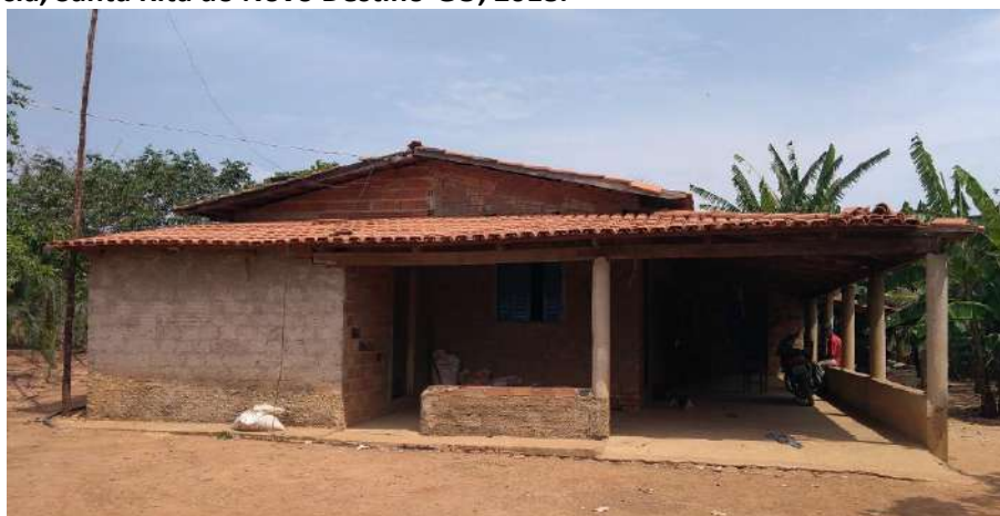
Foto 4.7 – Piso de residência constituído de concreto bruto, identificado na Comunidade Independência, Santa Rita do Novo Destino-GO, 2018.
