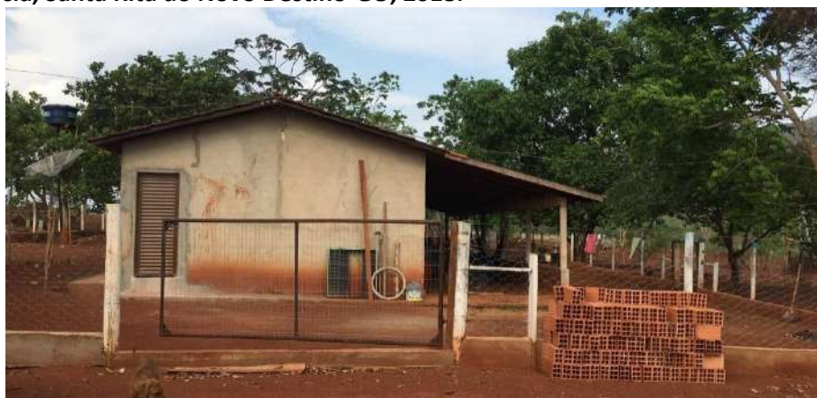
Foto 4.5 – Habitação construída de alvenaria com reboco sem pintura, identificada na Comunidade Independência, Santa Rita do Novo Destino-GO, 2018.
