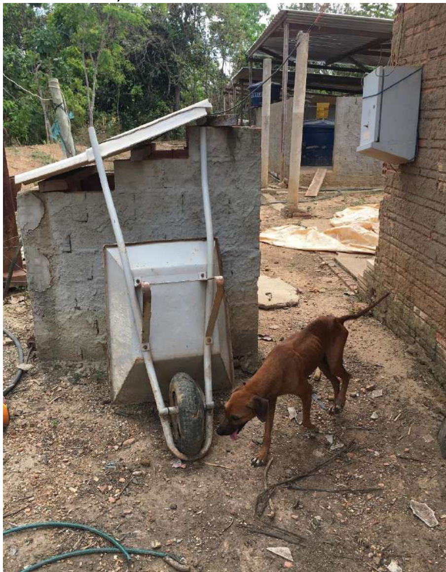
Foto 6.4 – Abrigo em alvenaria para proteção do poço tubular raso, na Comunidade Independência, Santa Rita do Novo Destino-GO, 2018.
