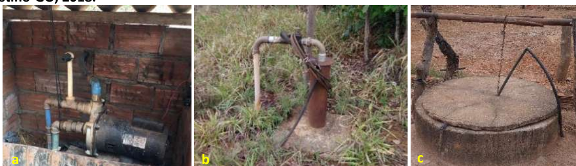
Foto 6.1 – Fontes de abastecimento de água utilizadas para ingestão: poço tubular raso (a); poço tubular profundo (b); poço raso escavado (c), na Comunidade Independência, Santa Rita do Novo Destino-GO, 2018.
