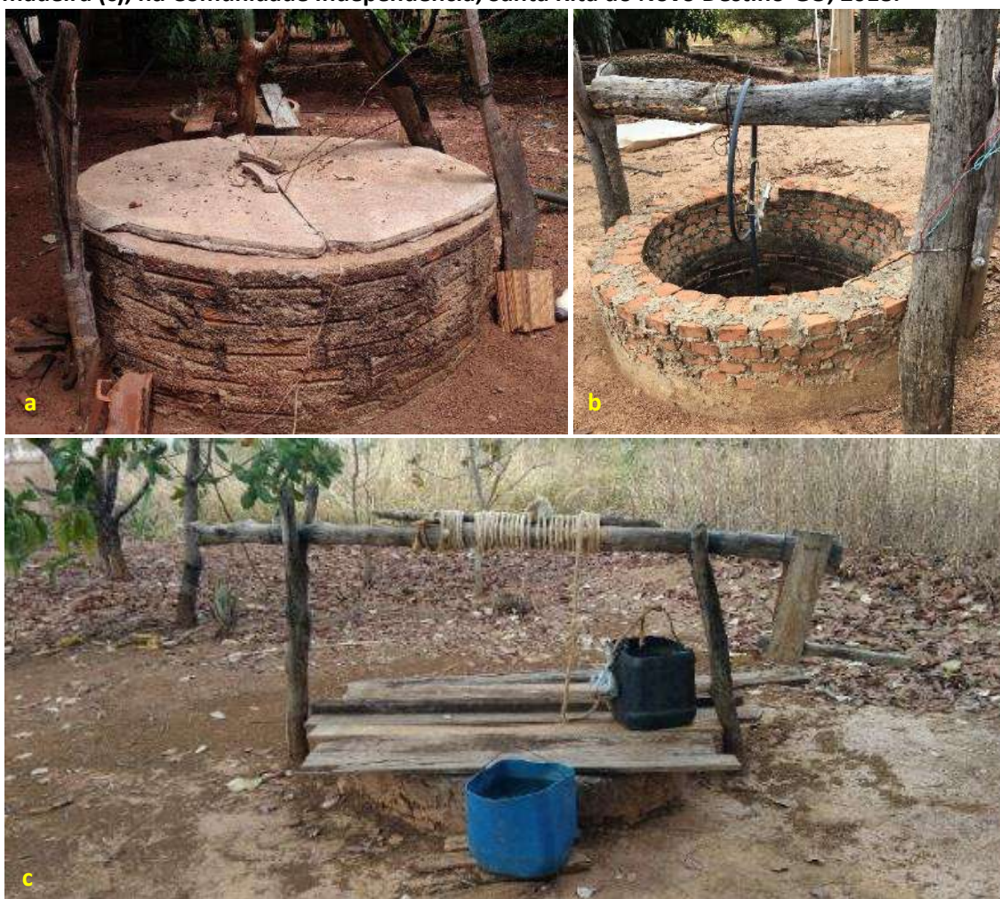
Foto 6.3 – Poço raso escavado: com tampa de concreto (a), destampado (b) e tampado com tábuas de madeira (c), na Comunidade Independência, Santa Rita do Novo Destino-GO, 2018.
