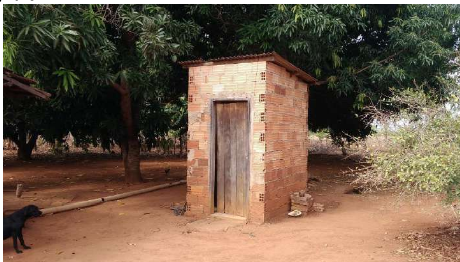
Foto 4.3 – Banheiro externo identificado na Comunidade Independência, Santa Rita do Novo Destino-GO, 2018.
