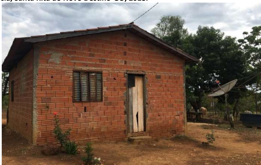
Foto 4.6 – Habitação construída de alvenaria sem reboco, identificada na Comunidade Independência, Santa Rita do Novo Destino-GO, 2018.
