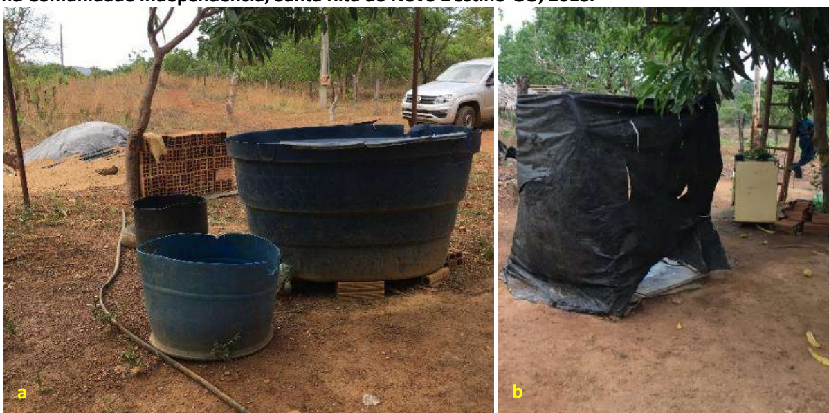
Foto 6.5 – Estruturas nos domicílios sem canalização interna, com reservatório domiciliar (caixa d'água) utilizada para armazenar a água para usos diversos (a) e local para banho fora da casa (b), na Comunidade Independência, Santa Rita do Novo Destino-GO, 2018.
