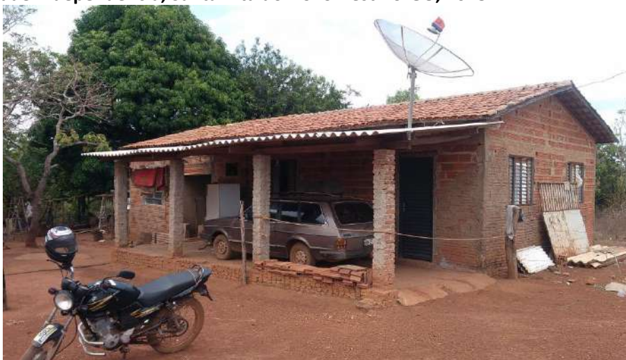
Foto 4.11 – Habitação com cobertura de fibrocimento em associação com telha de barro, identificada na Comunidade Independência, Santa Rita do Novo Destino-GO, 2018.
