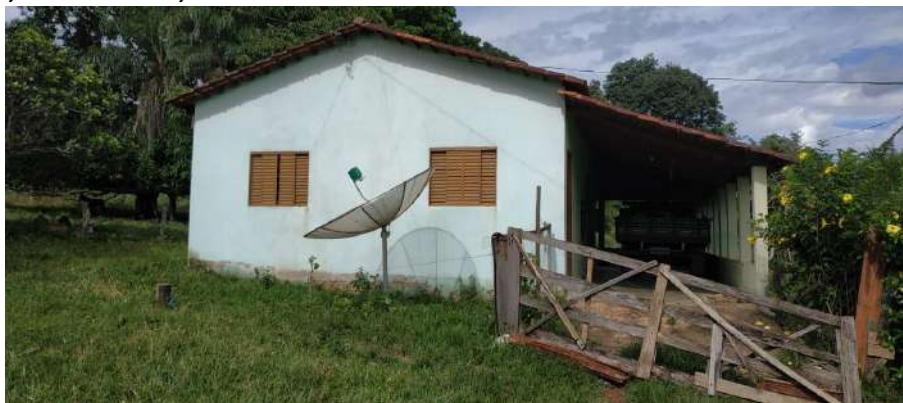
Foto 4.4 – Habitação construída de alvenaria com reboco e pintura, identificada na Comunidade Formiguinha, Mineiros-GO, 2019.
