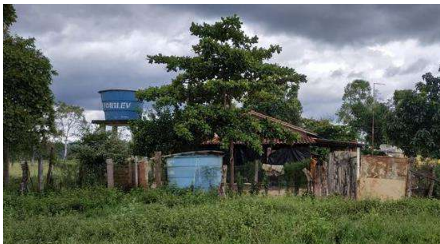
Foto 6.4 – Unidade familiar dotada de dois reservatórios, na Comunidade Formiguinha, Mineiros-GO, 2019.
