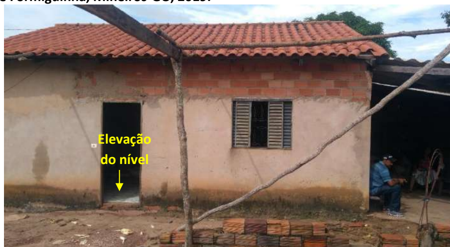
Foto 6.19 – Dispositivo de prevenção dos danos provocados pelas águas em residência da Comunidade Formiguinha, Mineiros-GO, 2019.
