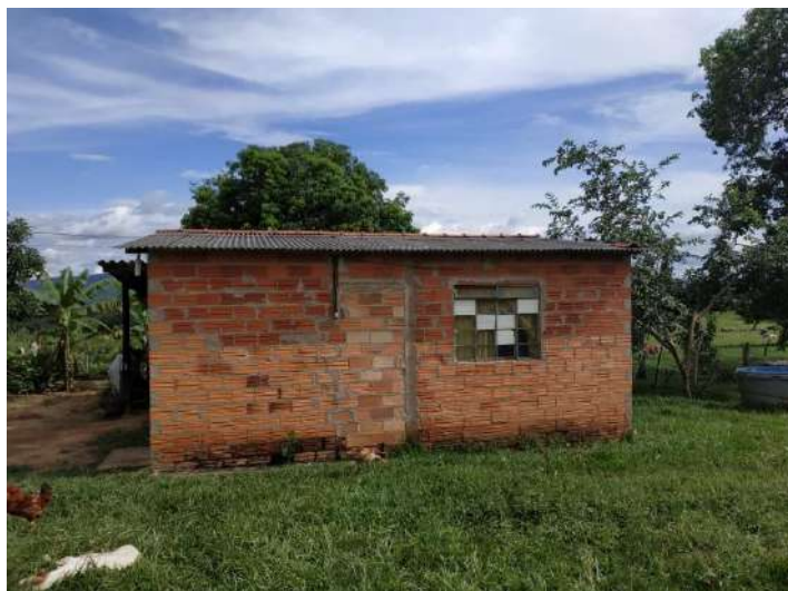
Foto 4.6 – Habitação construída de alvenaria sem reboco, identificada na Comunidade Formiguinha, Mineiros-GO, 2019.
