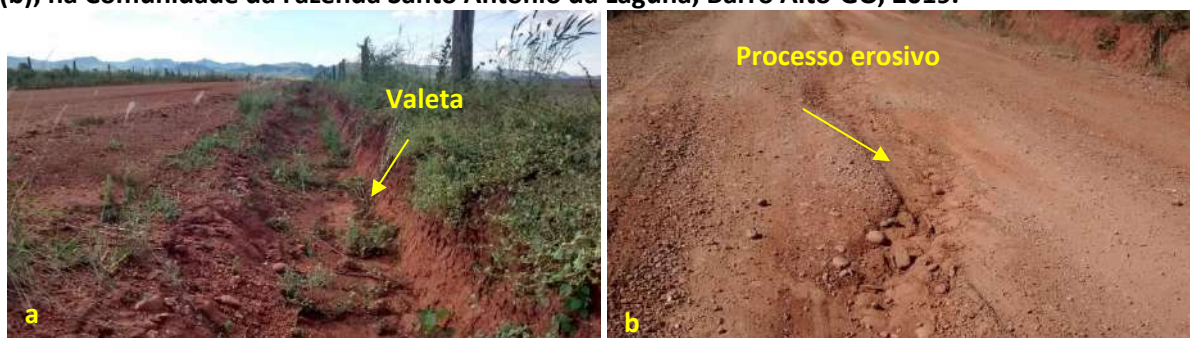
Foto 6.20 – Situação da drenagem pluvial na via de acesso: valeta de infiltração (a) e processo erosivo (b), na Comunidade da Fazenda Santo Antônio da Laguna, Barro Alto-GO, 2019.
