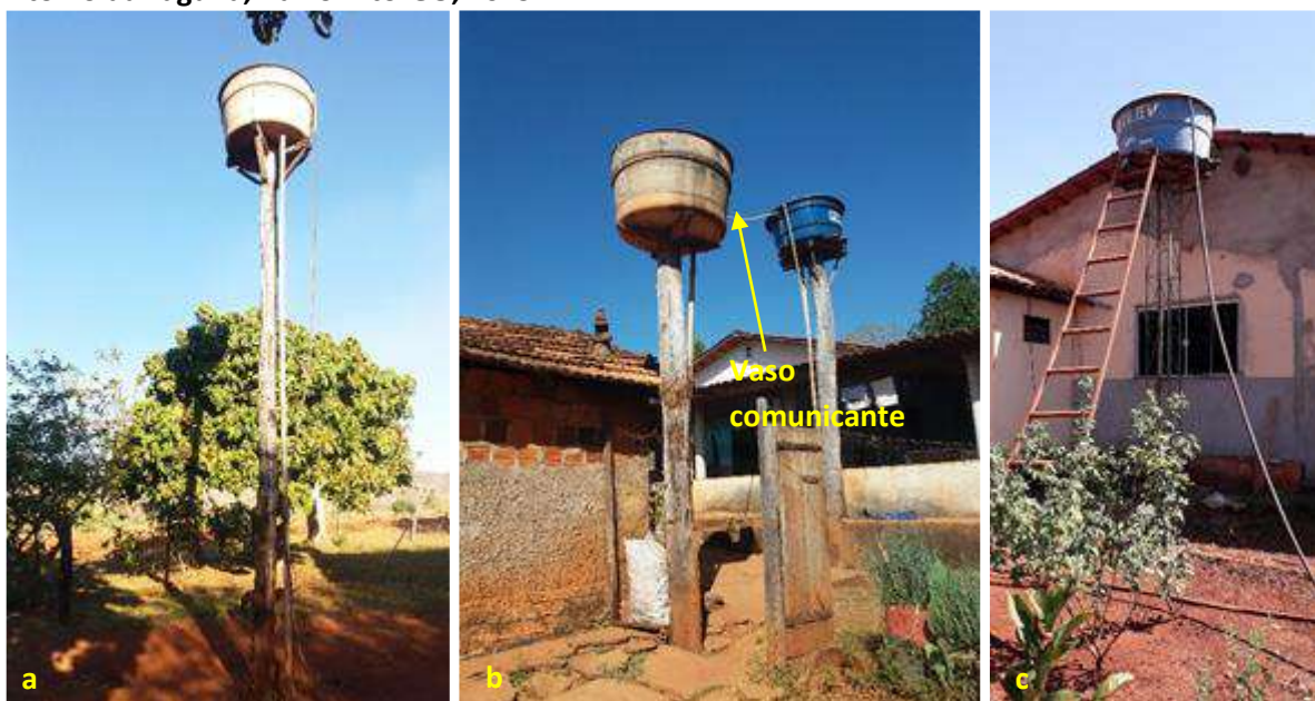
Foto 6.7 – Reservatórios domiciliares suspensos, tampados, de fibrocimento (a), de fibrocimento e polietileno, com vaso comunicante (b) e de fibra de vidro (c), na Comunidade da Fazenda Santo Antônio da Laguna, Barro Alto-GO, 2019.
