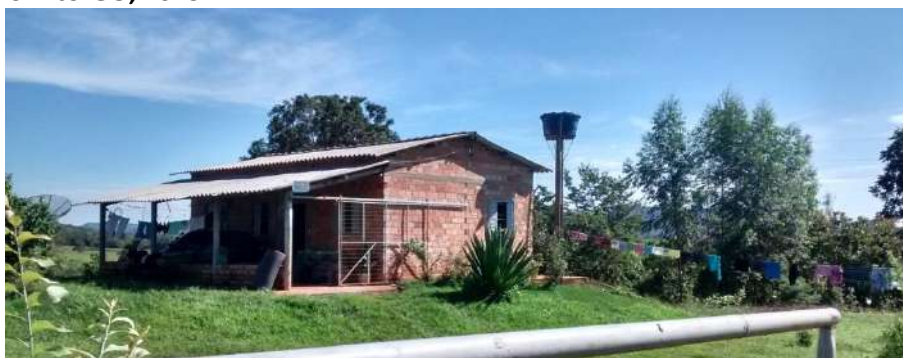
Foto 4.17 – Cobertura de fibrocimento identificada na Comunidade da Fazenda Santo Antônio da Laguna, Barro Alto-GO, 2019.
