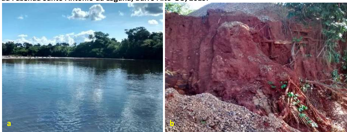
Foto 6.21 – Rio Maranhão (a) e processo erosivo às margens do rio Maranhão (b), na Comunidade da Fazenda Santo Antônio da Laguna, Barro Alto-GO, 2019.
