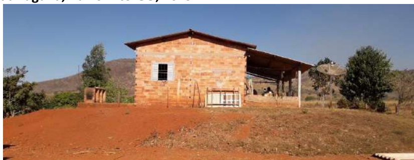
Foto 4.11 – Habitação construída de alvenaria sem reboco, identificada na Comunidade da Fazenda Santo Antônio da Laguna, Barro Alto-GO, 2019.
