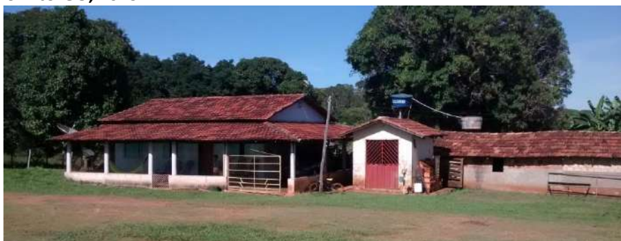
Foto 4.16 – Cobertura de telha de barro identificada na Comunidade da Fazenda Santo Antônio da Laguna, Barro Alto-GO, 2019.
