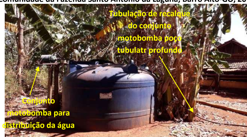
Foto 6.9 – Reservatório em polietileno de 10m 3 , utilizado para armazenar água do poço tubular profundo, na Comunidade da Fazenda Santo Antônio da Laguna, Barro Alto-GO, 2019.
