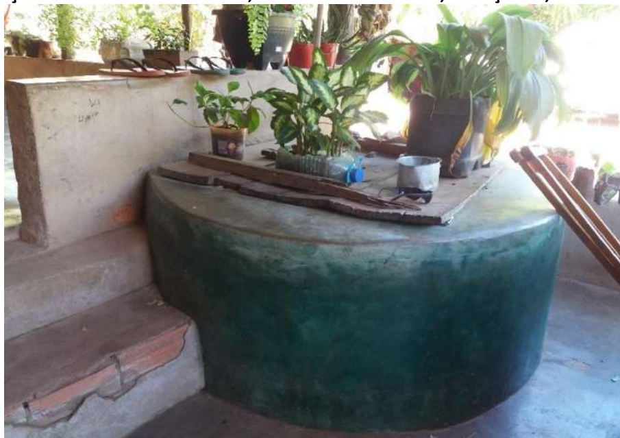
Foto 6.6 – Poço raso escavado desativado, Comunidade Céu Azul, Minaçu-GO, 2018.
