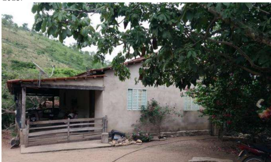
Foto 4.6 – Habitação construída de alvenaria com reboco, identificada na Comunidade Céu Azul, Minaçu-GO, 2018.
