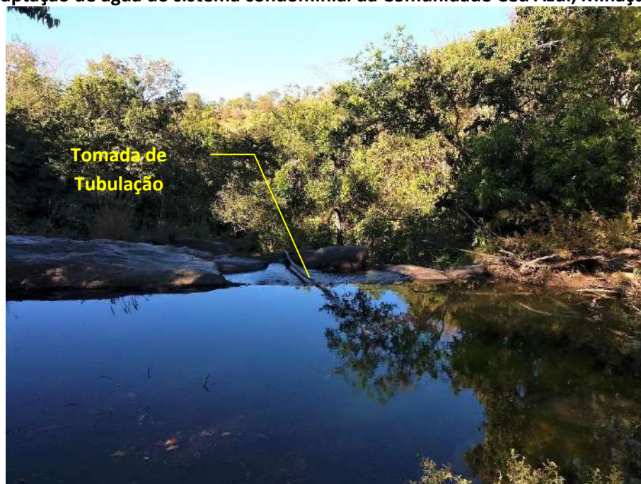
Foto 6.2 – Captação de água do sistema condominial da Comunidade Céu Azul, Minaçu-GO, 2018.
