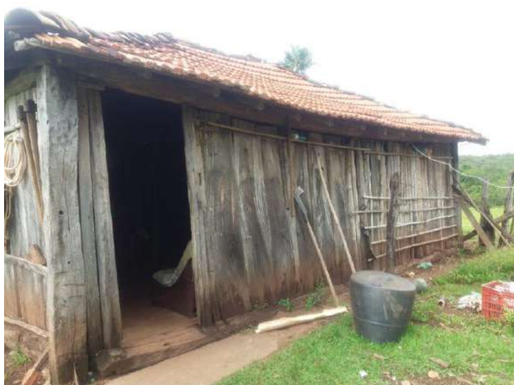
Foto 4.4 – Cobertura de telha de barro, identificada na Comunidade de Buracão, Mineiros-GO, 2019.
