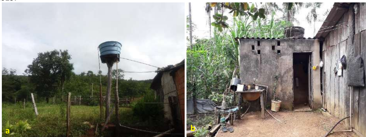
Foto 6.4 – Reservatório de fibra em vidro instalado sobre estrutura de madeira (a), Reservatório de fibrocimento instalado sobre estrutura de alvenaria (b), Comunidade de Buracão, Mineiros-GO, 2019.
