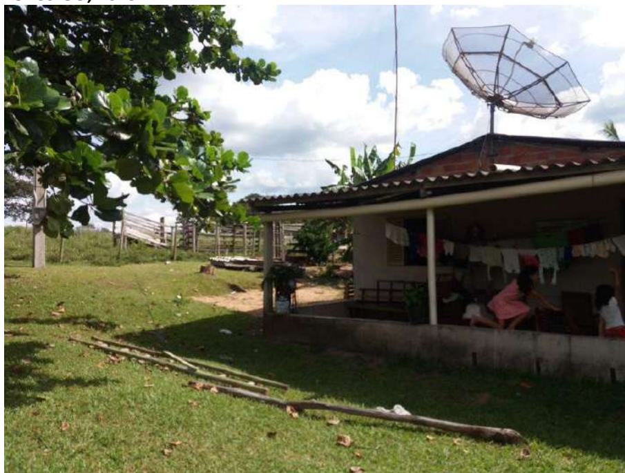
Foto 4.2 – Habitação construída de alvenaria com e sem reboco, identificada na Comunidade de Buracão, Mineiros-GO, 2019.
