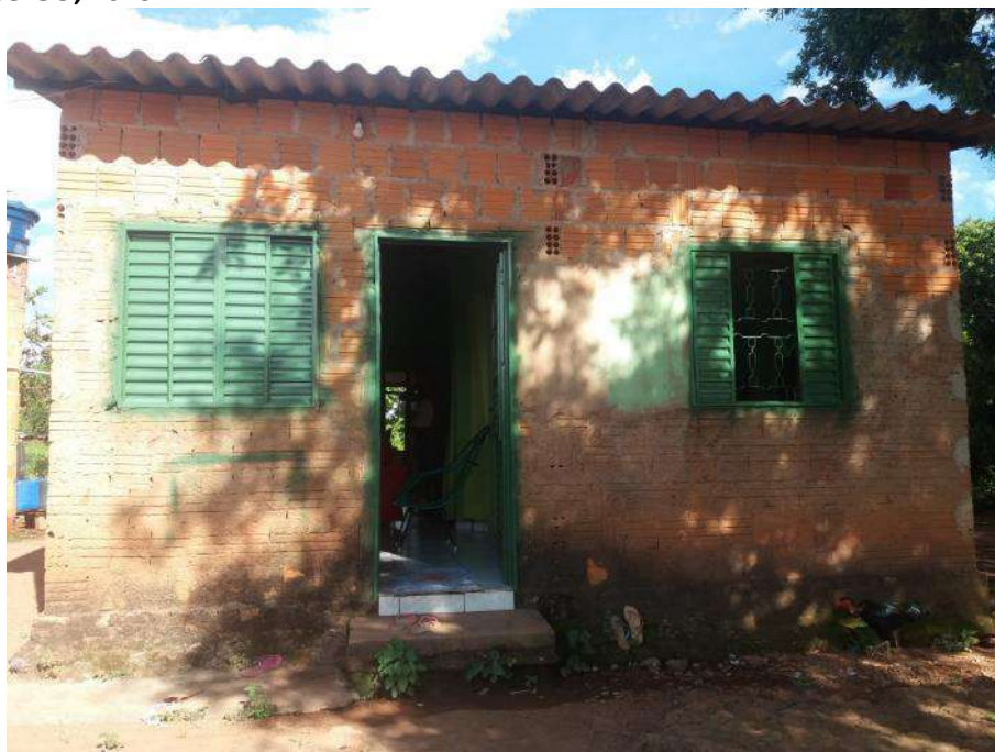
Foto 4.10 – Habitação construída de alvenaria sem reboco, identificada na Comunidade de Baco Pari, Iaciara/Posse-GO, 2019.
