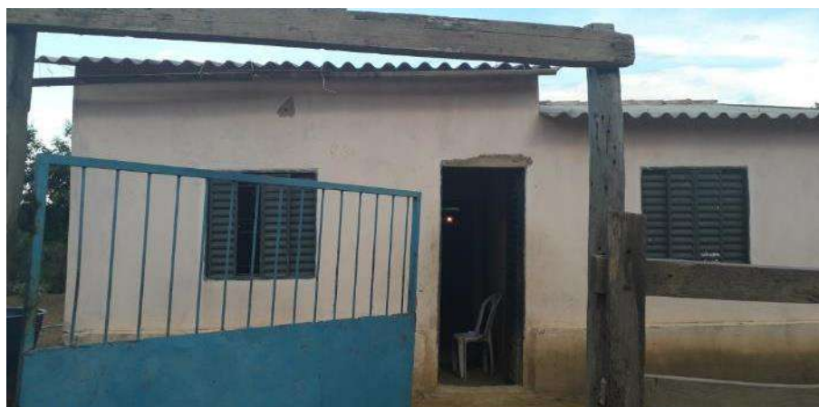
Foto 4.16 – Cobertura do tipo fibrocimento, identificada na Comunidade de Baco Pari, Iaciara/Posse-GO, 2019.
