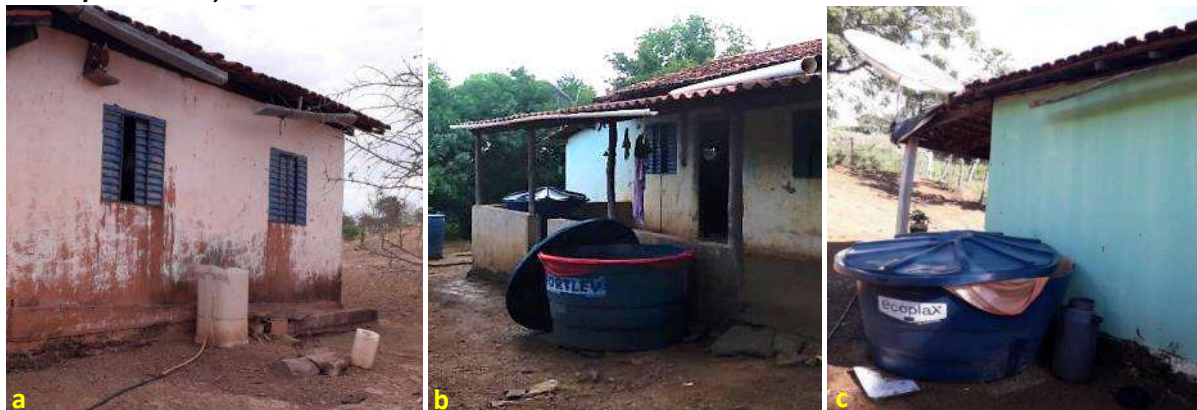
Foto 6.7 – Aproveitamento de forma improvisada de água de chuva na Comunidade de Baco Pari, Iaciara/Posse-GO, 2019.
