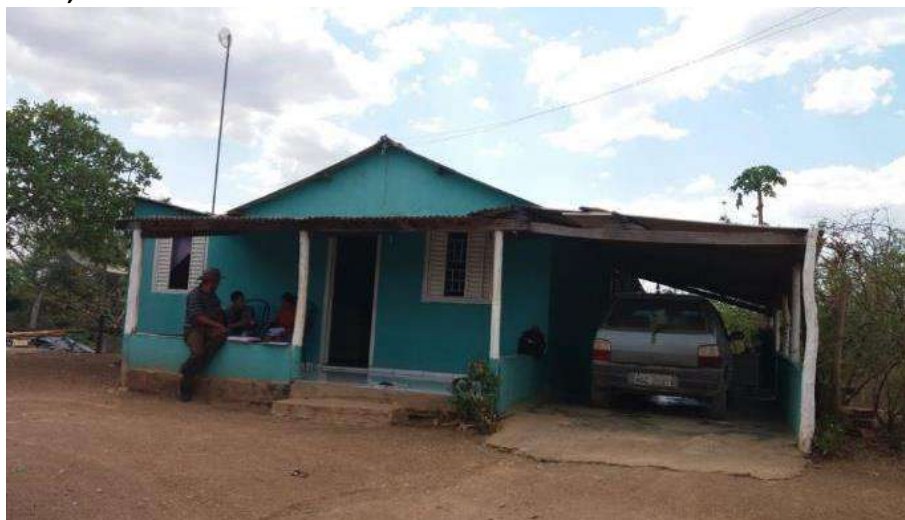
Foto 4.14 – Piso de residência constituído de cerâmica, identificado na Comunidade de Baco Pari, Iaciara/Posse-GO, 2019.
