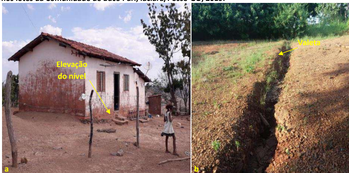
Foto 6.23 – Dispositivos de prevenção dos danos provocados pelas águas (a) nas residências e (b) nos lotes da Comunidade de Baco Pari, Iaciara/Posse-GO, 2019.
