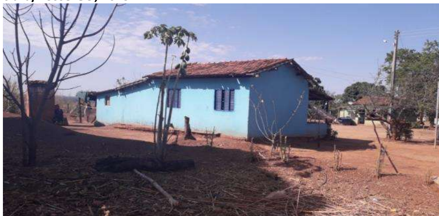
Foto 4.11 – Habitação construída de alvenaria com reboco e pintura, identificada na Comunidade de Baco Pari, Iaciara/Posse-GO, 2019.
