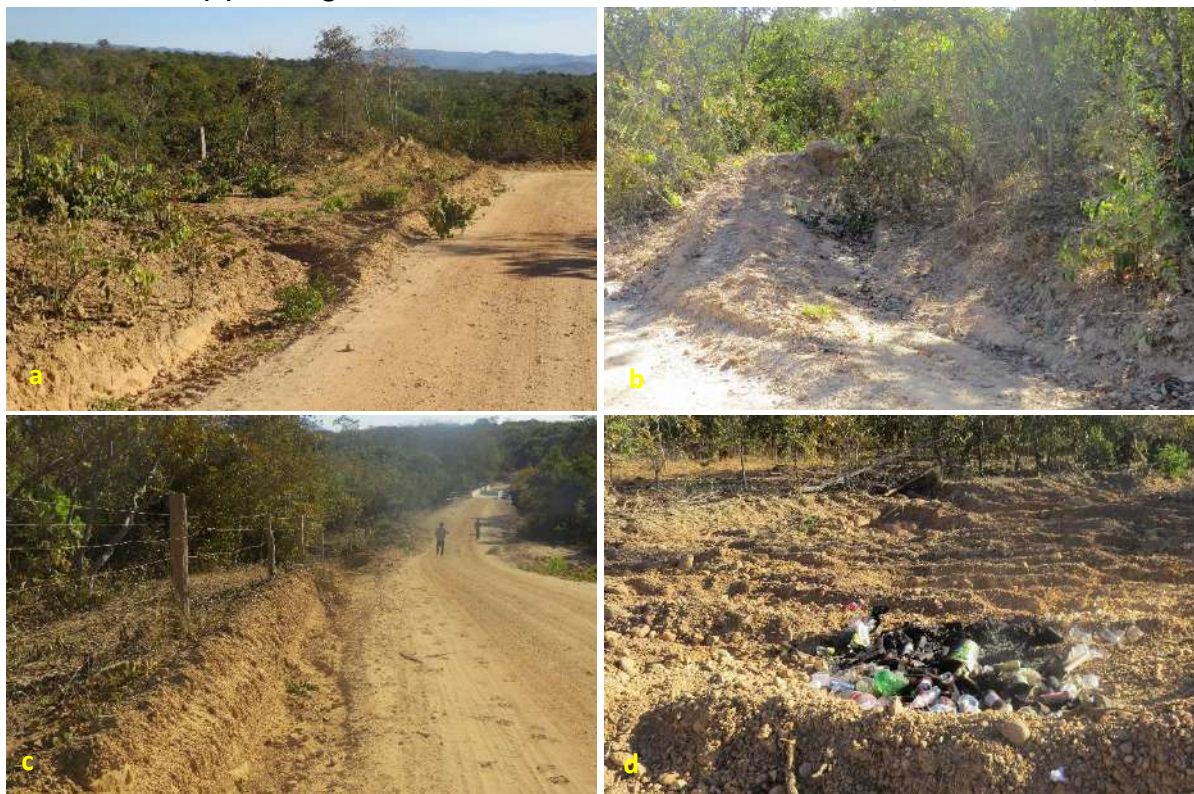
Foto 6.17 – Valas de infiltração em bom estado (a) e (b), vala erodida (c) e ponto de deposição de resíduos sólidos (d) às margens da via de acesso à Comunidade Abobreira, Nova Roma-GO, 2018.
