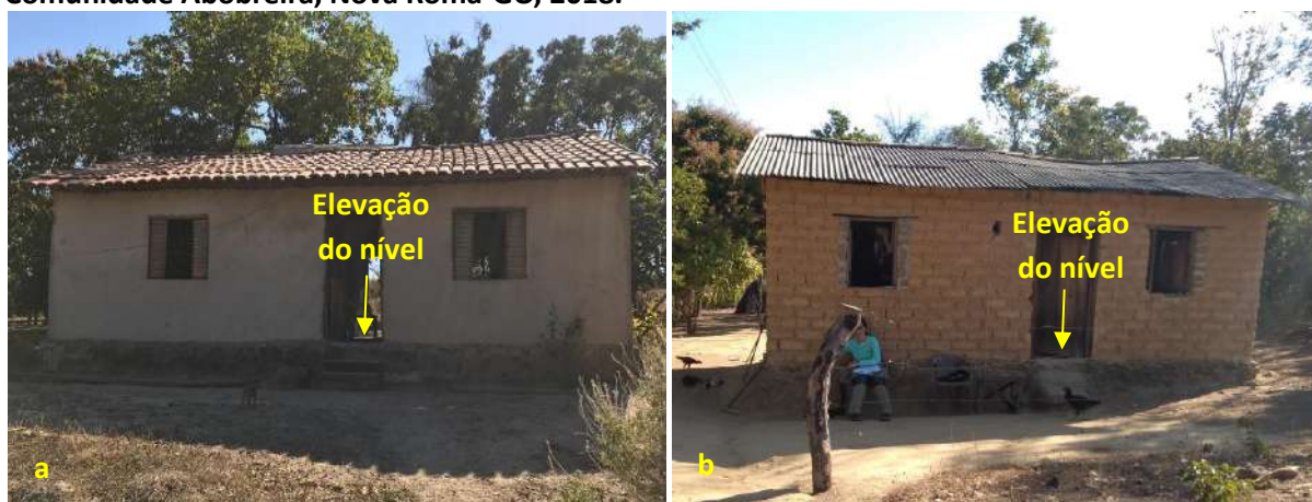
Foto 6.19 – Dispositivos de prevenção dos danos provocados pelas águas em residências da Comunidade Abobreira, Nova Roma-GO, 2018.
