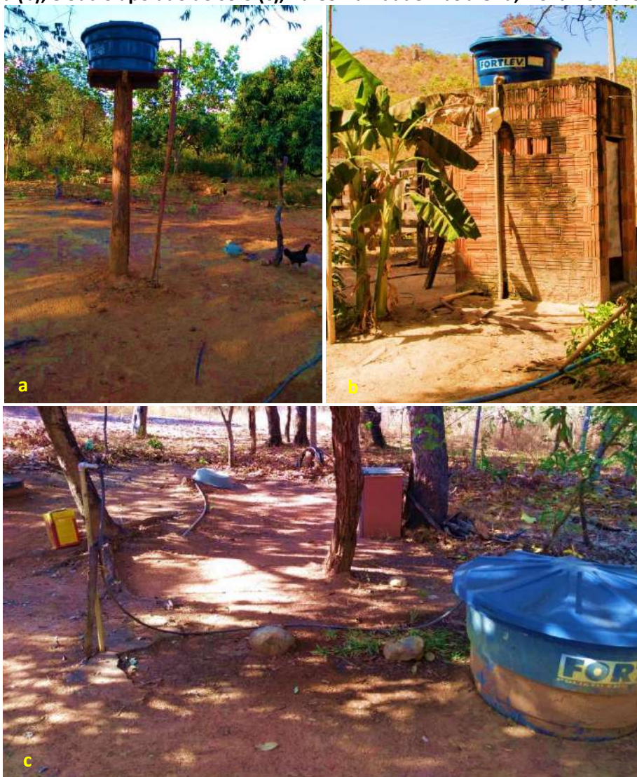
Foto 6.6 – Reservatório domiciliar em polietileno com tampa, instalado sobre estrutura de madeira (a), alvenaria (b), e outro apoiado ao solo (c), na Comunidade Abobreira, Nova Roma-GO, 2018.
