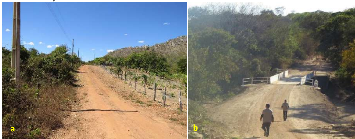
Foto 6.16 – Via não pavimentada (a) e ponte sobre fundo de vale (b), na Comunidade Abobreira, Nova Roma-GO, 2018.
