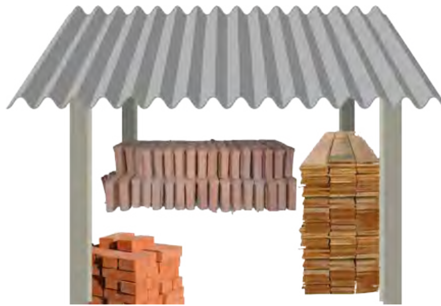
Material de construção organizado e coberto
