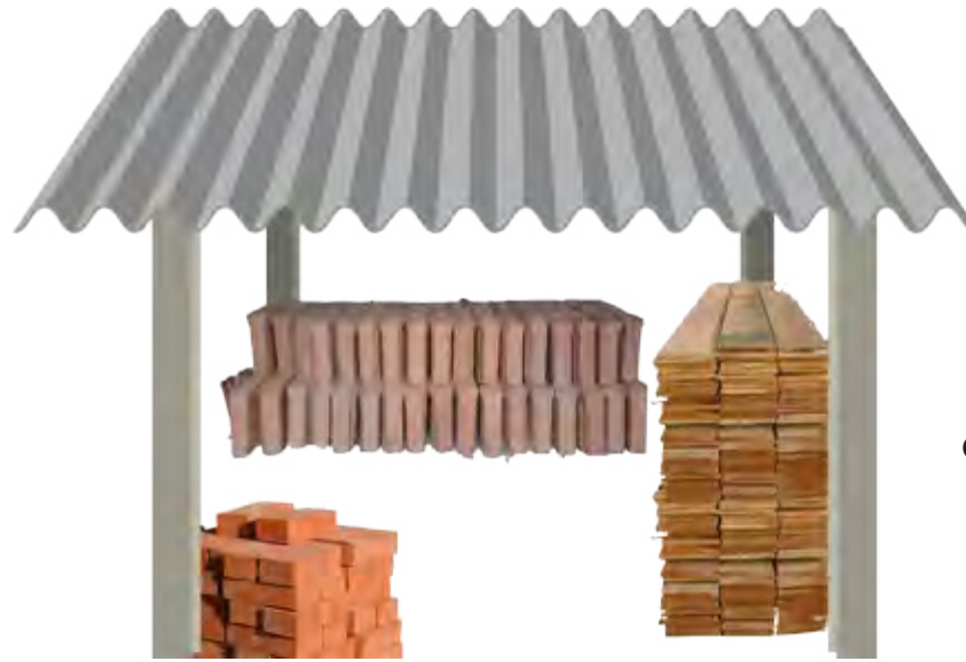
Material de construção organizado e coberto
