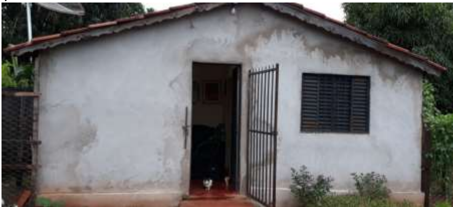
Foto 4.12 – Piso de cimento queimado, identificado nas habitações da Comunidade de Vó Rita, Trindade-GO, 2019.
