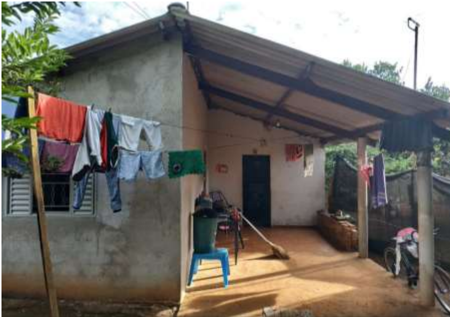
Foto 4.11 – Piso de cerâmica e concreto bruto, identificado nas habitações da Comunidade de Vó Rita, Trindade-GO, 2019.
