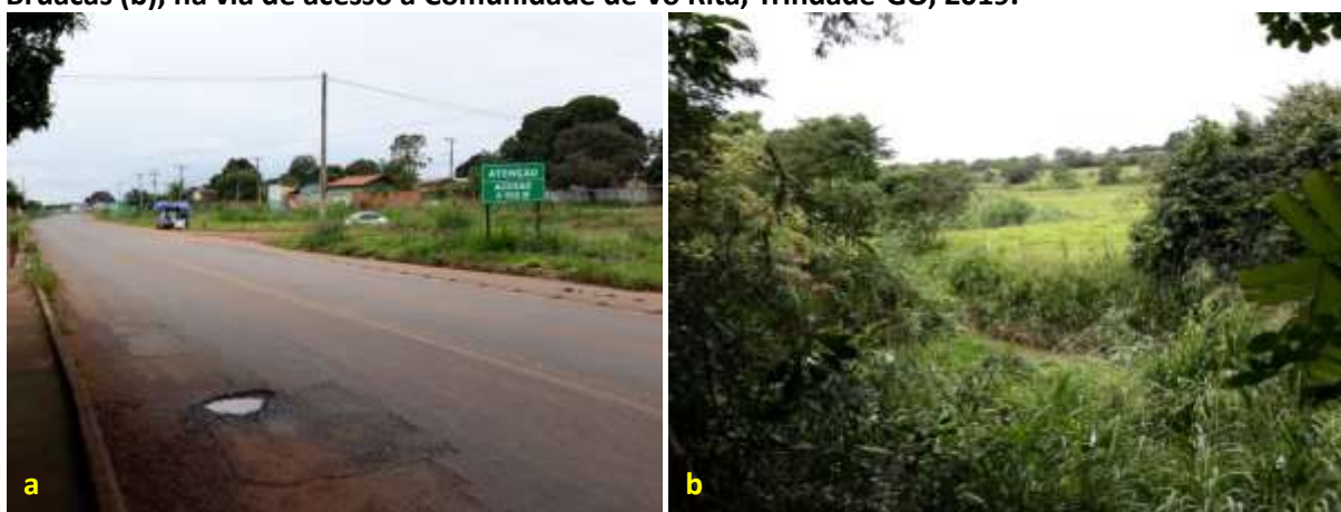
Foto 6.13 – Entrada da comunidade (setor Bela Vista) pela GO-469 (a) e fundo de vale do córrego Bruacas (b), na via de acesso à Comunidade de Vó Rita, Trindade-GO, 2019.
