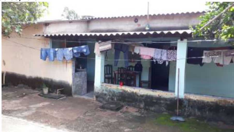
Foto 4.15 – Cobertura de telha de fibrocimento, identificada nas habitações da Comunidade de Vó Rita, Trindade-GO, 2019.
