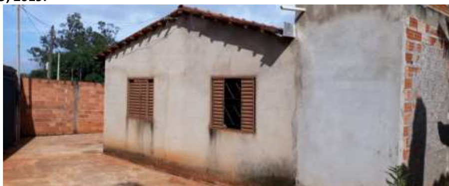
Foto 4.9 – Habitação construída de alvenaria com reboco, identificada na Comunidade de Vó Rita, Trindade-GO, 2019.
