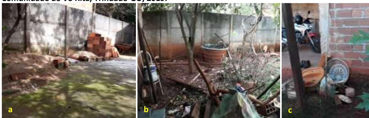
Foto 6.11 – Presença, nos quintais, de materiais de construção, tipo: tijolos de cerâmica e areia (a), resíduos variados espalhados (b) e resíduos acumulados com capacidade de armazenar água na Comunidade de Vó Rita, Trindade-GO, 2019.
