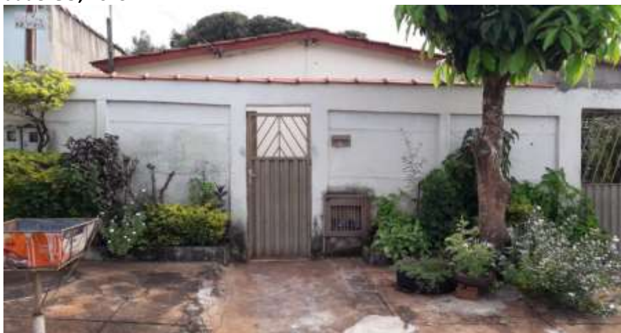
Foto 4.10 – Habitação construída de alvenaria com reboco e pintura, identificada na Comunidade de Vó Rita, Trindade-GO, 2019.
