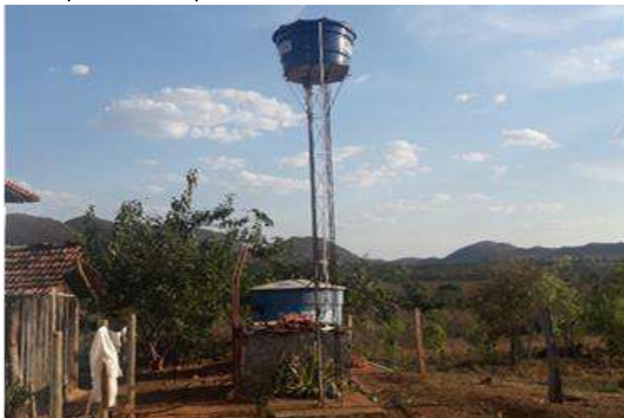
Foto 6.6 – Domicílios com dois reservatórios domiciliares, um apoiado e outro elevado, na Comunidade Vitória, Goianésia-GO, 2018.
