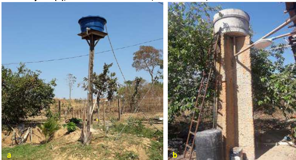
Foto 6.7 – Reservatório domiciliar instalado sobre estrutura em madeira (a) e outro sobre estrutura em alvenaria de tijolos (b), na Comunidade Vitória, Goianésia-GO, 2018.
