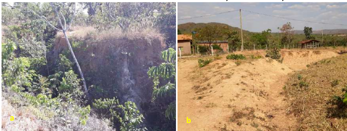
Foto 6.23 – Processos erosivos em lotes da Comunidade Vitória, Goianésia-GO, 2018.
