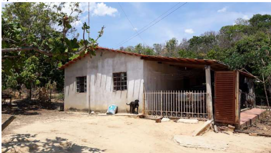
Foto 4.4 – Habitação construída de alvenaria com reboco, identificada na Comunidade Vitória, Goianésia-GO, 2018.
