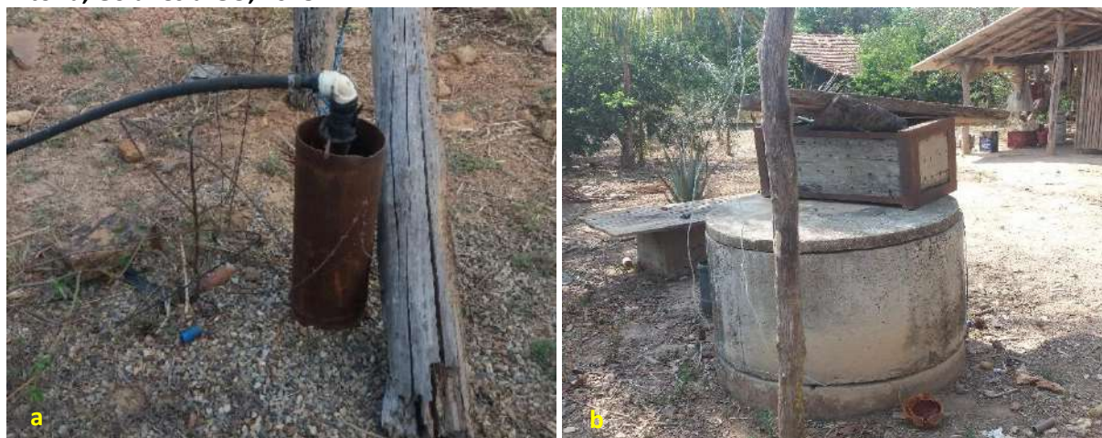
Foto 6.1 – Poço tubular raso (a) e poço raso escavado (b) utilizados em domicílios da Comunidade Vitória, Goianésia-GO, 2018.
