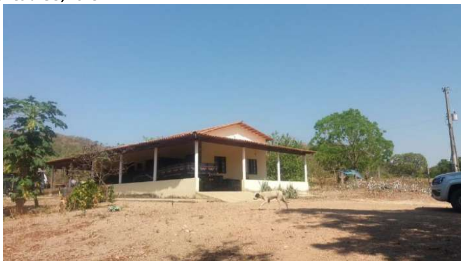
Foto 4.5 – Habitação construída de alvenaria com reboco e pintura, identificada na Comunidade Vitória, Goianésia-GO, 2018.
