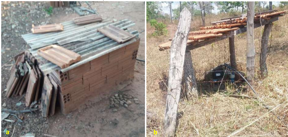
Foto 6.3 – Abrigo contruído em alvenaria de tijos e telhas(a) e outro com madeira e telhas (b), na Comunidade Vitória, Goianésia-GO, 2018.
