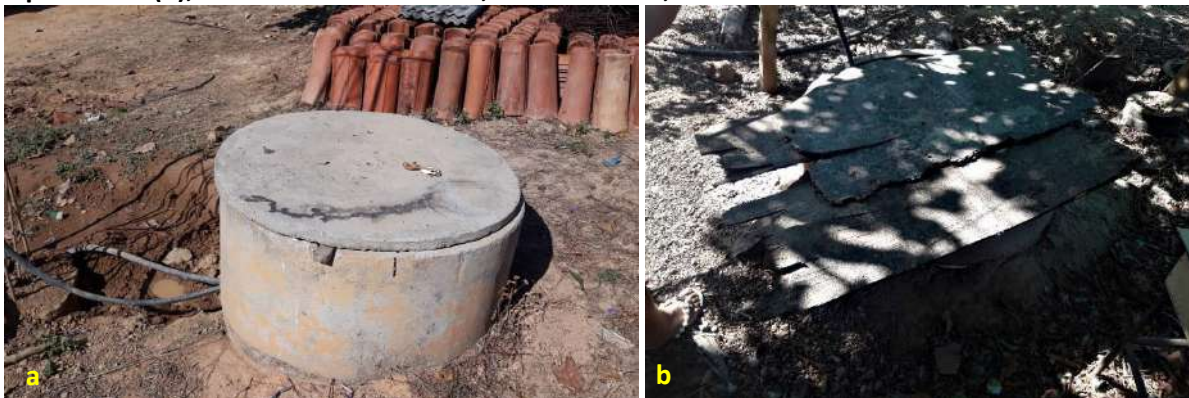
Foto 6.4 – Poço raso escavado com tampa e mureta de proteção (a) e outro tampado com material improvisado (b), na Comunidade Vitória, Goianésia-GO, 2018.
