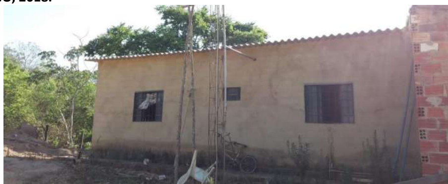
Foto 4.8 – Cobertura de telha fibrocimento, identificada nas habitações da Comunidade Vitória, Goianésia-GO, 2018.
