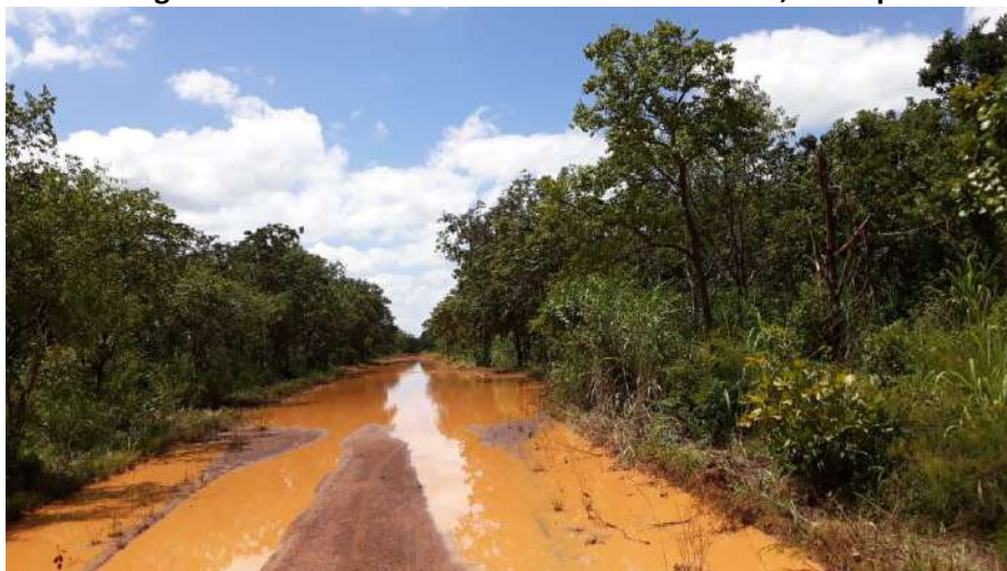
Foto 6.16 – Ponto de alagamento na via de acesso à Comunidade Vazante, Divinópolis de Goiás-GO, 2019.
