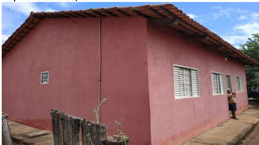
Foto 4.23 – Habitação construída de alvenaria com reboco e pintura, identificada na Comunidade Vazante, Divinópolis de Goiás-GO, 2019.
