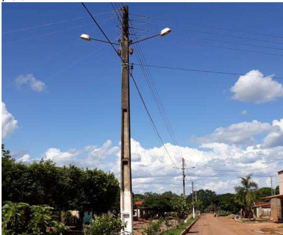
Foto 4.18 – Iluminação pública registrada durante o checklist da Comunidade Vazante, Divinópolis de Goiás-GO, 2019.
