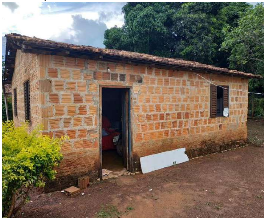
Foto 4.20 – Habitação construída de alvenaria sem reboco, identificada na Comunidade Vazante, Divinópolis de Goiás-GO, 2019.
