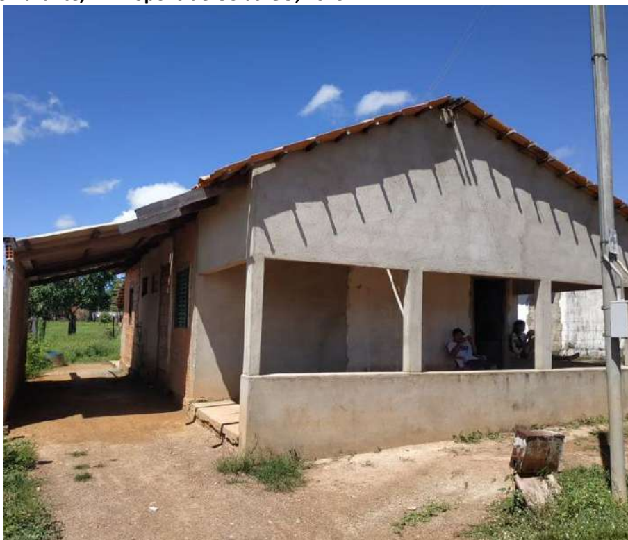
Foto 4.21 – Habitação construída de alvenaria com reboco e sem reboco, identificada na Comunidade Vazante, Divinópolis de Goiás-GO, 2019.
