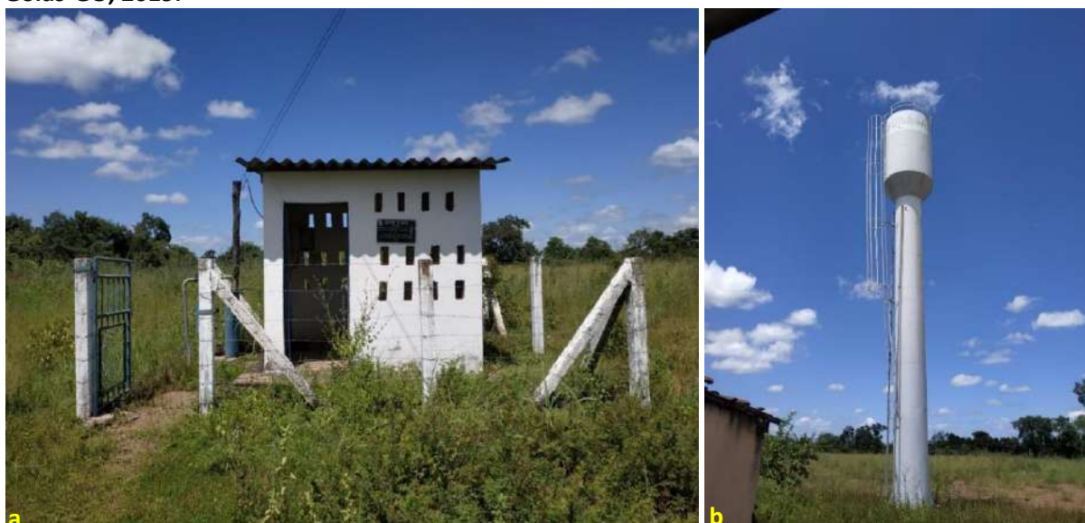
Foto 6.5 – Partes constituintes do sistema de abastecimento de água Mangabeira, poço tubular profundo F3 (a) e reservatório elevado tipo taça R4 (b), na Comunidade Vazante, Divinópolis de Goiás-GO, 2019.
