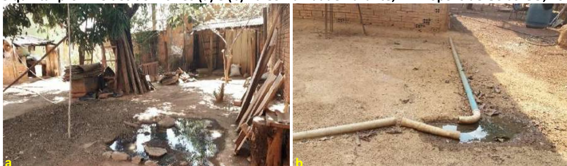
Foto 6.8 – Lançamento e acúmulo de água cinza proveniente da pia da cozinha diretamente no solo do quintal próximo aos domicílios (a) e (b) na Comunidade Vazante, Divinópolis de Goiás-GO, 2019.
