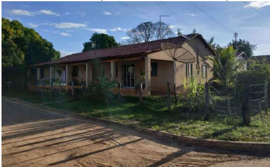
Foto 6.17 – Via interna com meio-fio e sarjeta na Comunidade Vazante, Divinópolis de Goiás-GO, 2019.
