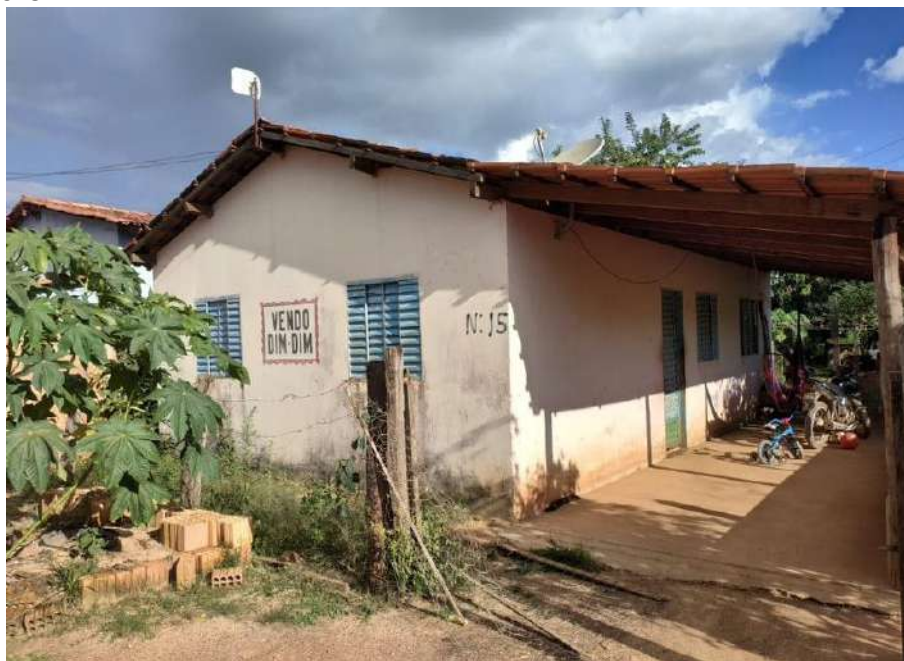
Foto 4.24 – Piso residências no concreto bruto, identificado na Comunidade Vazante, Divinópolis de Goiás-GO, 2019.
