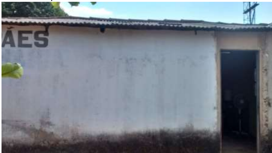
Foto 4.6 – Cobertura de telha de fibrocimento, identificada nas habitações da Comunidade Valdemar de Oliveira, Goianésia-GO, 2019.
