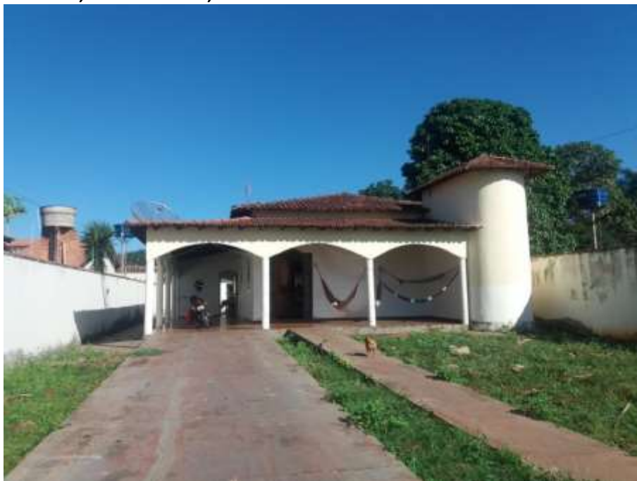
Foto 4.2 – Habitação construída de alvenaria com reboco e pintura, identificada na Comunidade Valdemar de Oliveira, Goianésia-GO, 2019.
