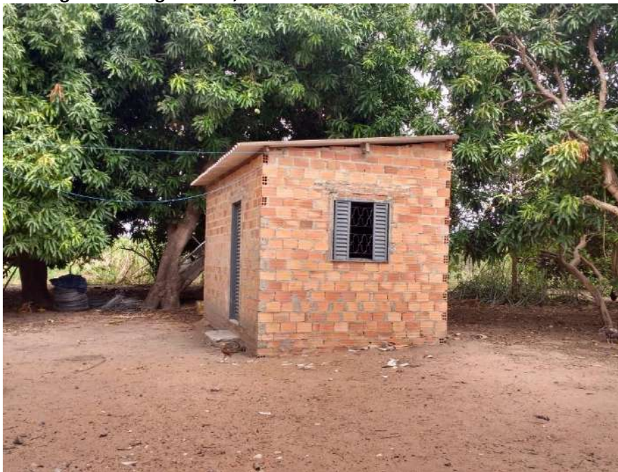
Foto 4.15 – Extensão habitacional com cobertura de fibrocimento identificada na Comunidade Umuarama, São Miguel do Araguaia-GO, 2018.
