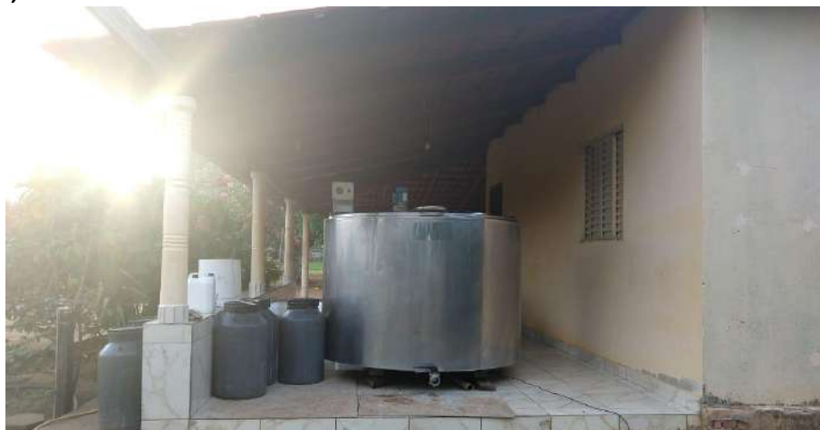
Foto 4.2 – Tanque de resfriamento de leite identificado na Comunidade Umuarama, São Miguel do Araguaia-GO, 2018.
