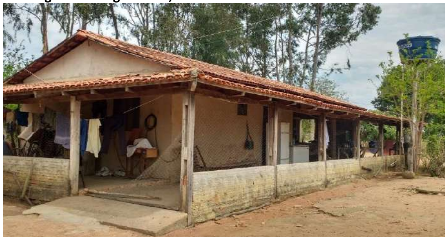
Foto 4.11 – Piso de residência constituído de concreto bruto, identificado na Comunidade Umuarama, São Miguel do Araguaia-GO, 2018.
