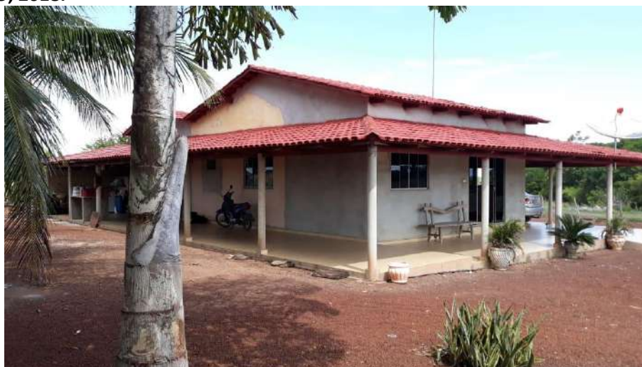
Foto 4.14 – Cobertura de telha de barro, identificada na Comunidade Umuarama, São Miguel do Araguaia-GO, 2018.
