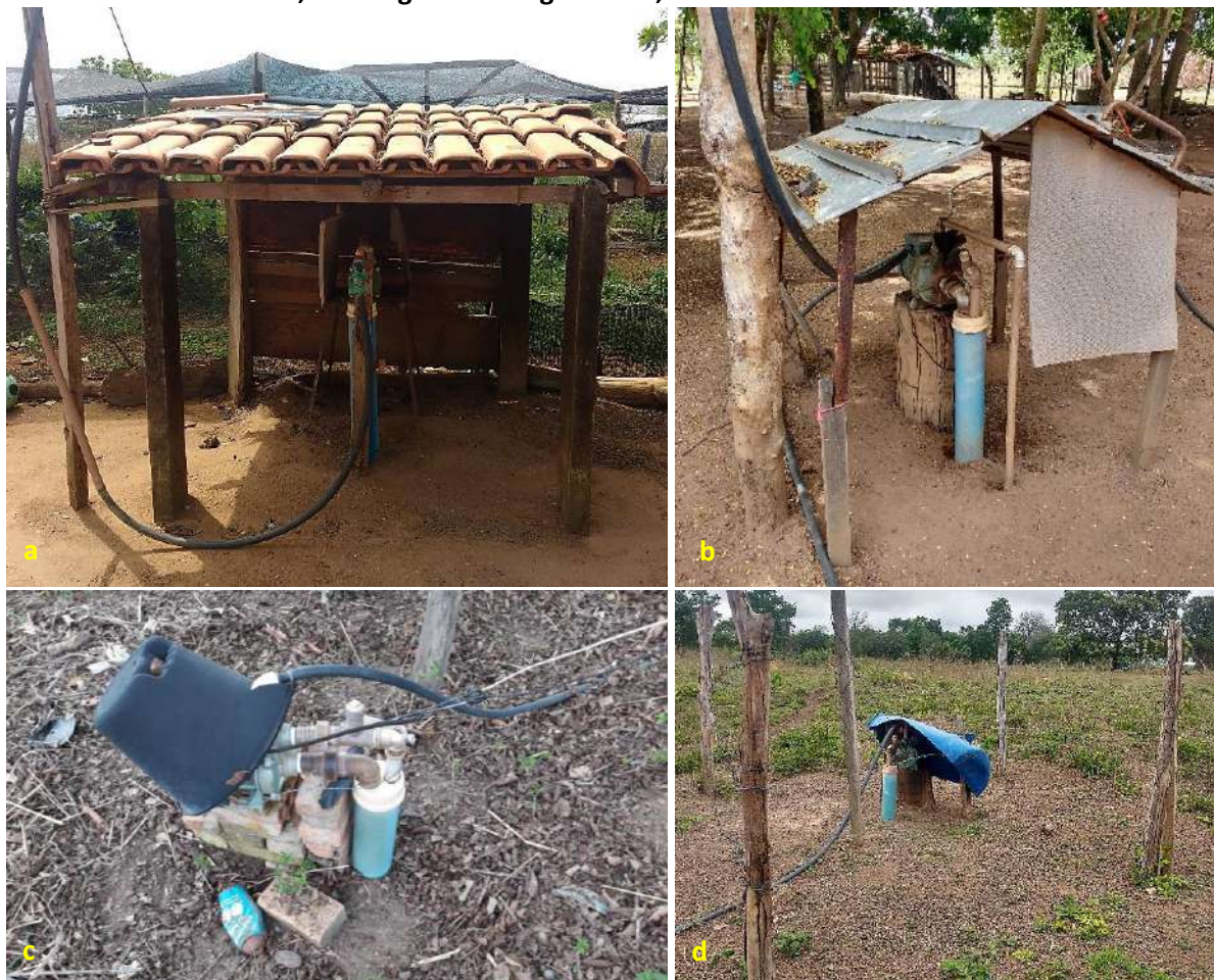
Foto 6.3 – Poços tubulares rasos com abrigo com cobertura de telha cerâmica (a), abrigo improvisado metálico (b), com balde (c), bombona e cerca (d) para proteção do conjunto motobomba, na Comunidade Umuarama, São Miguel do Araguaia-GO, 2018.
