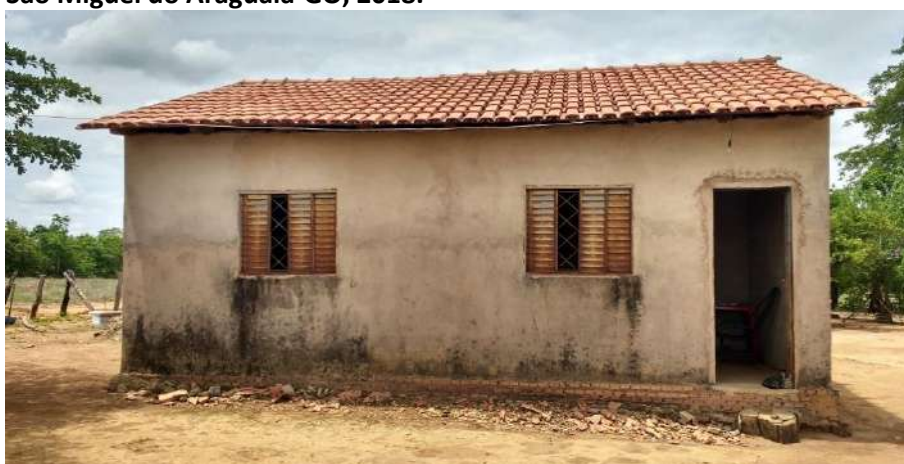
Foto 4.8 – Habitação construída de alvenaria com reboco sem pintura, identificada na Comunidade Umuarama, São Miguel do Araguaia-GO, 2018.
