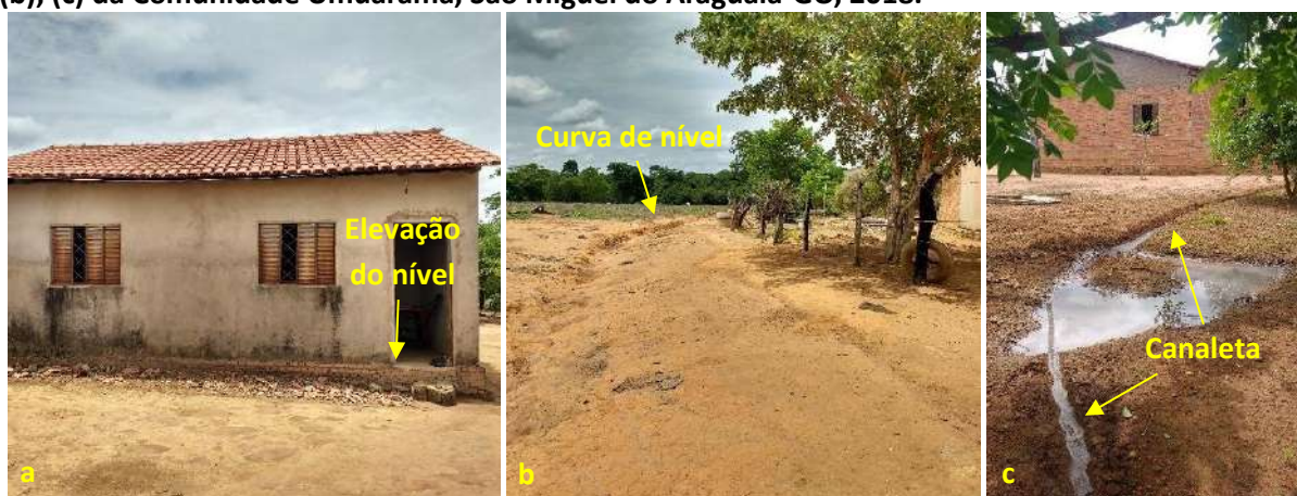
Foto 6.23 – Dispositivos de prevenção dos danos provocados pelas águas em residência (a) e lotes (b), (c) da Comunidade Umuarama, São Miguel do Araguaia-GO, 2018.
