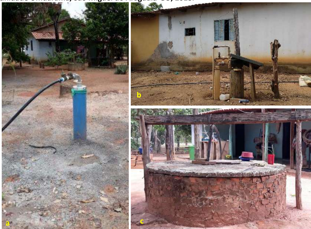
Foto 6.1 – Exemplos de poço tubular profundo (a), poço tubular raso (b) e poço raso escavado (c), na Comunidade Umuarama, São Miguel do Araguaia-GO, 2018.
