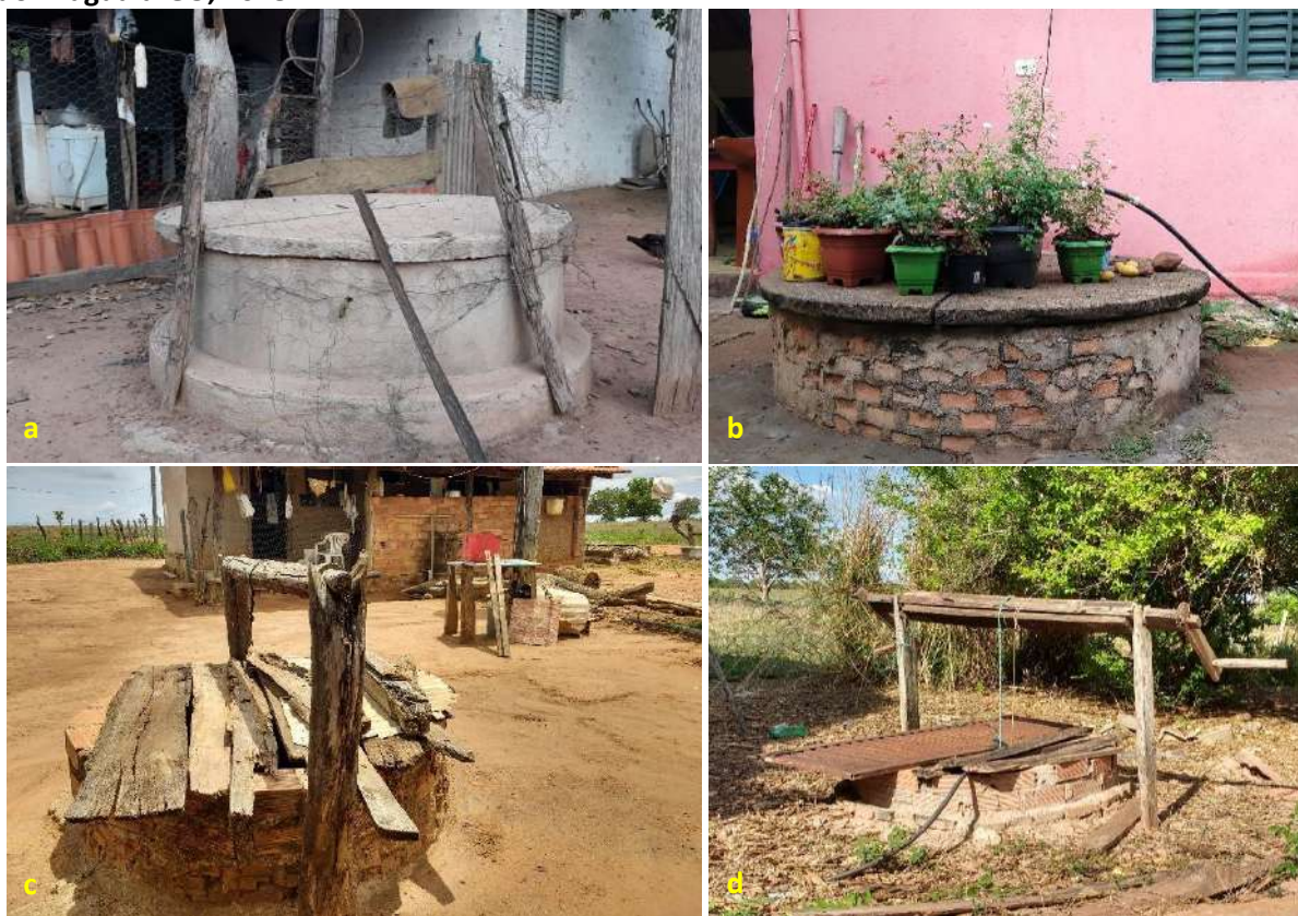
Foto 6.2 – Poços rasos escavados com mureta e tampa de concreto e cerca (a), tampa de concreto (b), tampas improvisadas de madeira (c) e porta metálica (d) na Comunidade Umurama, São Miguel do Araguaia-GO, 2018.
