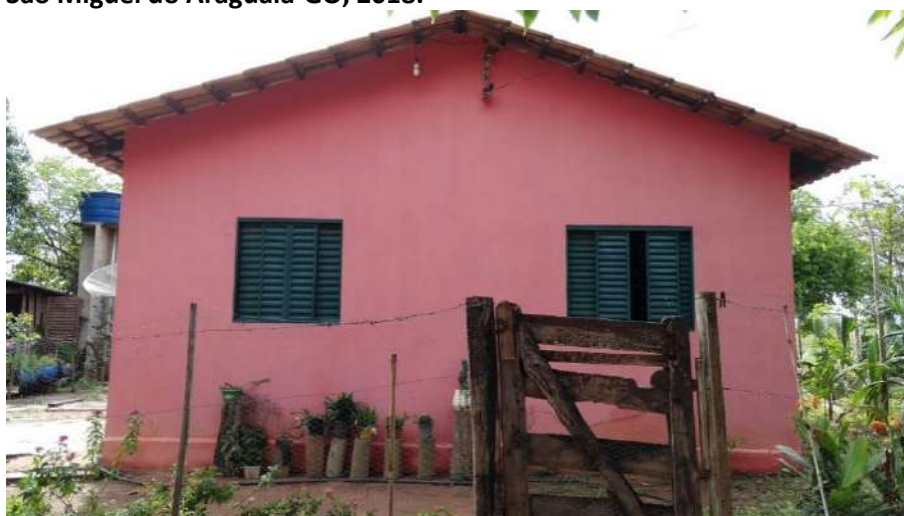
Foto 4.7 – Habitação construída de alvenaria com reboco e pintura, identificada na Comunidade Umuarama, São Miguel do Araguaia-GO, 2018.
