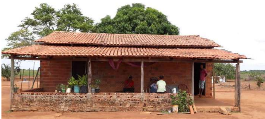
Foto 4.9 – Habitação construída de alvenaria sem reboco, identificada na Comunidade Umuarama, São Miguel do Araguaia-GO, 2018.
