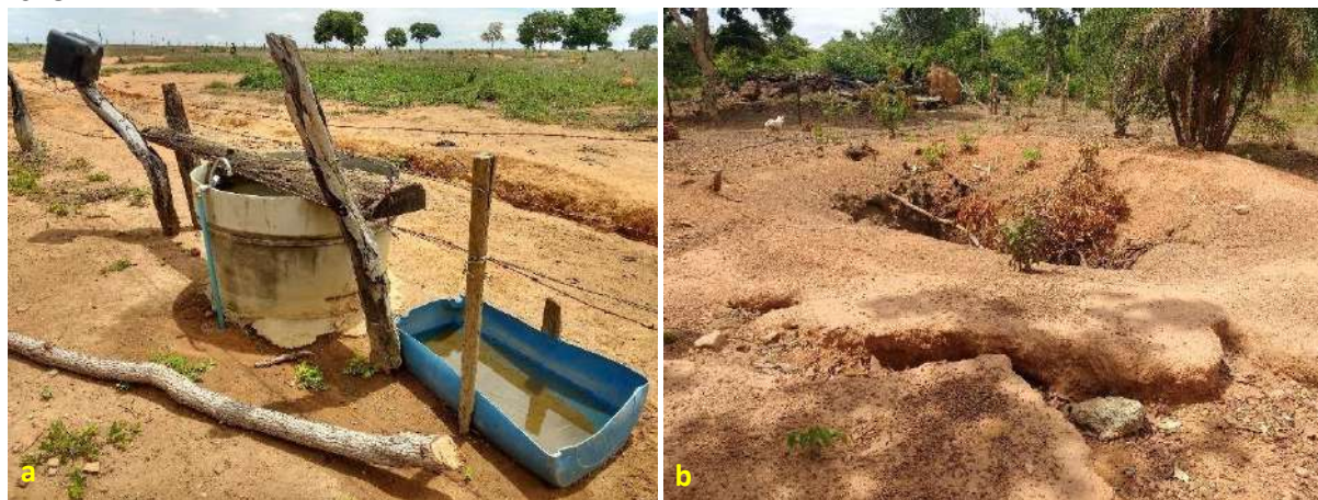
Foto 6.24 – Processos erosivos em lotes da Comunidade Umuarama, São Miguel do Araguaia-GO, 2018.
