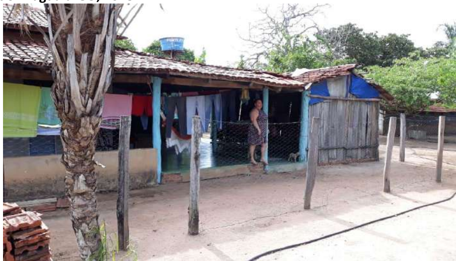
Foto 4.10 – Extensão habitacional construída de madeira, identificada na Comunidade Umuarama, São Miguel do Araguaia-GO, 2018.
