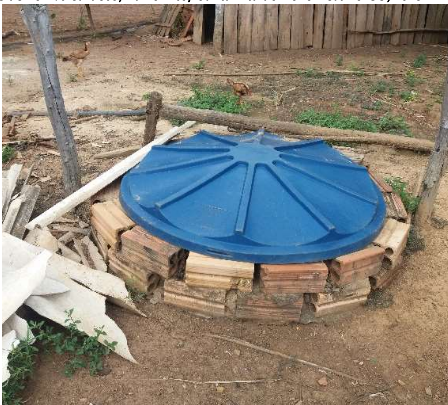
Foto 6.3 – Poço raso escavado com tampa de polietileno e mureta sem revestimento, na Comunidade de Tomás Cardoso, Barro Alto/ Santa Rita do Novo Destino-GO, 2019.
