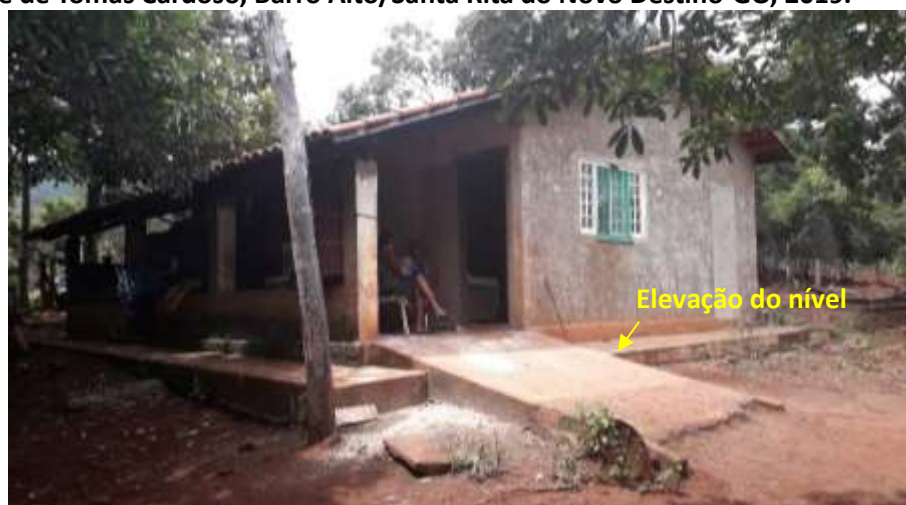
Foto 6.20 – Dispositivo de prevenção dos danos provocados pelas águas, em residência da Comunidade de Tomás Cardoso, Barro Alto/Santa Rita do Novo Destino-GO, 2019.
