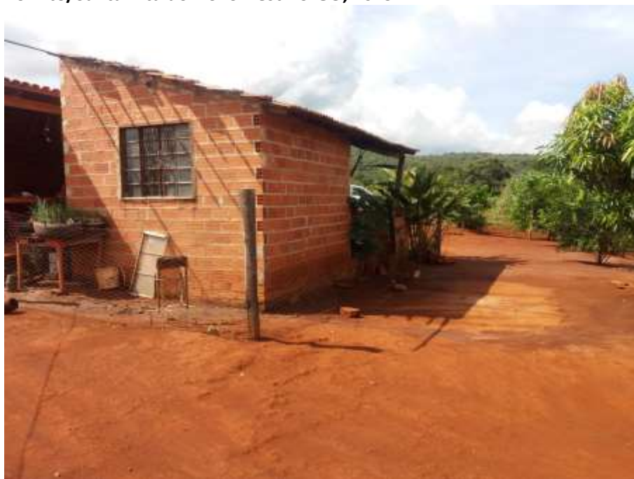
Foto 4.3 – Habitação construída de alvenaria sem reboco, identificada na Comunidade de Tomás Cardoso, Barro Alto/Santa Rita do Novo Destino-GO, 2019.
