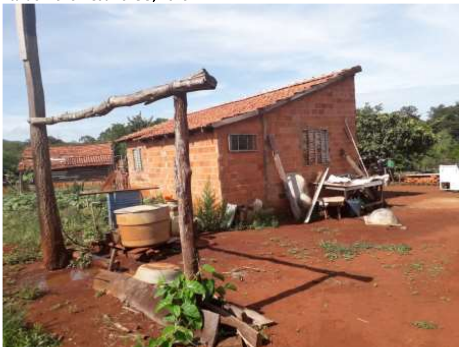
Foto 4.7 – Cobertura de telha de barro, identificada na Comunidade de Tomás Cardoso, Barro Alto/Santa Rita do Novo Destino-GO, 2019.
