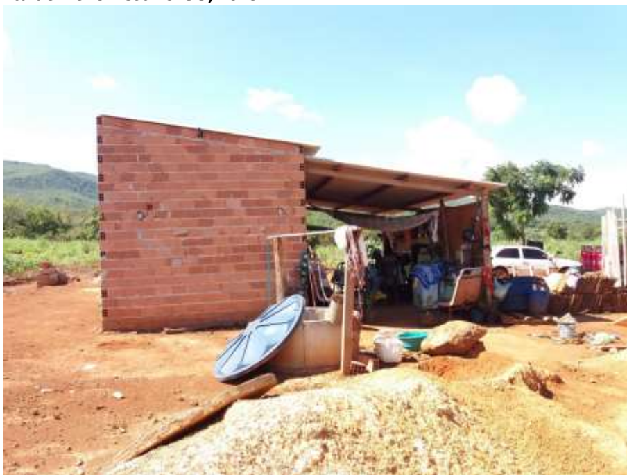
Foto 4.8 – Cobertura de telha de fibrocimento, identificada na Comunidade de Tomás Cardoso, Barro Alto/Santa Rita do Novo Destino-GO, 2019.
