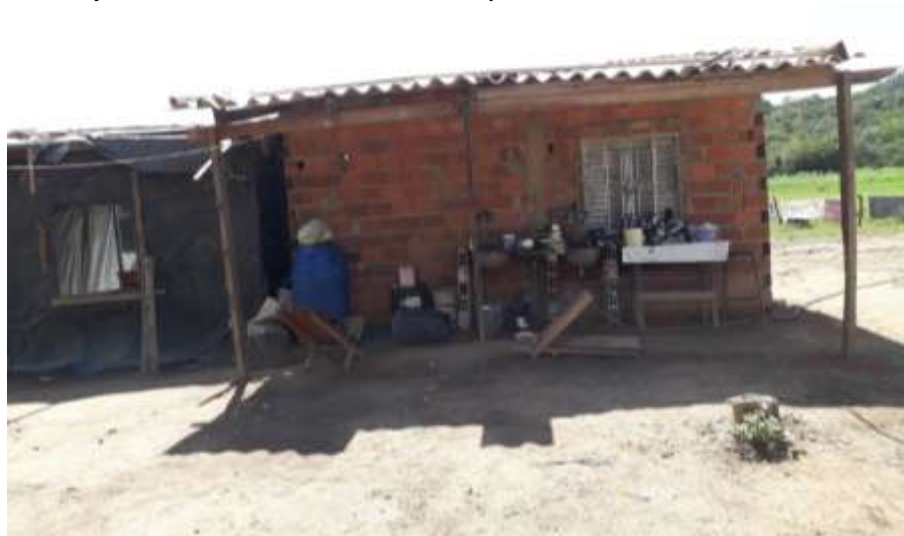
Foto 4.5 – Piso de residência constituído de chão batido, identificado na Comunidade de Tomás Cardoso, Barro Alto/Santa Rita do Novo Destino-GO, 2019.
