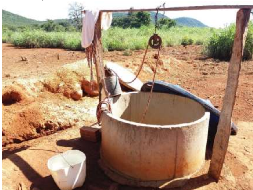
Foto 6.1 – Poço raso escavado de um domicílio da Comunidade de Tomás Cardoso, Barro Alto/ Santa Rita do Novo Destino-GO, 2019.
