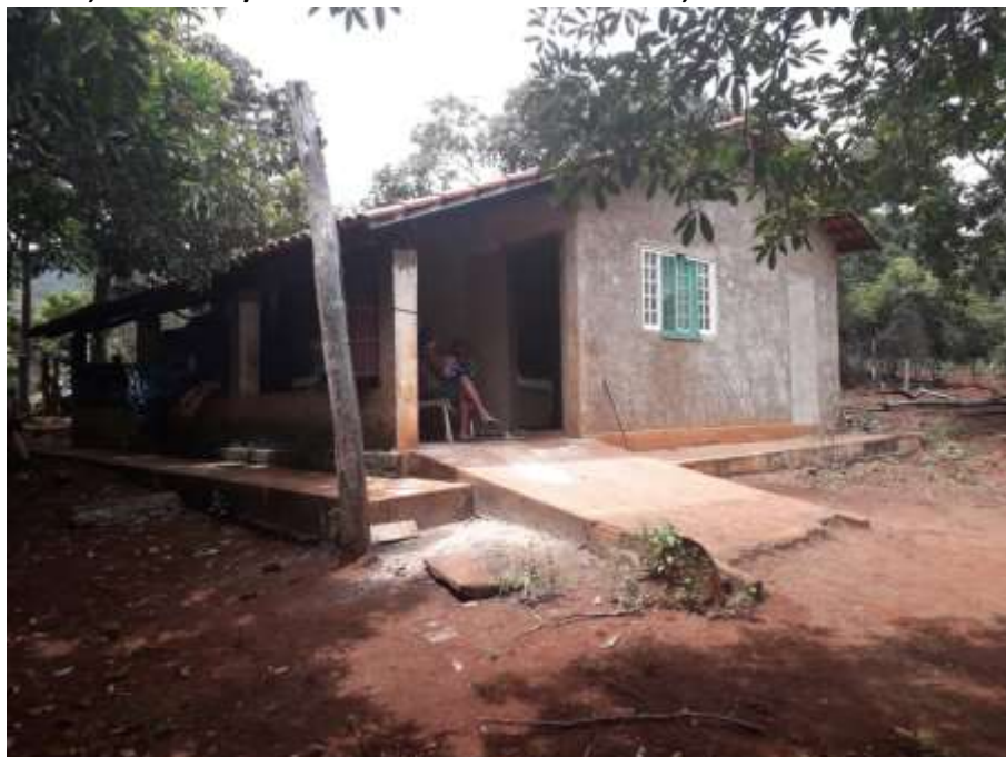
Foto 4.4 – Habitação construída de alvenaria com reboco sem pintura, identificada na Comunidade de Tomás Cardoso, Barro Alto/Santa Rita do Novo Destino-GO, 2019.
