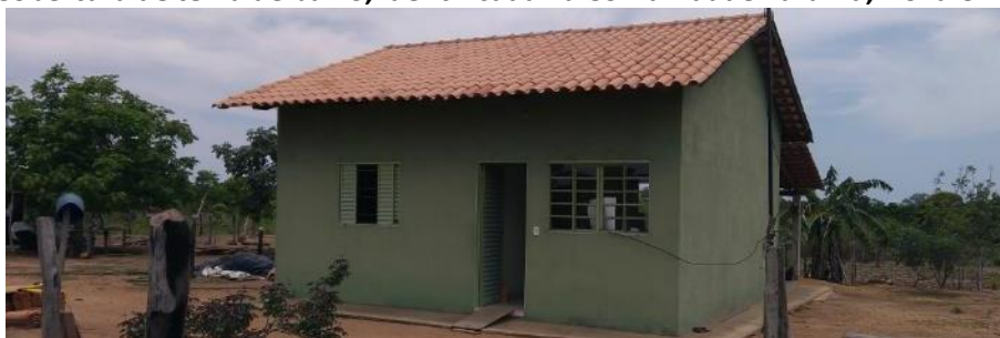
Foto 4.11 – Cobertura de telha de barro, identificada na Comunidade Tatumã, Nova Crixás-GO, 2018.
