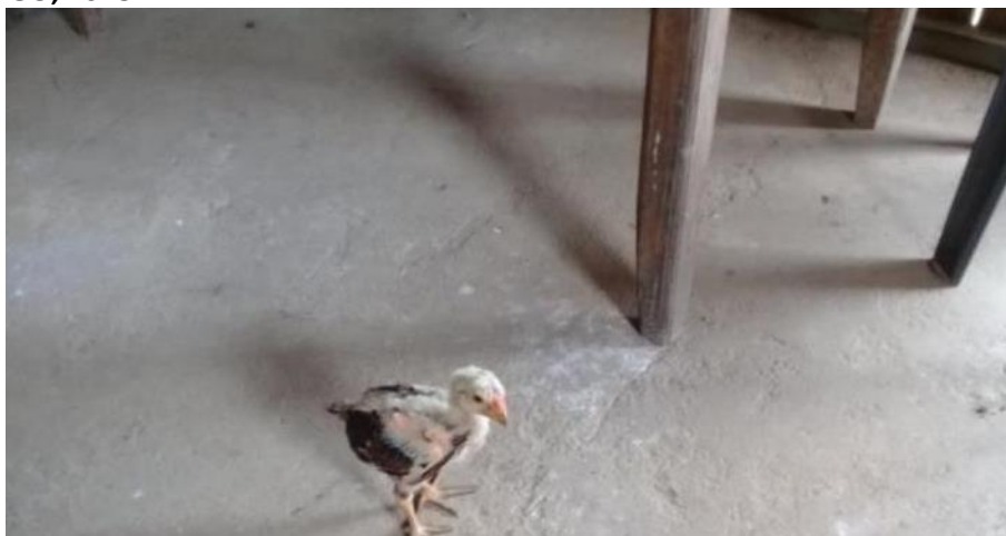
Foto 4.8 – Piso de residência constituído de concreto bruto, identificado na Comunidade Tarumã, Nova Crixás-GO, 2018.
