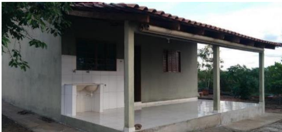
Foto 4.10 – Piso de residência constituído de cerâmica, identificado na Comunidade Tarumã, Nova Crixás-GO, 2018.
