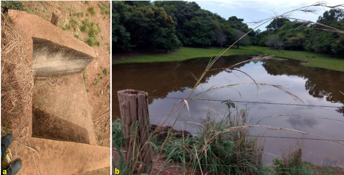
Foto 6.20 – Galeria pluvial (a) e barragem (b) na Comunidade Tarumã, Nova Crixás-GO, 2018.
