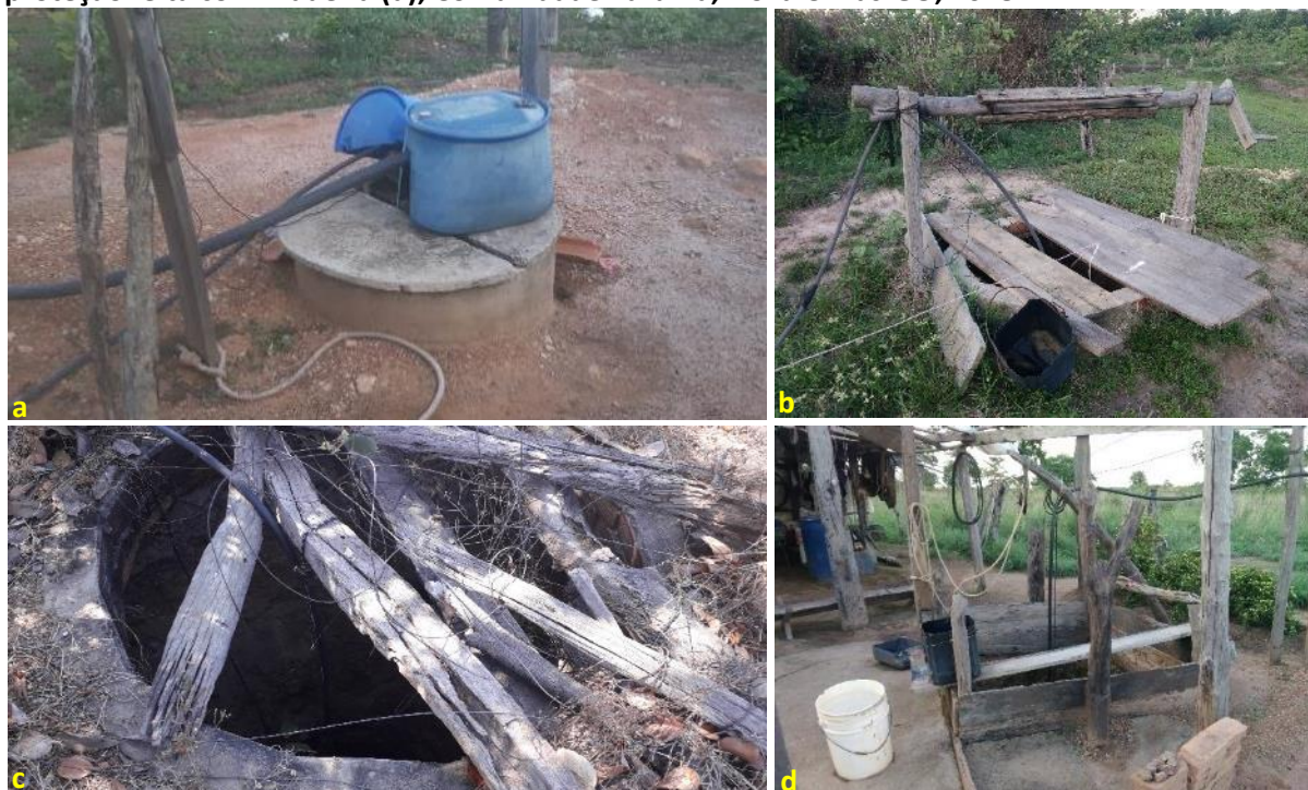
Foto 6.3 – Poço raso escavado com tampa de concreto e mureta de proteção (a), integralmente tampado por tábuas (b) e parcialmente tampado com material improvisado (c), e mureta de proteção feita com madeira (d), Comunidade Tarumã, Nova Crixás-GO, 2018.
