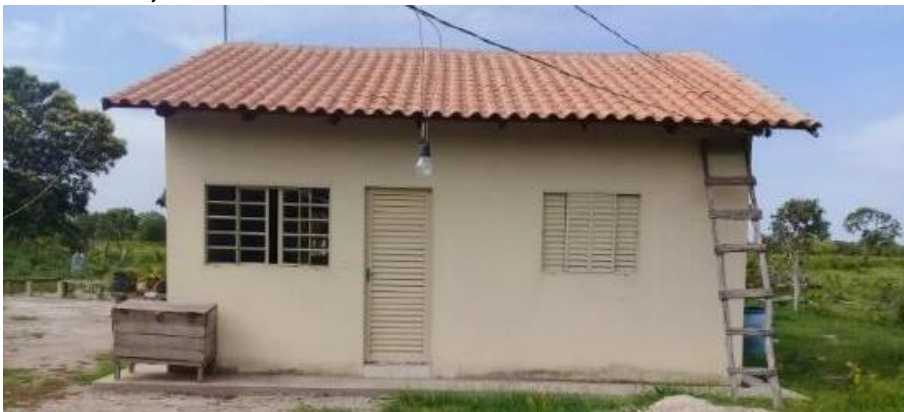
Foto 4.6 – Habitação construída de alvenaria com reboco e pintura, identificadas na Comunidade Tarumã, Nova Crixás-GO, 2018.
