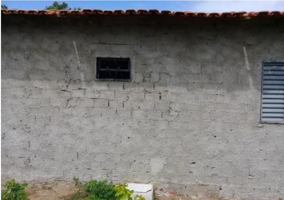
Foto 4.4 – Habitação construída de alvenaria com reboco, identificada na Comunidade Tarumã, Nova Crixás-GO, 2018.
