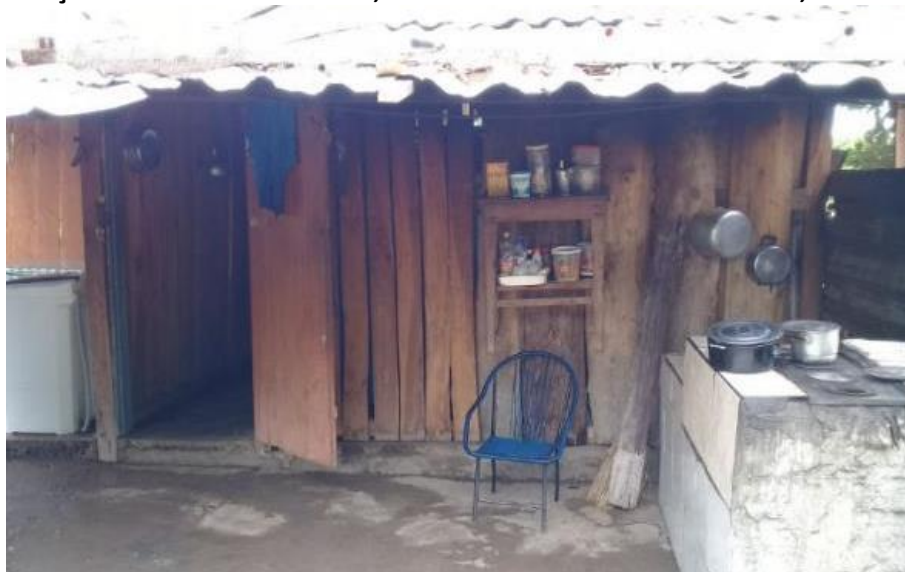
Foto 4.7 – Habitação construída de madeirite, identificada na Comunidade Tarumã, Nova Crixás-GO, 2018.
