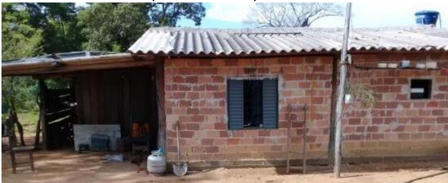
Foto 4.5 – Habitação construída de alvenaria sem reboco e habitação construída de adobe, identificadas na Comunidade Tarumã, Nova Crixás-GO, 2018.
