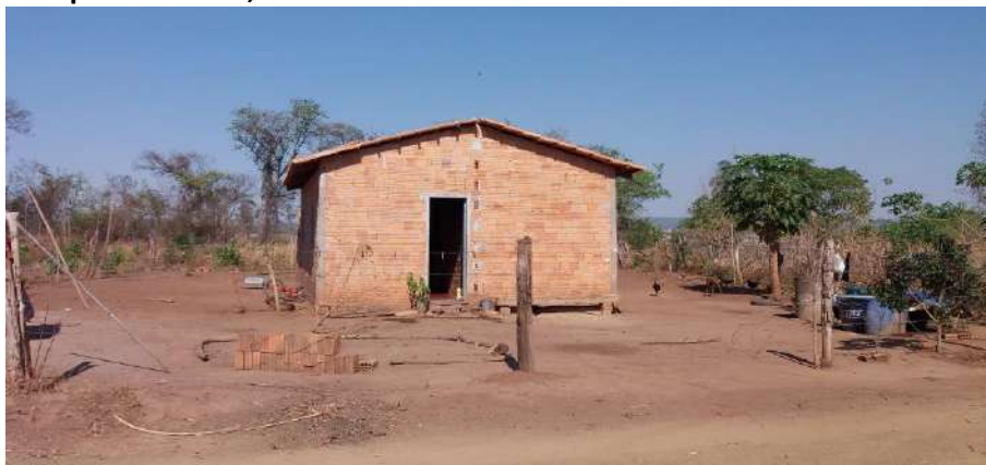
Foto 4.4 – Habitação construída de alvenaria sem reboco, identificada na Comunidade de Taquarussu, Campos Belos-GO, 2019.
