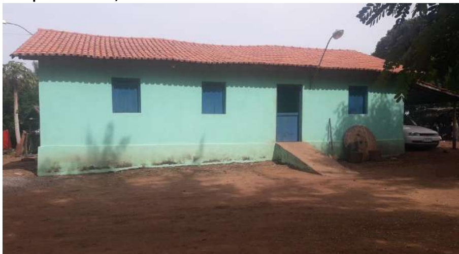
Foto 4.5 – Habitação construída de alvenaria com reboco e pintura, identificada na Comunidade de Taquarussu, Campos Belos-GO, 2019.
