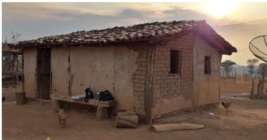
Foto 4.6 – Habitação construída de adobe, identificada na Comunidade de Taquarussu, Campos Belos-GO, 2019.
