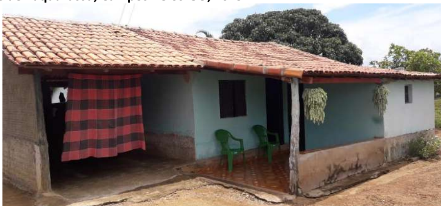
Foto 4.7 – Piso de residência constituído de cimento queimado e cerâmica, identificado na Comunidade de Taquarussu, Campos Belos-GO, 2019.
