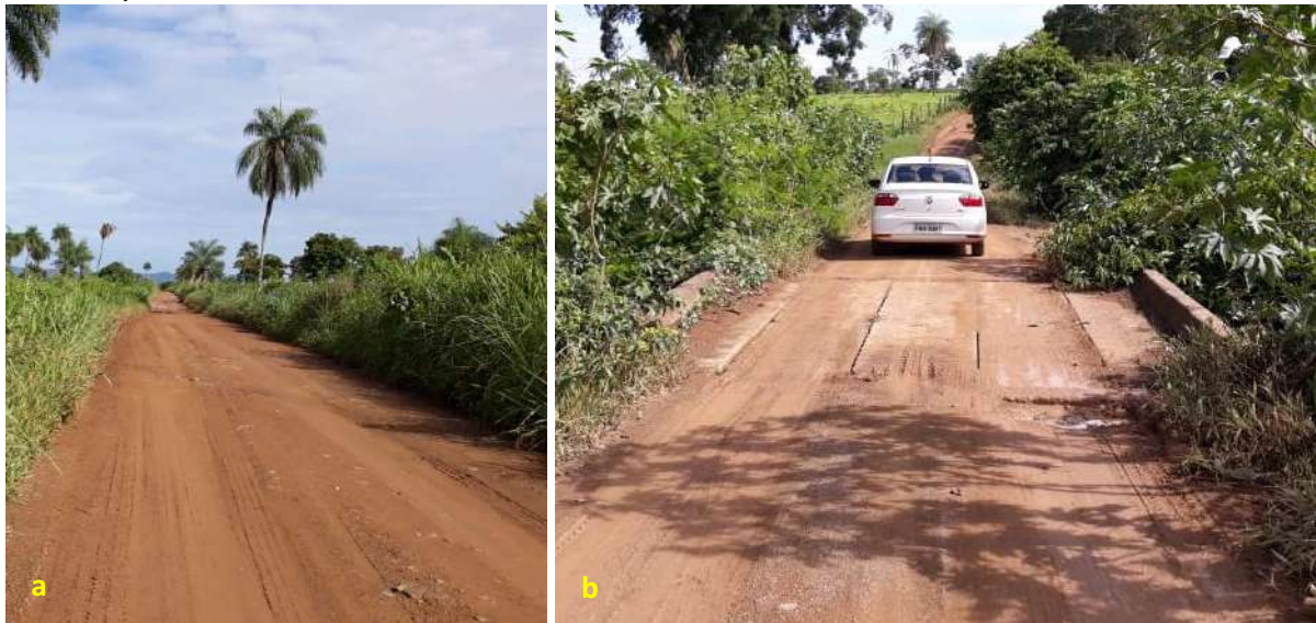
Foto 6.19 – Via de acesso (a) e ponte sobre fundo do vale na Comunidade de Taquarussu, Campos Belos-GO, 2019.
