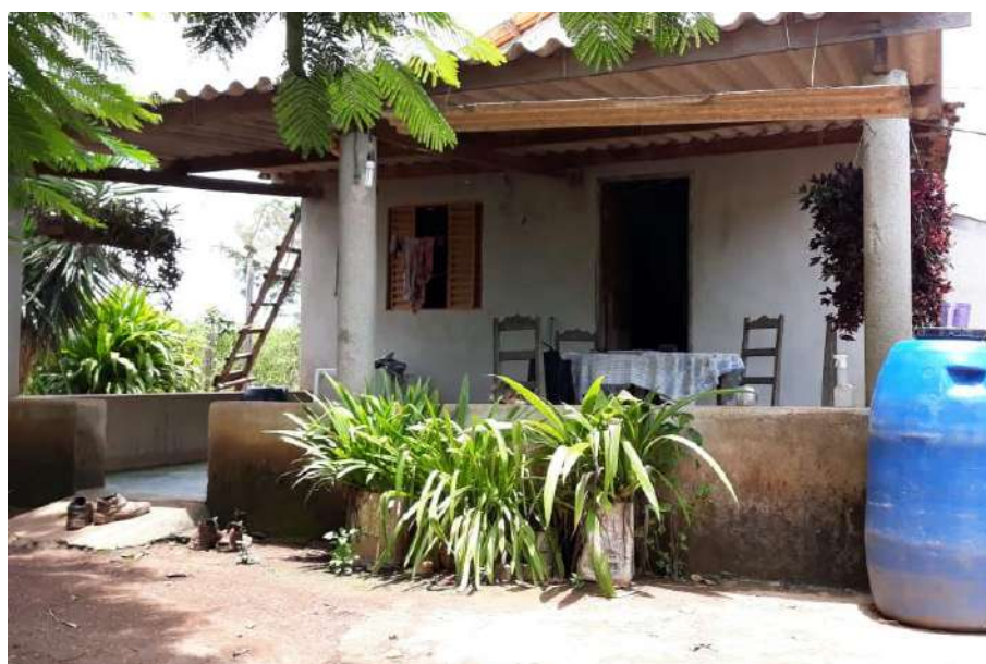
Foto 4.9 – Cobertura de fibrocimento identificada na Comunidade de Taquarussu, Campos Belos-GO, 2019.
