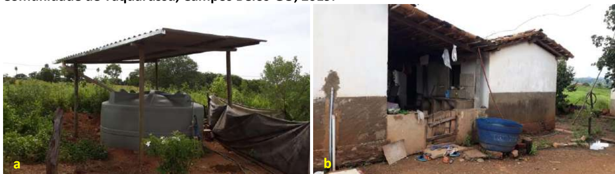
Foto 6.6 – Sistema de captação da água de chuva e armazenamento em cisternas ou tambores, na Comunidade de Taquarussu, Campos Belos-GO, 2019.
