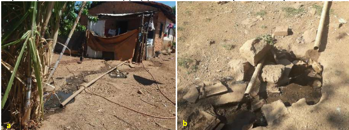
Foto 6.10 – Lançamento e acúmulo de água cinza proveniente da pia da cozinha diretamente no solo do quintal próximo aos domicílios (a) e (b) na Comunidade de Taquarussu, Campos Belos-GO, 2019.
