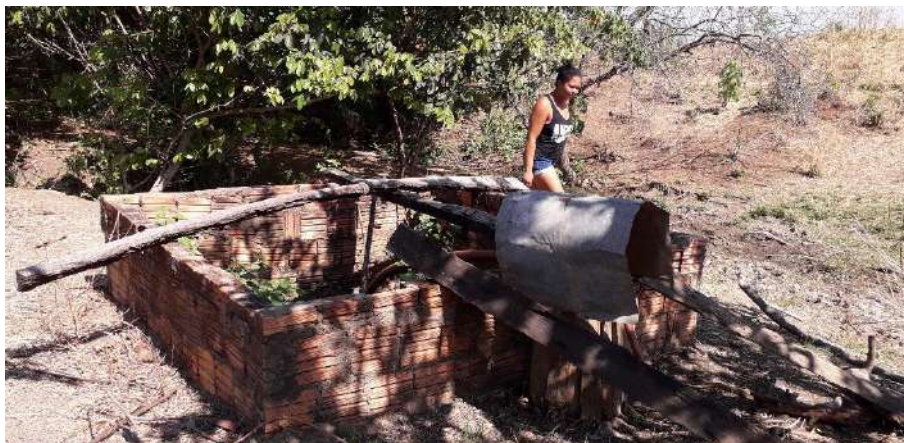
Foto 6.5 – Poço raso escavado utilizado no domicílio 21 da Comunidade de Taquarussu, Campos Belos-GO, 2019.
