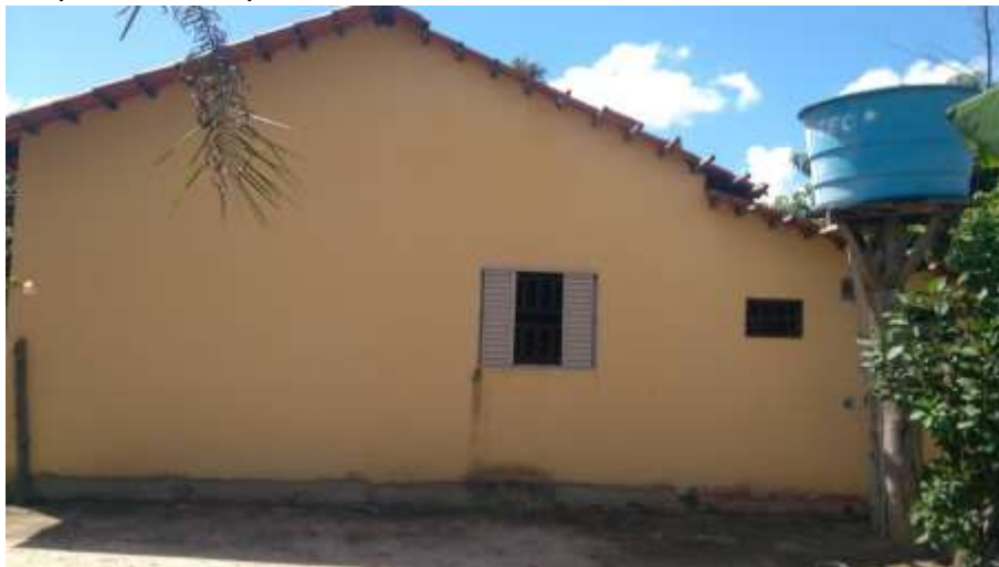
Foto 4.6 – Habitação construída de alvenaria com reboco e pintura, identificada na Comunidade Serra das Araras, Mineiros-GO, 2019.
