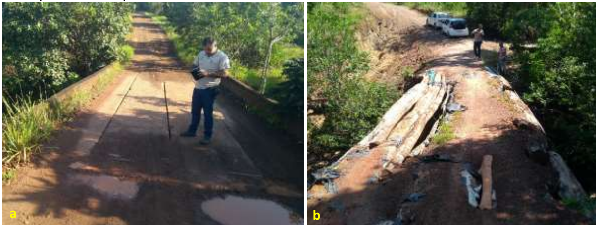
Foto 6.15 – Ponte de concreto (a) e ponte de madeira (b) na via de acesso à Comunidade Serra das Araras, Mineiros-GO, 2019.
