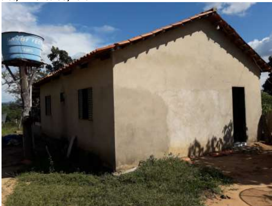
Foto 4.7 – Habitação construída de alvenaria com reboco sem pintura, identificada na Comunidade Serra das Araras, Mineiros-GO, 2019.
