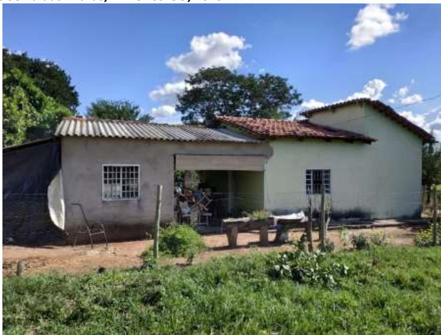
Foto 4.14 – Cobertura de fibrocimento em associação com a telha de barro, identificada na Comunidade Serra das Araras, Mineiros-GO, 2019.
