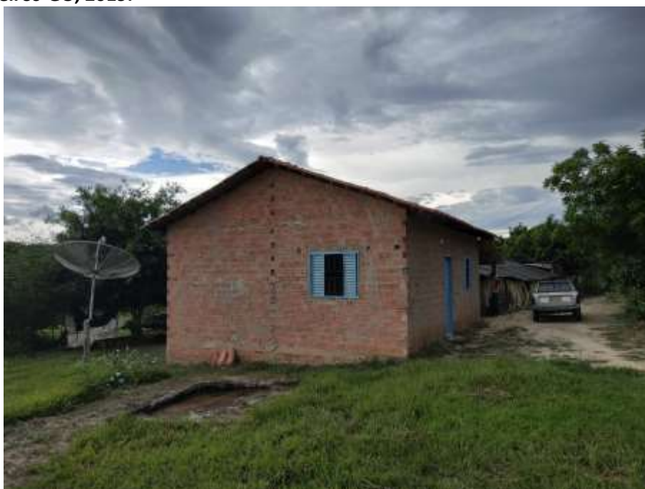
Foto 4.8 – Habitação construída de alvenaria sem reboco, identificada na Comunidade Serra das Araras, Mineiros-GO, 2019.
