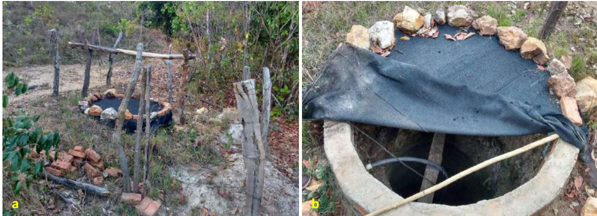
Foto 6.2 – Poço raso escavado em vista (a) e detalhe (b), Comunidade Sebastião Rosa da Paz, Uruaçu-GO, 2018.
