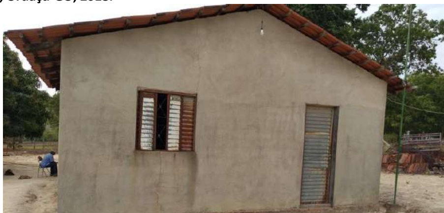
Foto 4.2 – Habitação construída de alvenaria com reboco, identificada na Comunidade Sebastião Rosa da Paz, Uruaçu-GO, 2018.
