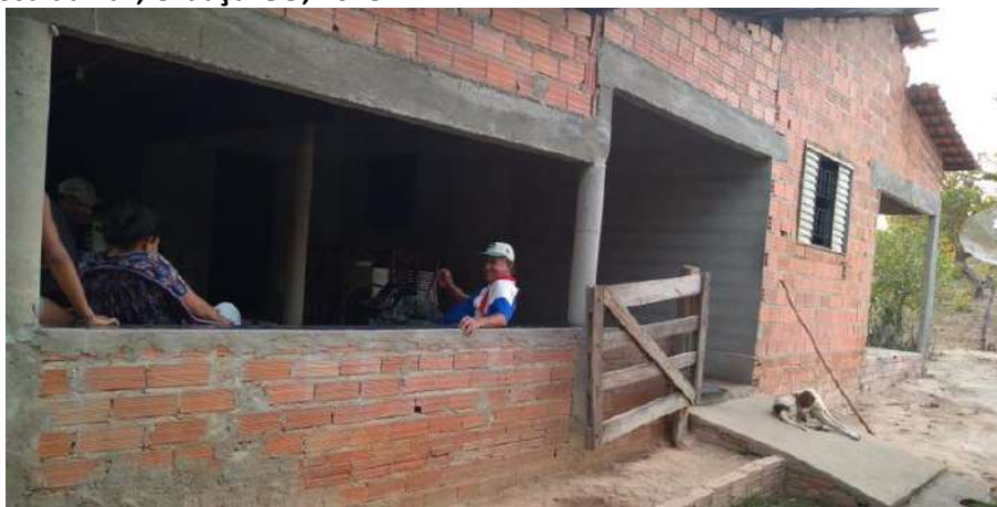
Foto 4.3 – Habitação construída de alvenaria com e sem reboco, identificada na Comunidade Sebastião Rosa da Paz, Uruaçu-GO, 2018.
