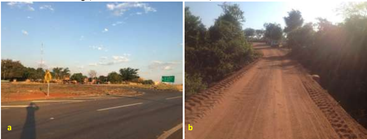
Foto 6.16 – Via de acesso pavimentada (a) e ponte (b) na via de acesso sem pavimentação, na Comunidade São Thiago, Santa Rita do Novo Destino-GO, 2018.
