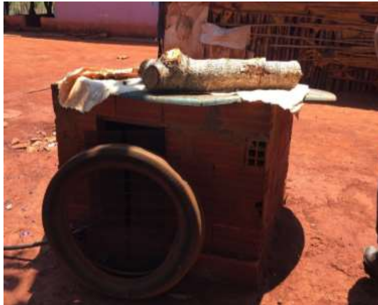
Foto 6.2 – Abrigo do poço tubular raso, na Comunidade São Thiago, Santa Rita do Novo Destino-GO, 2018.
