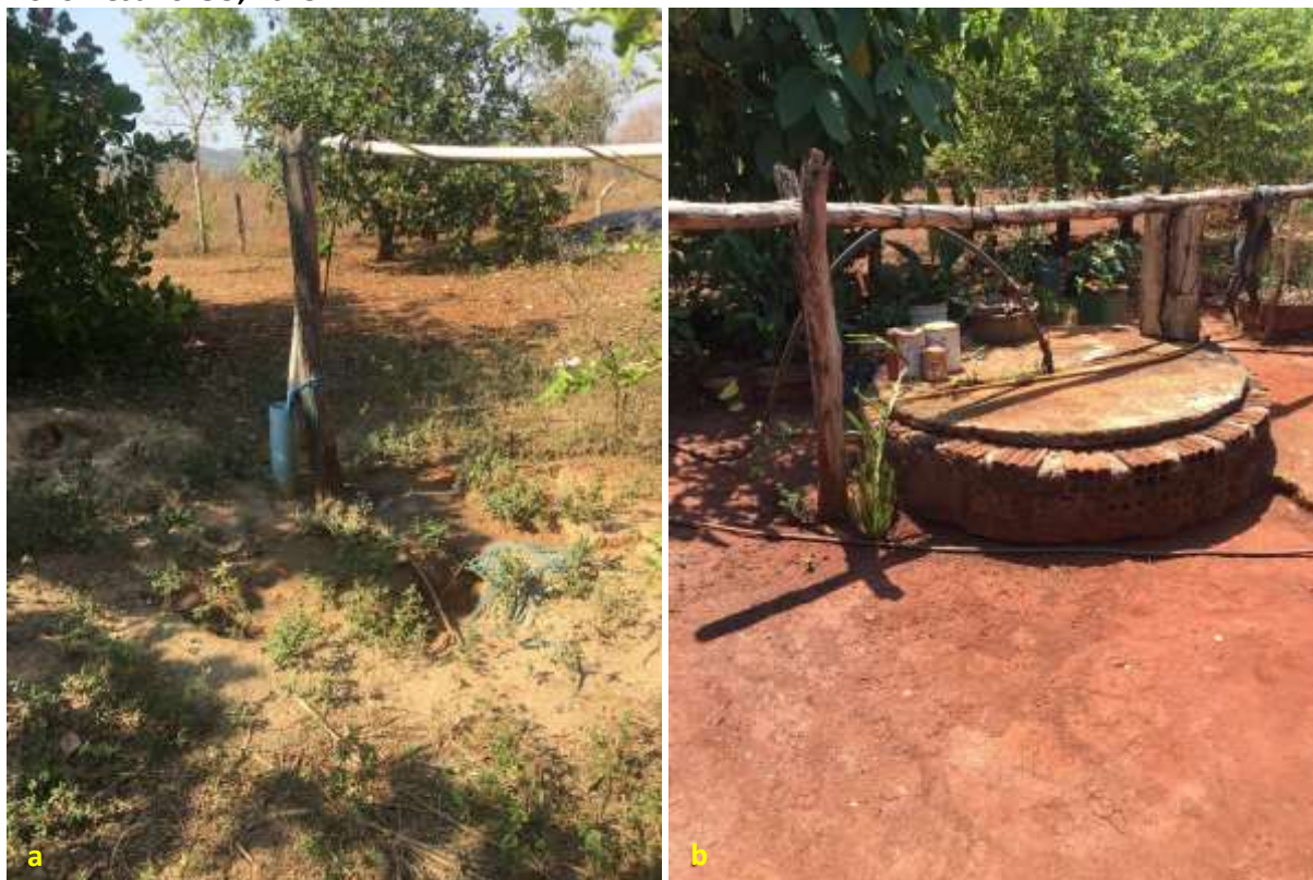
Foto 6.1 – Poço tubular raso (a) e poço raso escavado (b), na Comunidade São Thiago, Santa Rita do Novo Destino-GO, 2018.
