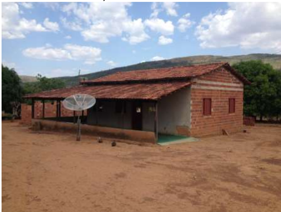
Foto 4.9 – Piso de residência constituído de cimento queimado, identificado na Comunidade São Thiago, Santa Rita do Novo Destino-GO, 2018.
