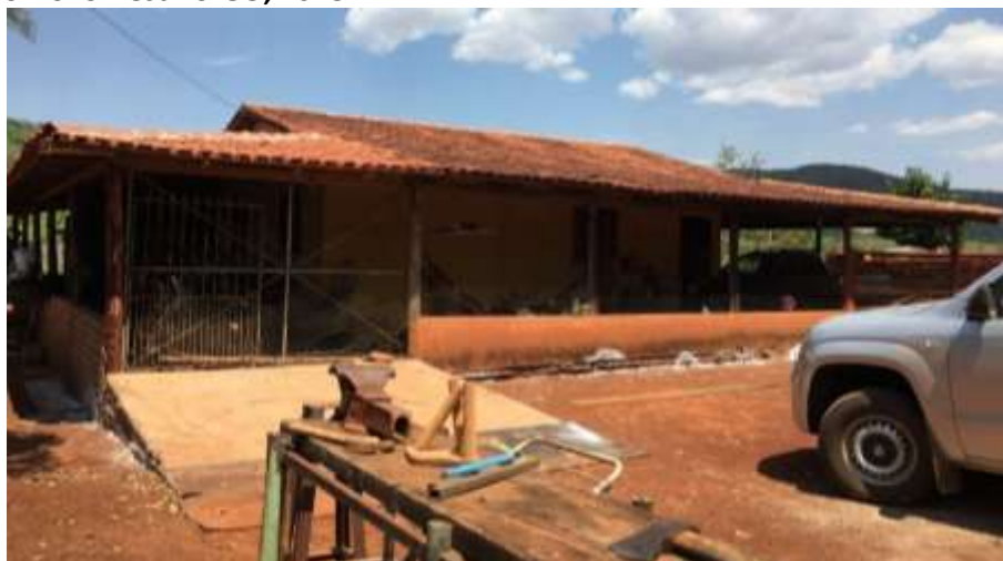
Foto 4.7 – Piso de residência constituído de concreto bruto, identificado na Comunidade São Thiago, Santa Rita do Novo Destino-GO, 2018.
