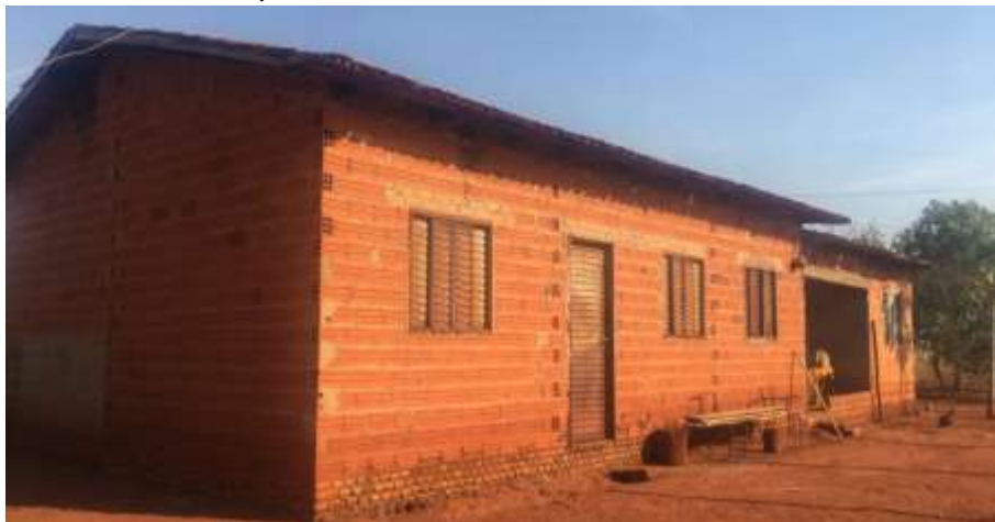
Foto 4.6 – Habitação construída de alvenaria sem reboco, identificada na Comunidade São Thiago, Santa Rita do Novo Destino-GO, 2018.
