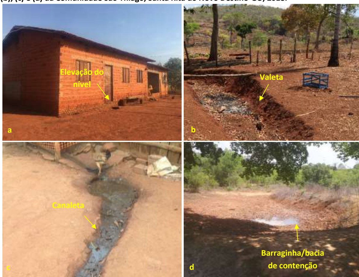
Foto 6.20 – Dispositivos de prevenção dos danos provocados pelas águas em residência (a) e lotes (b), (c) e (d) da Comunidade São Thiago, Santa Rita do Novo Destino-GO, 2018.
