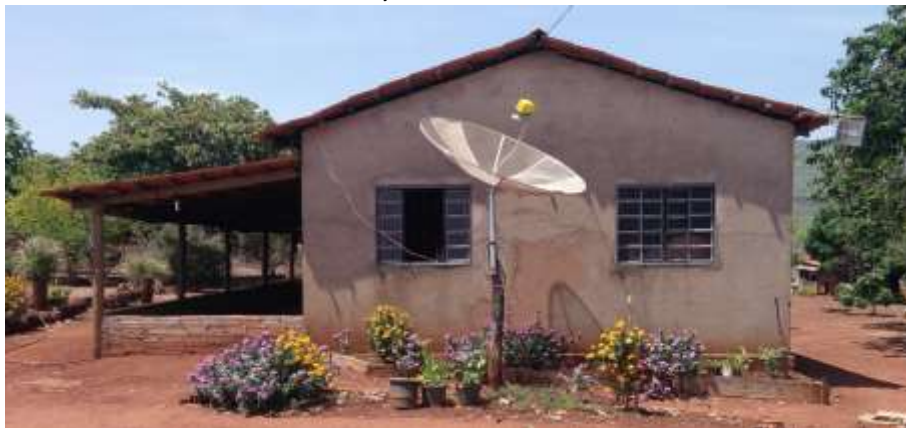
Foto 4.5 – Habitação construída de alvenaria com reboco sem pintura, identificada na Comunidade São Thiago, Santa Rita do Novo Destino-GO, 2018.
