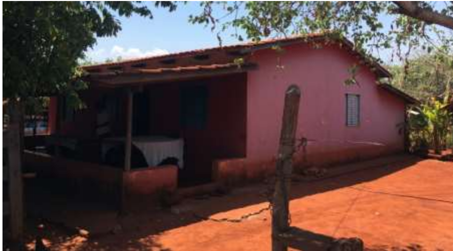
Foto 4.4 – Habitação construída de alvenaria com reboco e pintura, identificada na Comunidade São Thiago, Santa Rita do Novo Destino-GO, 2018.
