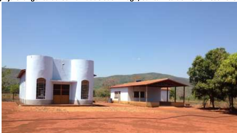
Foto 4.1 – Igreja evangélica da Comunidade São Thiago, Santa Rita do Novo Destino-GO, 2018.
