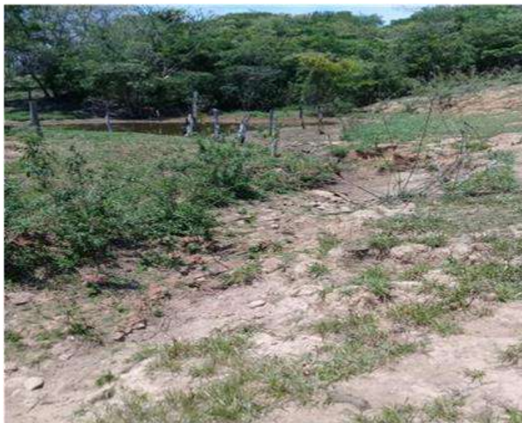
Foto 6.21 – Exemplo de processo erosivo em lote da Comunidade São Sebastião da Garganta, Silvânia-GO, 2018.
