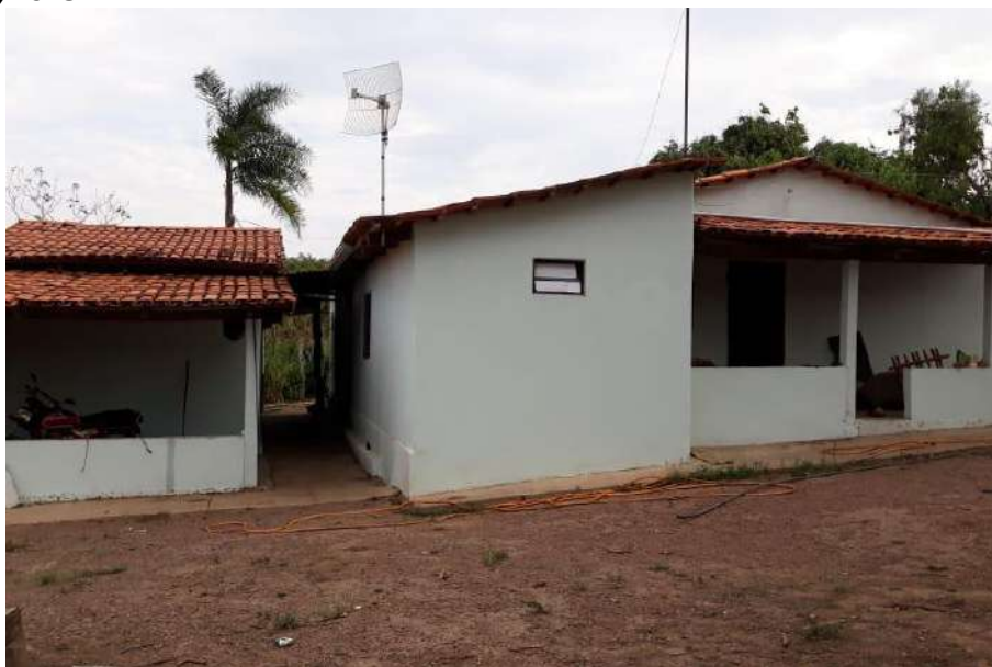
Foto 4.7 – Cobertura de telha de barro, identificada na Comunidade São Sebastião da Garganta, Silvânia-GO, 2018.
