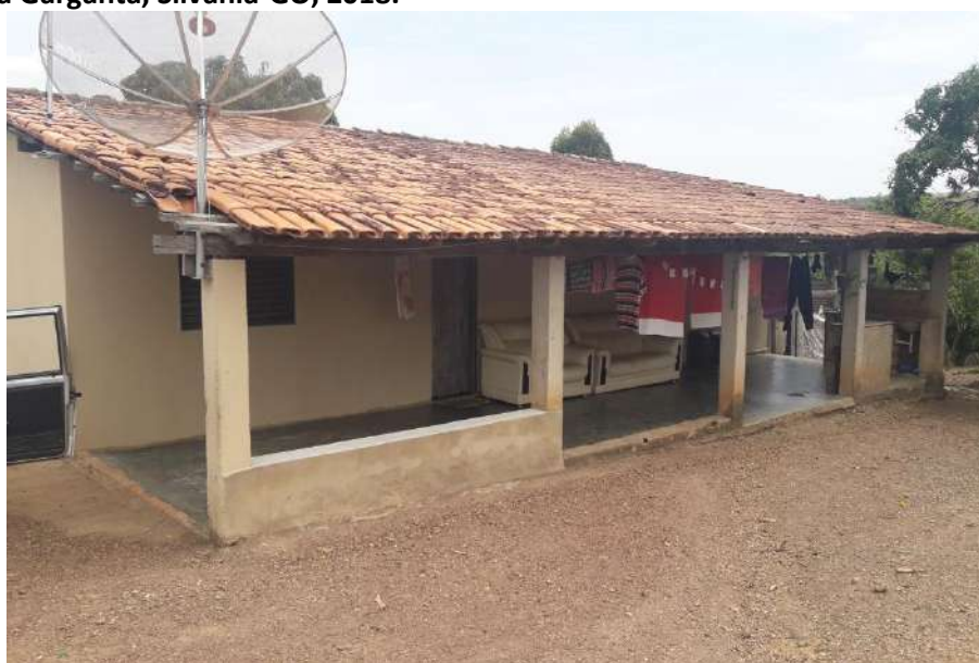
Foto 4.5 – Piso de residência constituído de cimento queimado, identificado na Comunidade São Sebastião da Garganta, Silvânia-GO, 2018.
