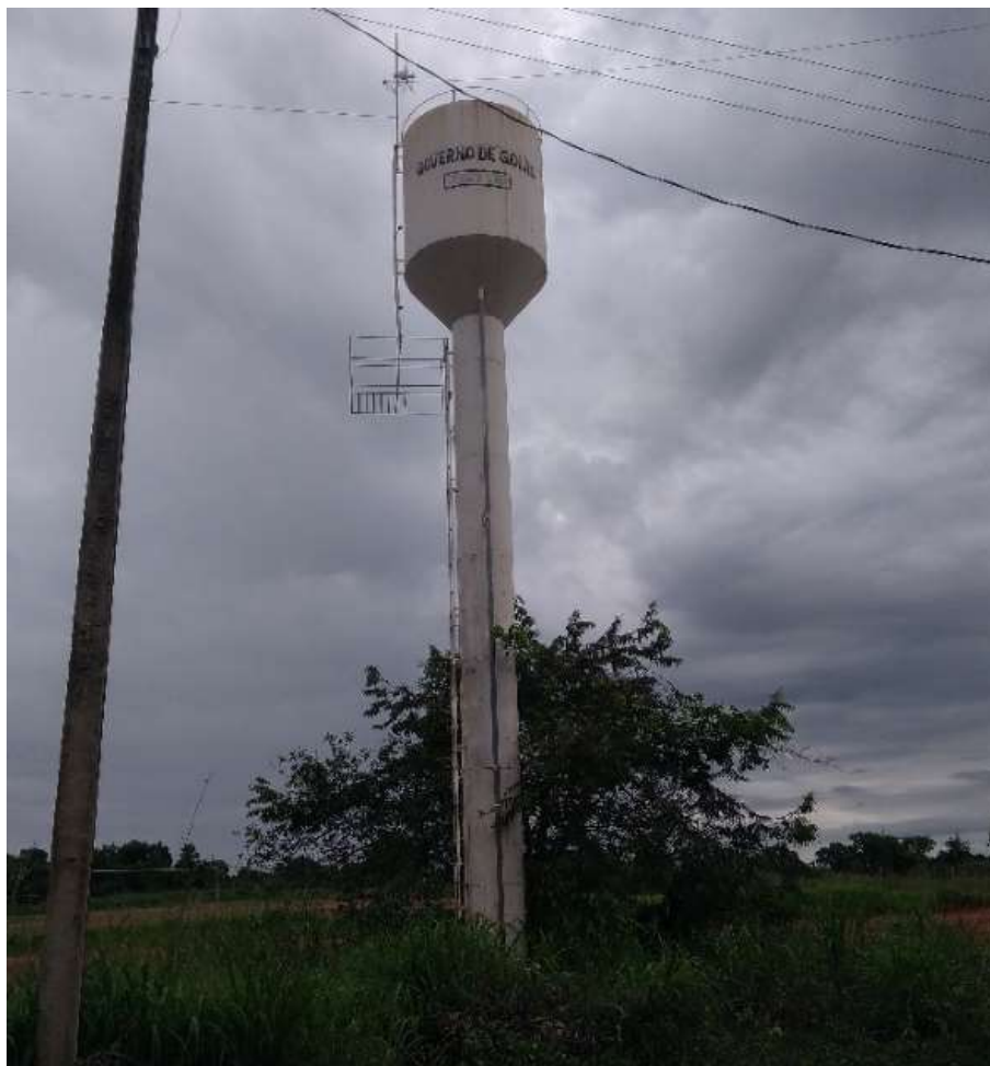
Foto 6.3 – Reservatório de água do núcleo comunitário da Comunidade São Salvador, Minaçu-GO, 2018.
