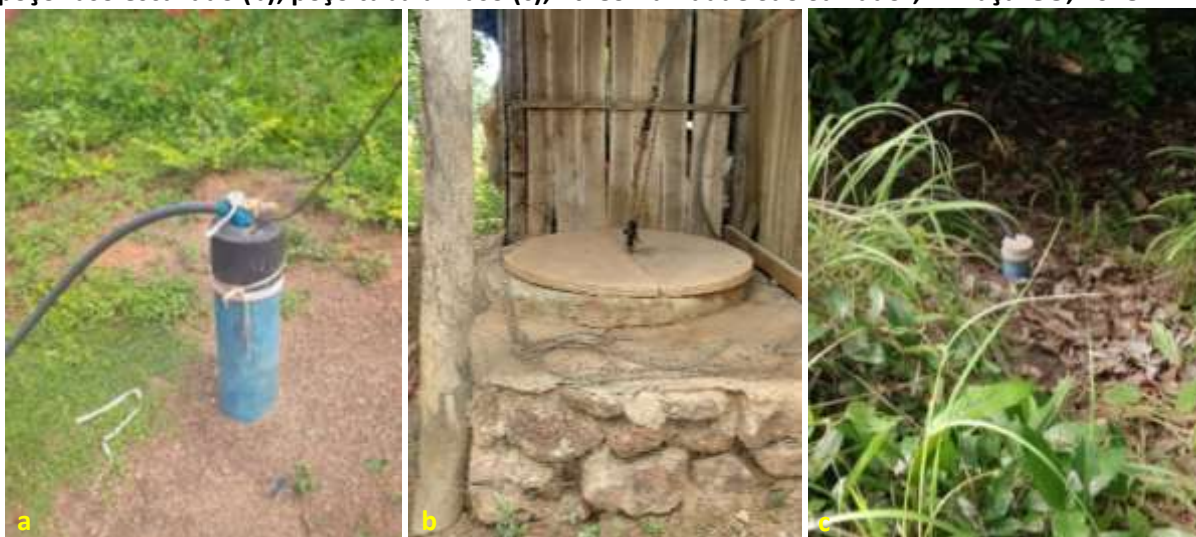
Foto 6.1 – Fontes de abastecimento de água utilizadas para ingestão: poço tubular profundo (a); poço raso escavado (b); poço tubular raso (c), na Comunidade São Salvador, Minaçu-GO, 2018.
