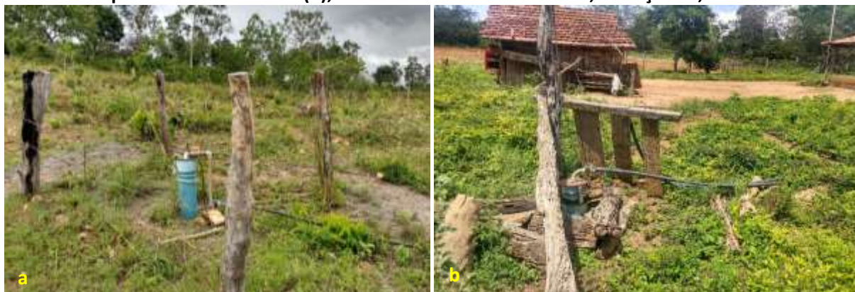
Foto 6.5 – Poço tubular profundo com cerca de proteção (a) e poço tubular profundo protegido em estrutura improvisada de madeira (b), na Comunidade São Salvador, Minaçu-GO, 2018.
