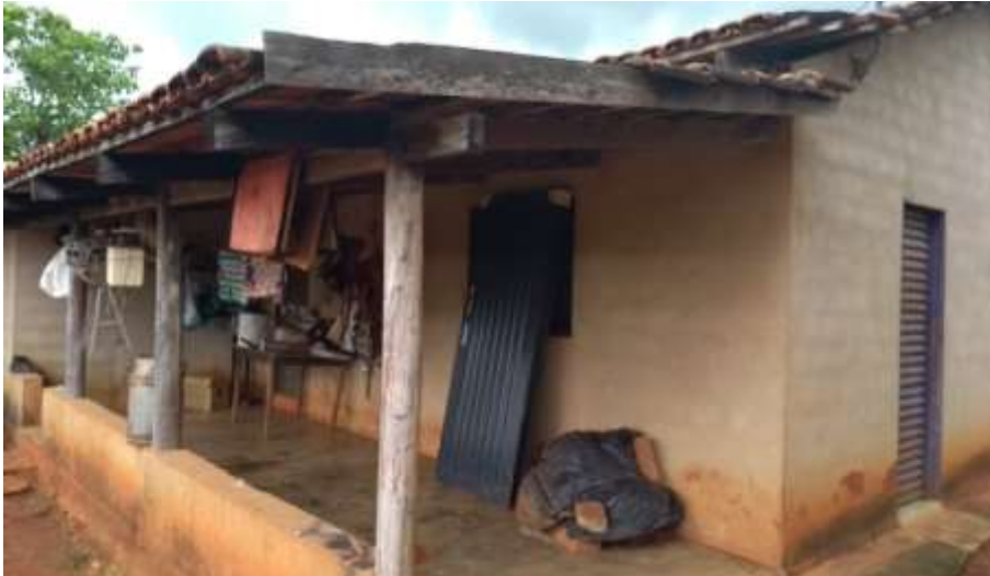
Foto 4.7 – Habitação construída de alvenaria com reboco, identificada na Comunidade São Salvador, Minaçu-GO, 2018.
