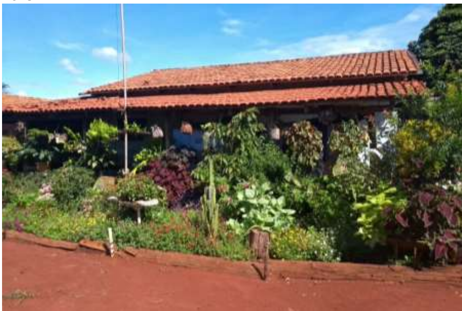
Foto 4.11 – Cobertura de telha de barro, identificada nas habitações da Comunidade São Salvador, Minaçu-GO, 2018.
