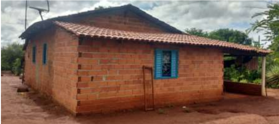
Foto 4.6 – Habitação construída de alvenaria sem reboco, identificada na Comunidade São Salvador, Minaçu-GO, 2018.
