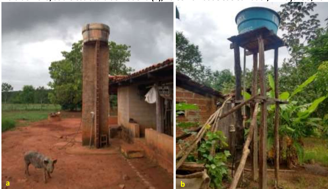
Foto 6.7 – Reservatórios domiciliares de fibrocimento instalados sobre estrutura em alvenaria (a) e de fibra de vidro, sobre estrutura de madeira (b), na Comunidade São Salvador, Minaçu-GO, 2018.
