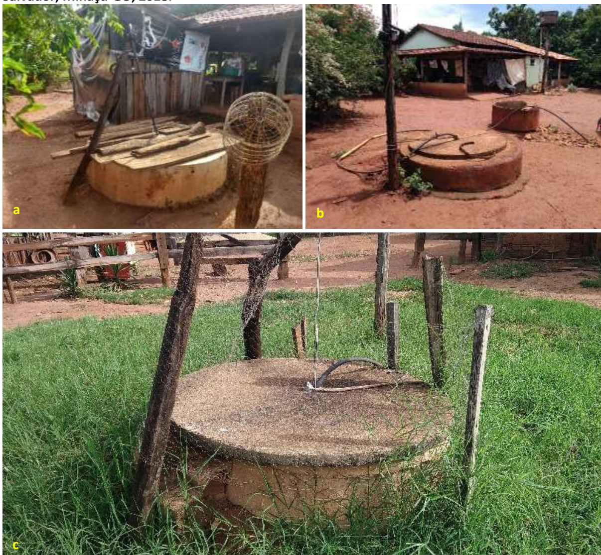
Foto 6.4 – Poço raso escavado: com mureta e tampado com madeira (a), com mureta e tampa de concreto (b), com mureta, tampa de concreto e com cerca de proteção (c), na Comunidade São Salvador, Minaçu-GO, 2018.
