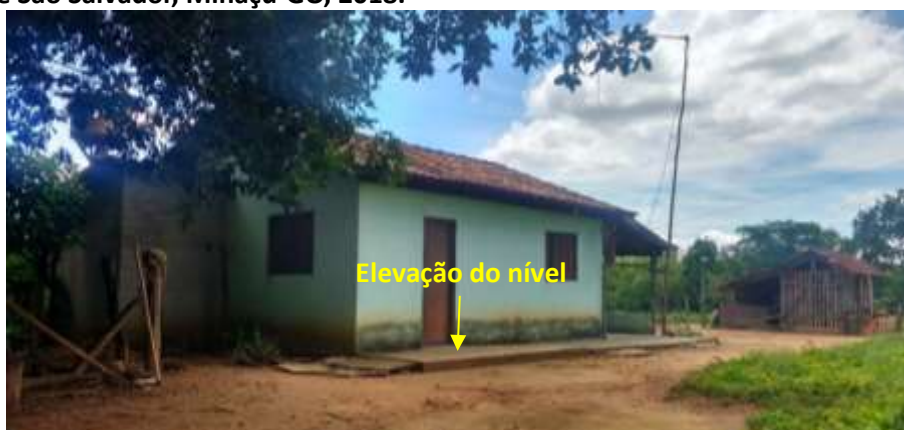
Foto 6.25 – Dispositivo de prevenção dos danos provocados pelas águas em residência da Comunidade São Salvador, Minaçu-GO, 2018.
