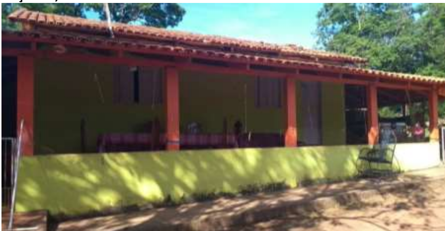
Foto 4.8 – Habitação construída de alvenaria com reboco e pintura, identificada na Comunidade São Salvador, Minaçu-GO, 2018.
