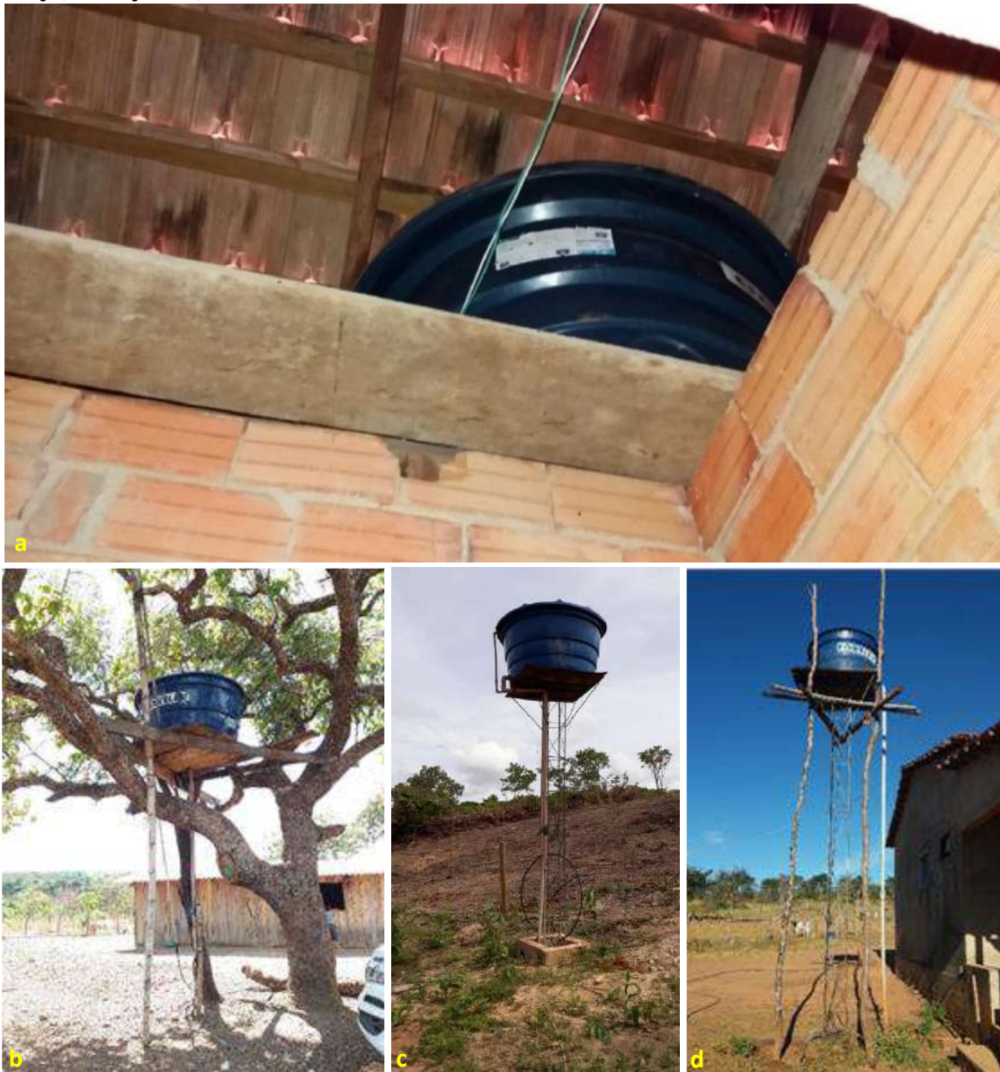
Foto 6.5 – Reservatório domiciliar instalado dentro do domicílio (a), sobre estrutura de madeira, apoiado em uma árvore (b), estrutura metálica (c) e metálica com madeira (d), Comunidade São Lourenço, Uruaçu-GO, 2018.
