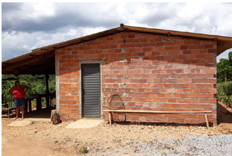
Foto 4.6 – Cobertura de telha fibrocimento, identificada na Comunidade São Lourenço, Uruaçu-GO, 2018.
