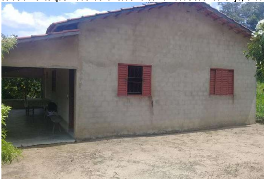
Foto 4.3 – Piso de cimento queimado identificado na Comunidade São Lourenço, Uruaçu-GO, 2018.
