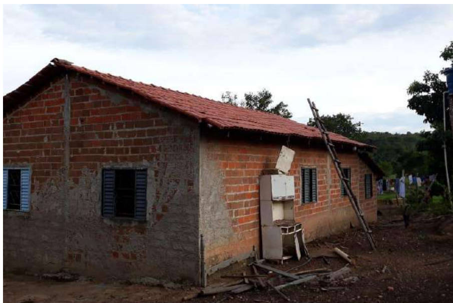
Foto 4.5 – Cobertura de telha de barro, identificada na Comunidade São Lourenço-GO, Uruaçu-GO, 2018.
