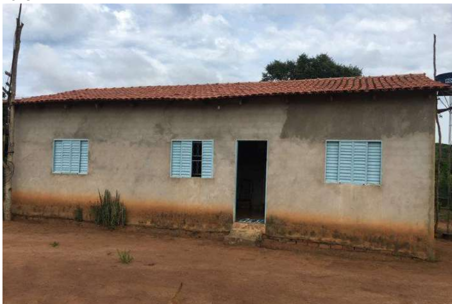
Foto 4.1 – Habitação construída de alvenaria com reboco, identificada na Comunidade São Lourenço, Uruaçu-GO, 2018.
