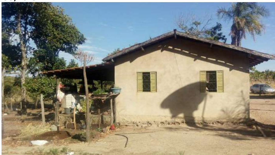
Foto 4.6 – Habitação construída de alvenaria com reboco, identificada na Comunidade São Judas, Nova Crixás-GO, 2018.
