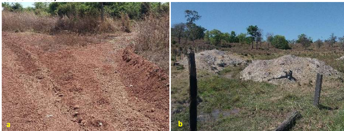
Foto 6.17 – Valeta (a) e ponto de extração de areia (b) na via de acesso à Comunidade São Judas, Nova Crixás-GO, 2018.
