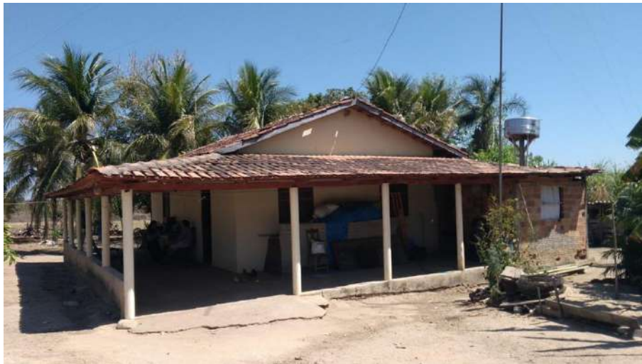
Foto 4.9 – Cobertura de telha de barro, identificada nas habitações da Comunidade São Judas– Nova Crixás-GO, 2018.
