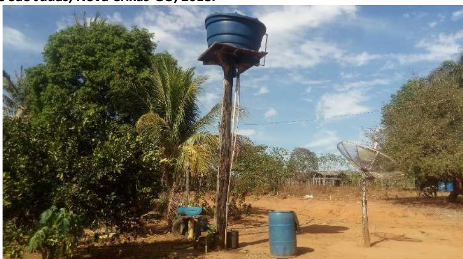
Foto 6.6 – Reservatórios domiciliares de polietileno, com tampa e sobre estrutura de madeira, na Comunidade São Judas, Nova Crixás-GO, 2018.
