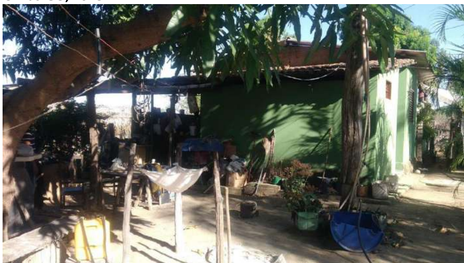
Foto 4.7 – Habitação construída de alvenaria com reboco e pintura, identificada na Comunidade São Judas, Nova Crixás-GO, 2018.
