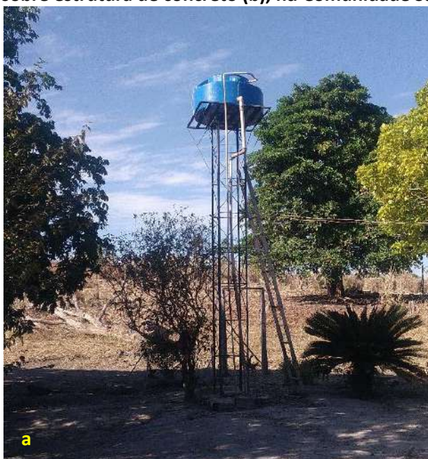
Foto 6.7 – Reservatórios domiciliares: polietileno sobre estrutura metálica (a) e de fibra de vidro sobre estrutura de concreto (b), na Comunidade São Judas, Nova Crixás-GO, 2018.
