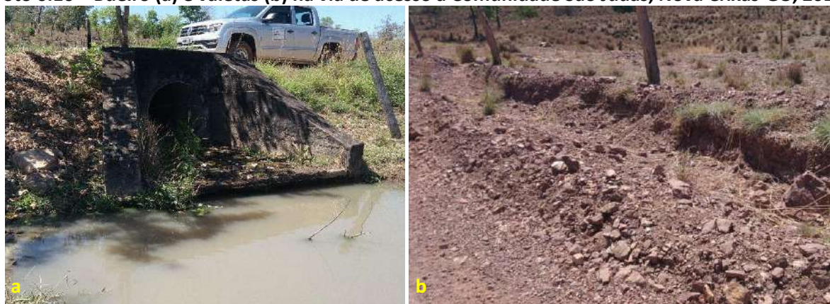
Foto 6.16 – Bueiro (a) e valetas (b) na via de acesso à Comunidade São Judas, Nova Crixás-GO, 2018.
