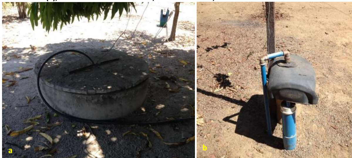
Foto 6.1 – Fontes de abastecimento de água utilizadas para ingestão: poço raso escavado (a), poço tubular raso (b), na Comunidade São Judas, Nova Crixás-GO, 2018.
