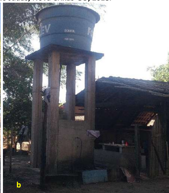
Foto 6.7 – Reservatórios domiciliares: polietileno sobre estrutura metálica (a) e de fibra de vidro sobre estrutura de concreto (b), na Comunidade São Judas, Nova Crixás-GO, 2018.
