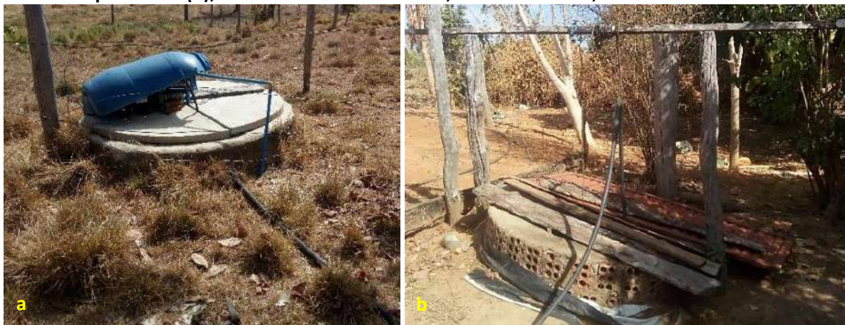
Foto 6.5 – Diferentes formas de tampar um poço raso escavado: com tampa de concreto (a) e com material improvisado (b), na Comunidade São Judas, Nova Crixás-GO, 2018.
