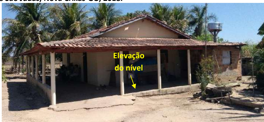
Foto 6.20 – Dispositivo de prevenção dos danos provocados pelas águas em residência da Comunidade São Judas, Nova Crixás-GO, 2018.
