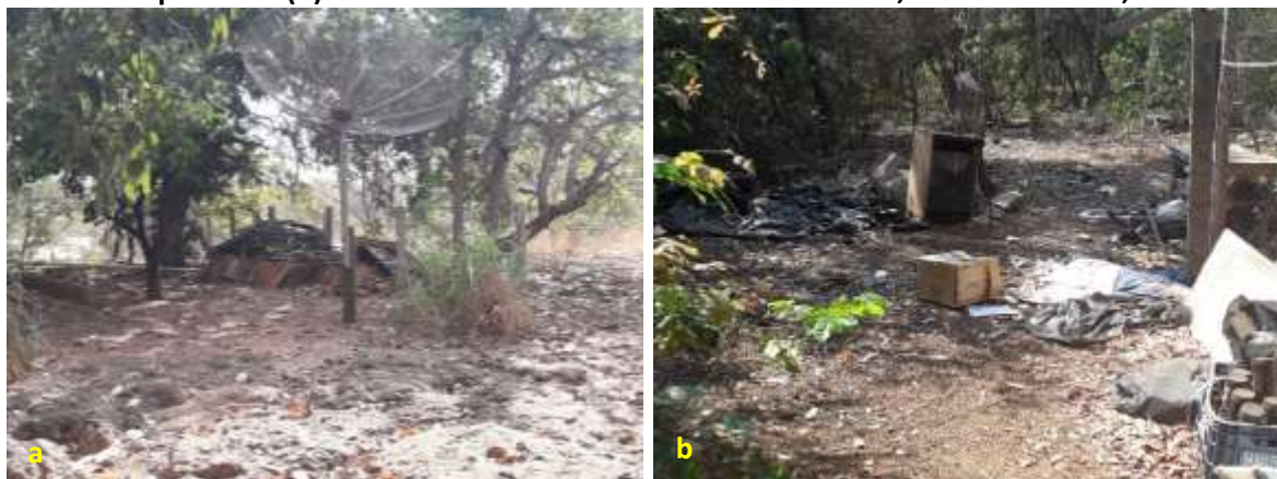
Foto 6.19 – Presença, nos quintais, de materiais de construção, tipo: telhas cerâmica (a) de resíduos e variados espalhados (b) na Comunidade São José dos Bandeirantes, Nova Crixás-GO, 2019.
