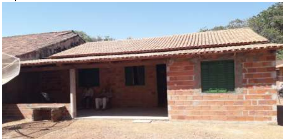
Foto 4.20 – Cobertura de telha de barro, identificada na Comunidade São José dos Bandeirantes, Nova Crixás-GO, 2019.
