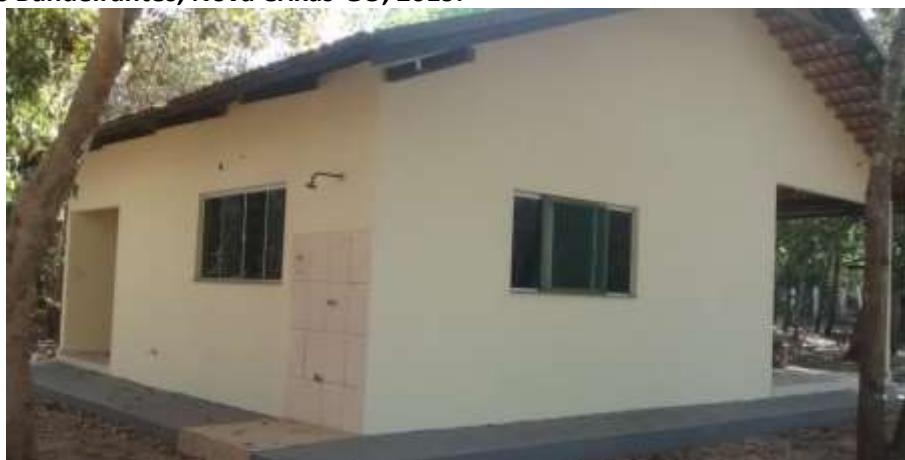
Foto 4.14 – Habitação construída de alvenaria com reboco e pintura, identificada na Comunidade São José dos Bandeirantes, Nova Crixás-GO, 2019.
