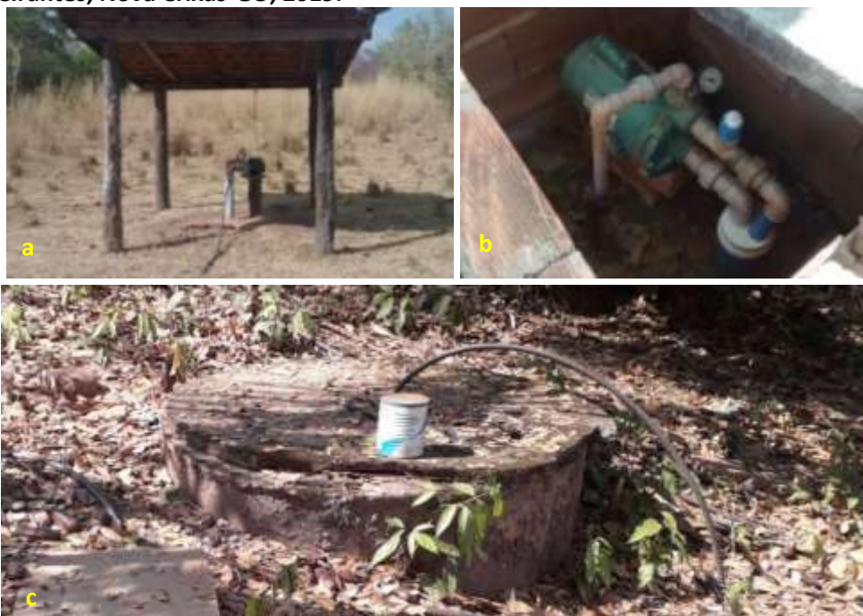
Foto 6.1 – Poço tubular raso (a), poço tubular (b) e poço raso escavado (c), na Comunidade São José dos Bandeirantes, Nova Crixás-GO, 2019.
