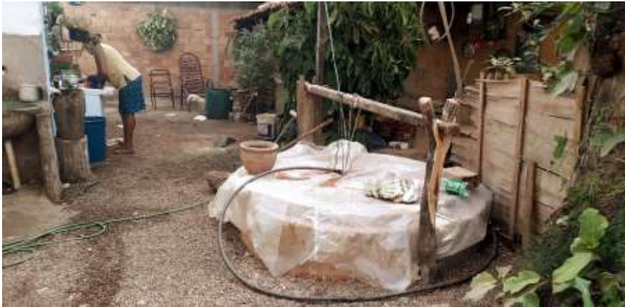
Foto 6.6 – Poço raso escavado com mureta, calçada ao redor, e lona sobre a tampa de concreto, na Comunidade São José dos Bandeirantes, Nova Crixás-GO, 2019.
