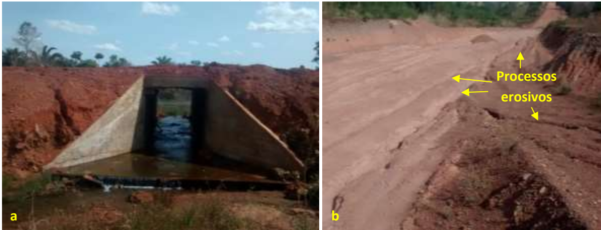
Foto 6.24 – Galeria pluvial (a) e processos erosivos (b) na via de acesso não pavimentada à Comunidade São José dos Bandeirantes, Nova Crixás-GO, 2019.
