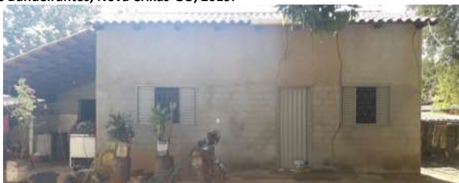
Foto 4.15 – Habitação construída de alvenaria com reboco sem pintura, identificada na Comunidade São José dos Bandeirantes, Nova Crixás-GO, 2019.
