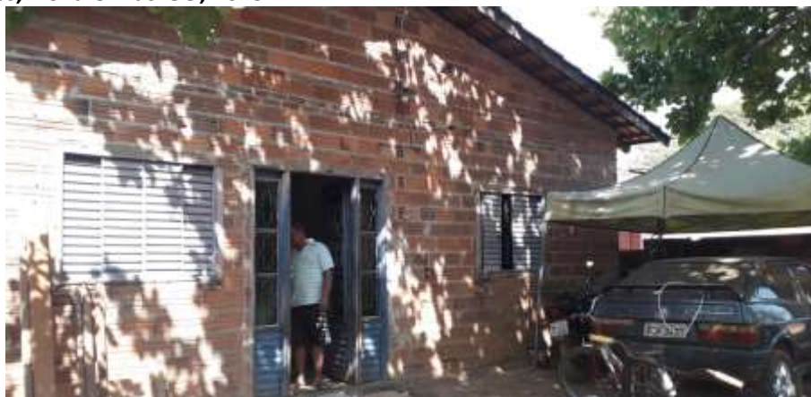
Foto 4.16 – Habitação construída de alvenaria sem reboco, identificada na Comunidade São José dos Bandeirantes, Nova Crixás-GO, 2019.
