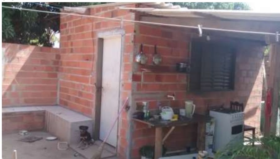
Foto 4.21 – Cobertura de fibrocimento identificada na Comunidade São José dos Bandeirantes, Nova Crixás-GO, 2019.
