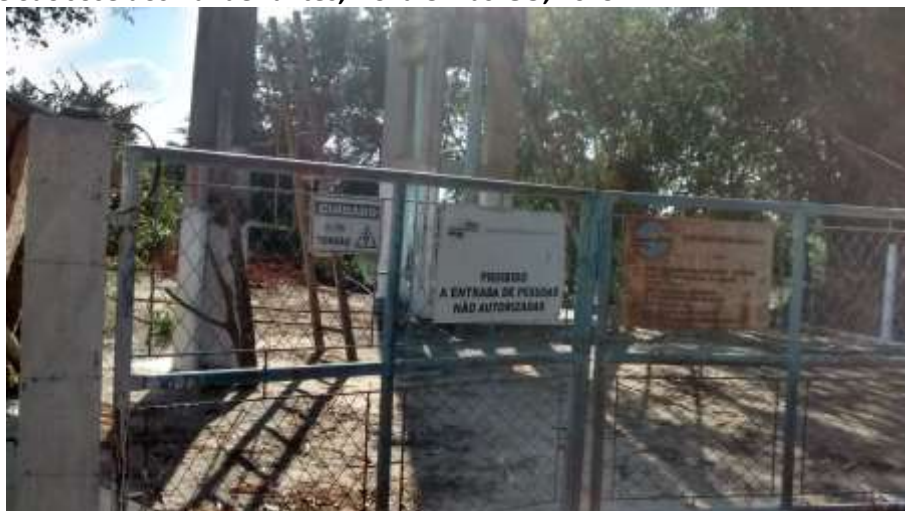
Foto 6.2 – Area de captação do Sistema de Abastecimento de Água cercada e com identificação, na Comunidade São José dos Bandeirantes, Nova Crixás-GO, 2019.
