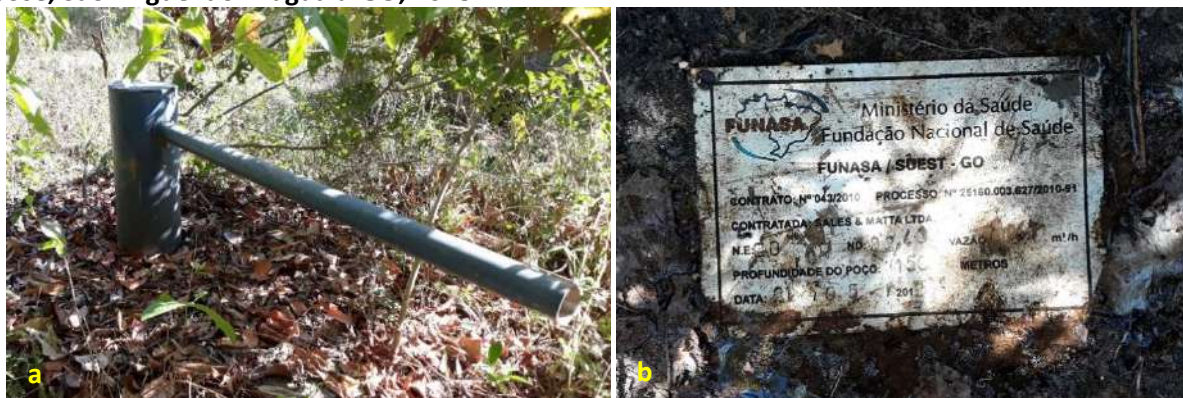
Foto 6.2 – Poço tubular profundo sem uso (a) e etiqueta de identificação (b), na Comunidade São José, São Miguel do Araguaia-GO, 2018.
