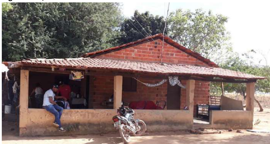
Foto 4.2 – Habitação construída de alvenaria sem reboco, identificada na Comunidade São José, São Miguel do Araguaia-GO, 2018.
