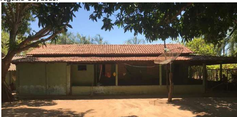
Foto 4.6 – Cobertura de telha de barro, identificada nas habitações da Comunidade São José, São Miguel do Araguaia-GO, 2018.
