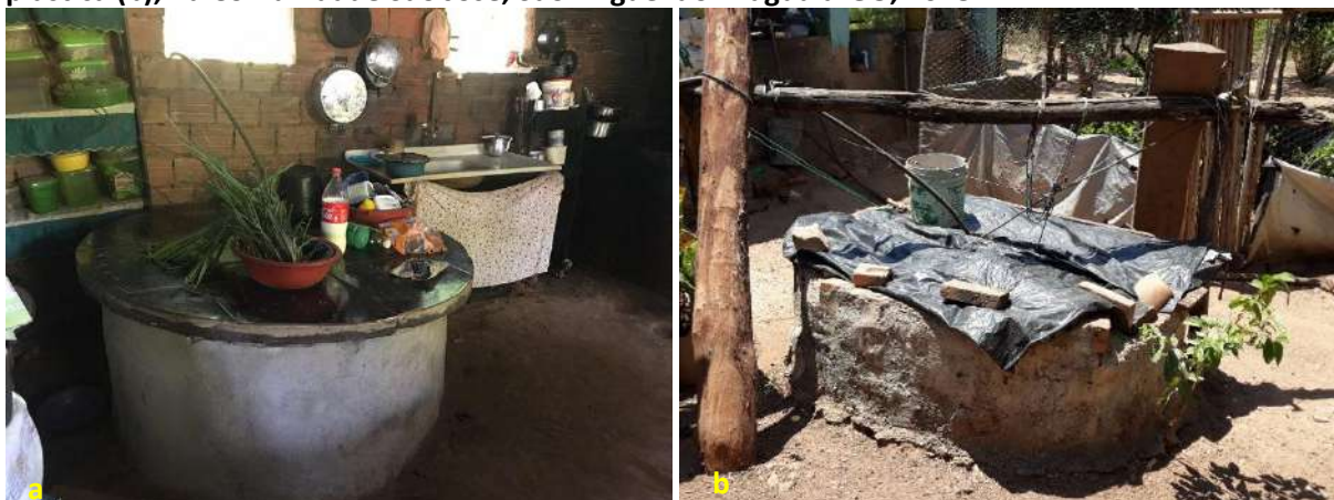
Foto 6.3 – Poço raso escavado com tampa de concreto (a) e poço raso escavado tampado com lona plástica (b), na Comunidade São José, São Miguel do Araguaia-GO, 2018.
