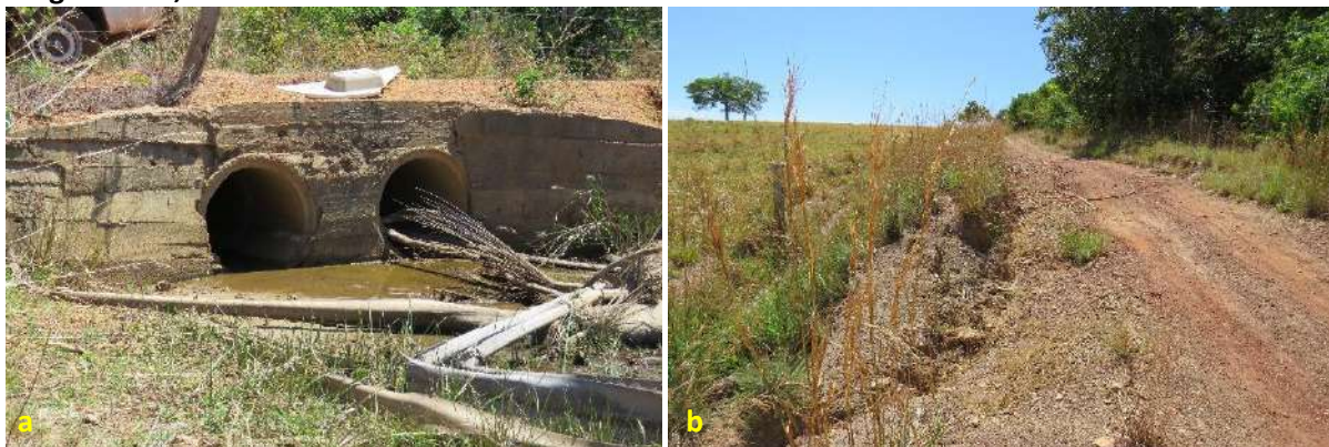
Foto 6.17 – Bueiro (a) e processo erosivo (b) na via de acesso à Comunidade São José, São Miguel do Araguaia-GO, 2018.
