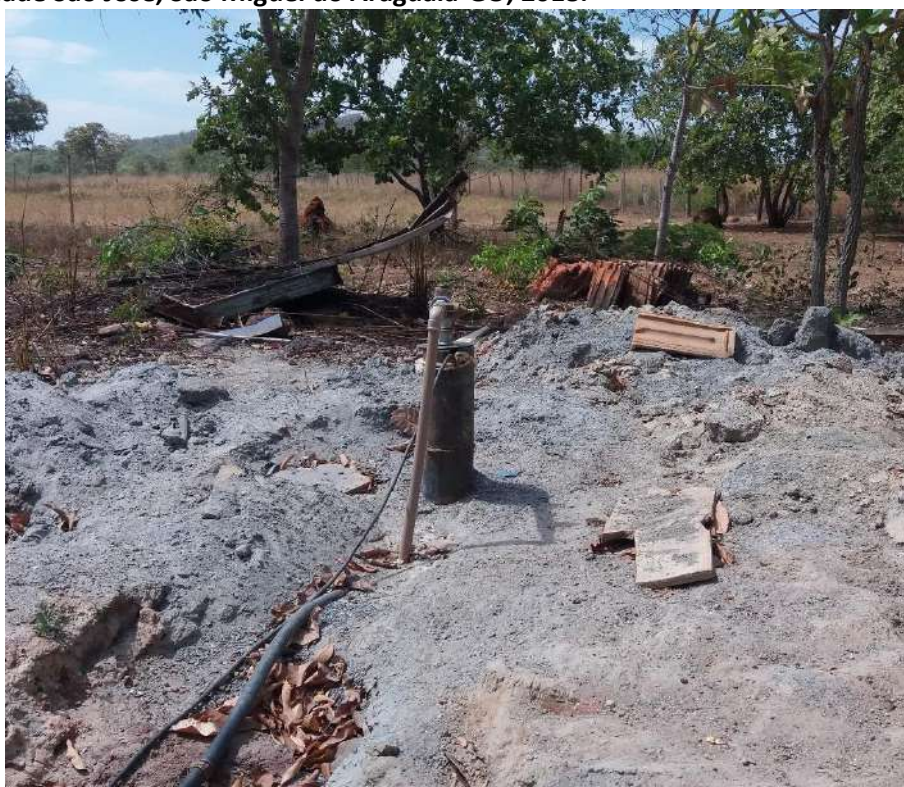
Foto 6.5 – Poço tubular profundo com ausência de cerca ou qualquer outra estrutura de proteção, na Comunidade São José, São Miguel do Araguaia-GO, 2018.
