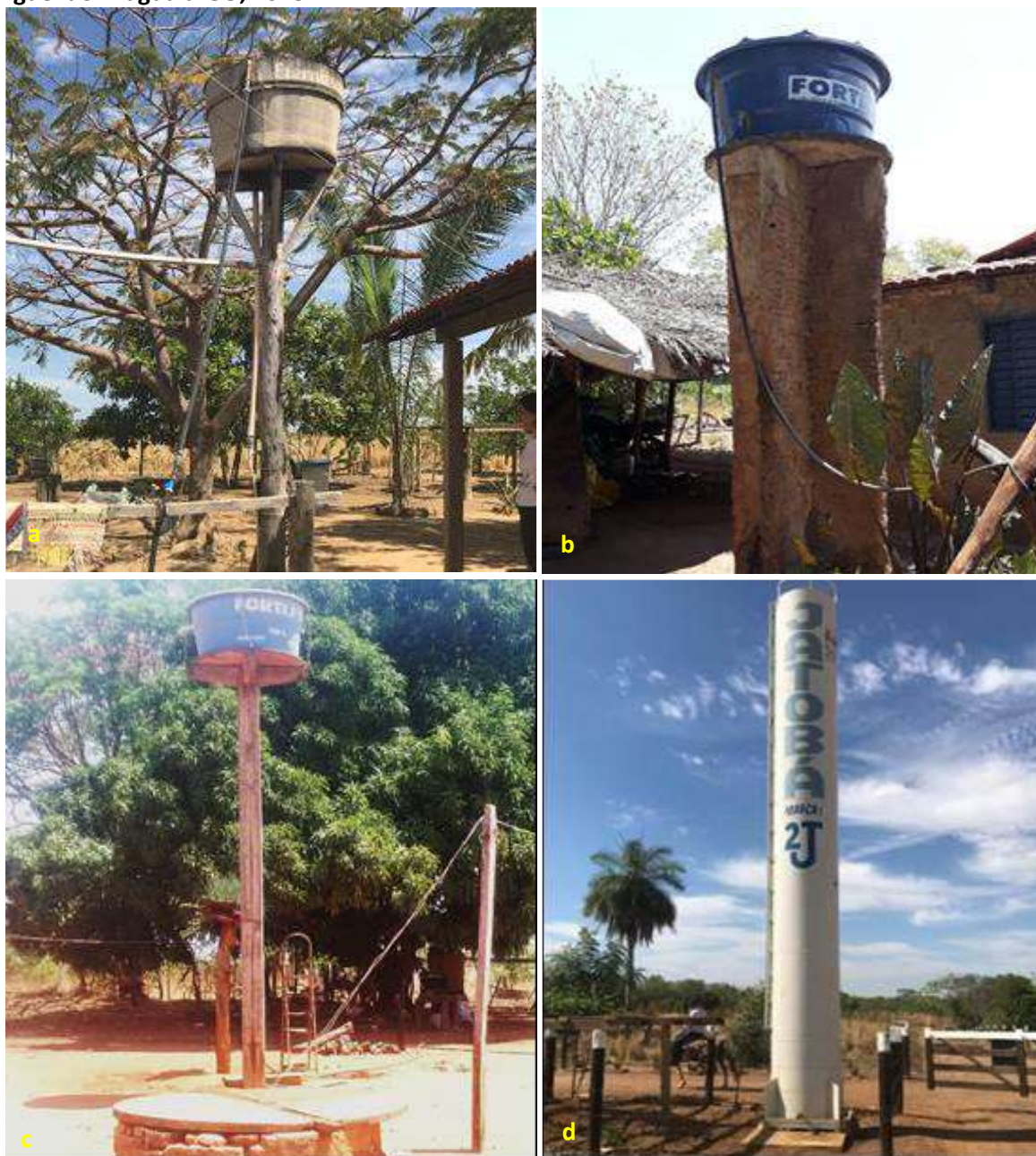
Foto 6.7 – Reservatório em fibrocimento, instalado sobre uma estrutura em madeira (a), reservatório em polietileno instalado sobre estrutura em alvenaria (b), reservatório em fibra de vidro sobre uma estrutura em concreto (c) e reservatório em aço (d), na Comunidade São José, São Miguel do Araguaia-GO, 2018.
