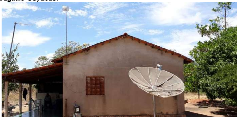
Foto 4.3 – Habitação construída de alvenaria com reboco, identificada na Comunidade São José, São Miguel do Araguaia-GO, 2018.
