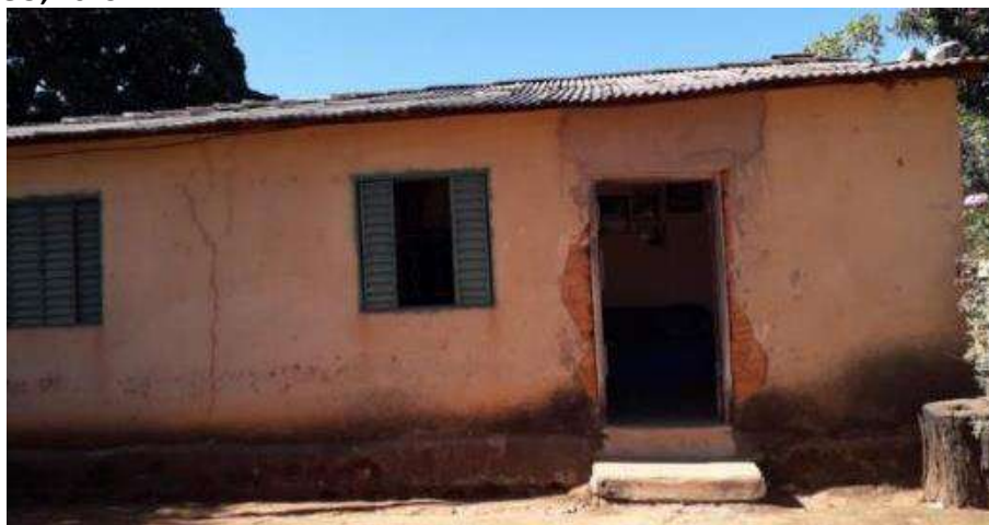
Foto 4.12 – Habitação construída de adobe com reboco, identificada na Comunidade São Domingos, Cavalcante-GO, 2019.
