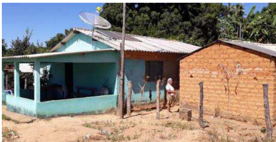
Foto 4.13 – Habitação com reboco e pintura, identificada na Comunidade São Domingos, Cavalcante-GO, 2019.
