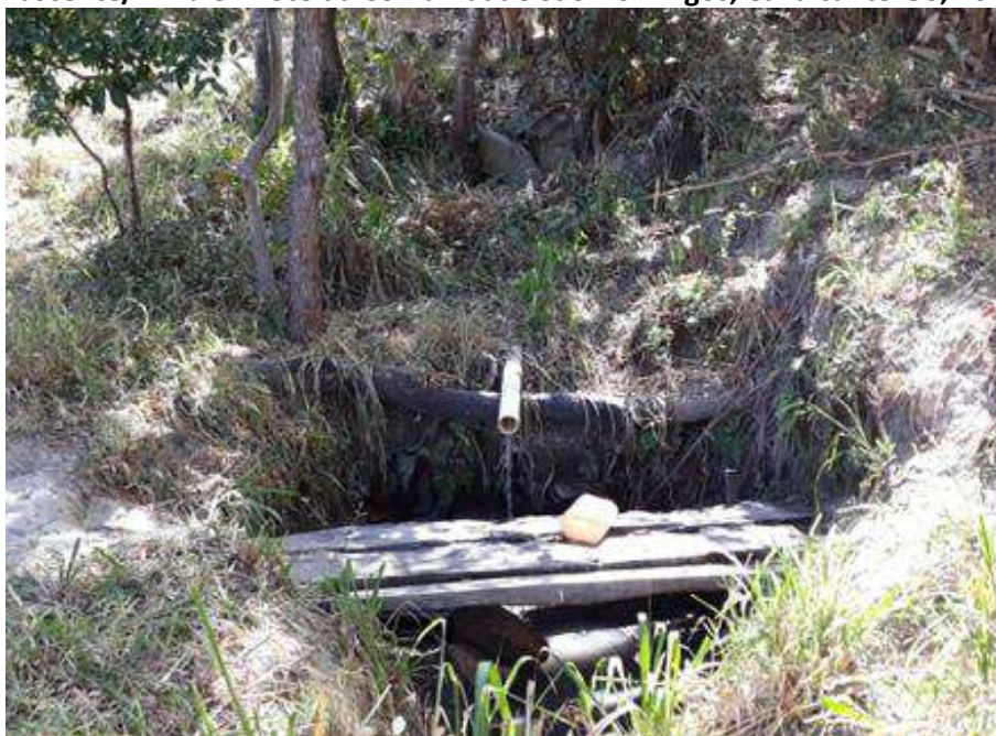
Foto 6.25 – Nascente/mina em lote da Comunidade São Domingos, Cavalcante-Go, 2019.
