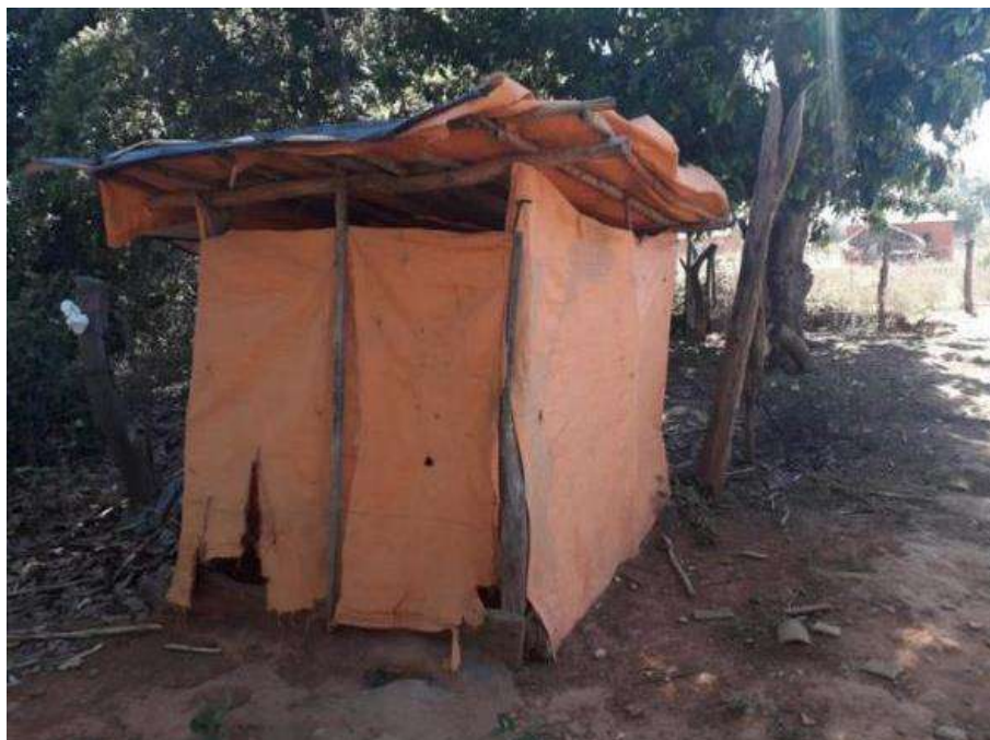
Foto 4.9 – Banheiro externo (privada) identificado na Comunidade São Domingos, Cavalcante-GO, 2019.
