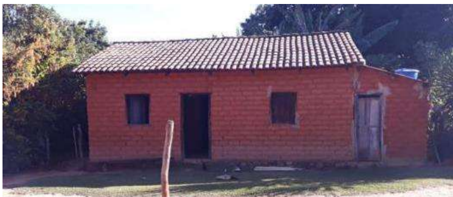
Foto 4.18 – Cobertura de telha de barro, identificada na Comunidade São Domingos, Cavalcante-GO, 2019.
