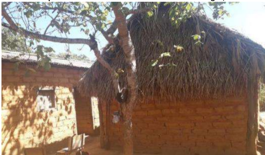
Foto 4.17 – Cobertura de palha identificada na Comunidade São Domingos, Cavalcante-GO, 2019.
