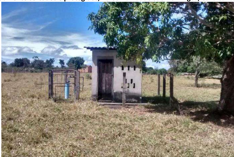
Foto 6.2 – Poço tubular profundo desativado e casa em alvenaria abrigando o seu sistema elétrico, ambos devidamente cercados e protegidos, na Comunidade São Domingos, Cavalcante-GO, 2019.
