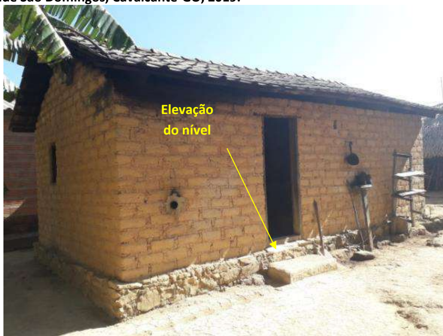
Foto 6.27 – Dispositivo de prevenção dos danos provocados pelas águas em residência da Comunidade São Domingos, Cavalcante-GO, 2019.
