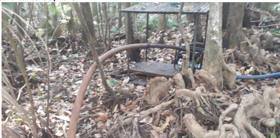
Foto 6.4 – Sistema de bombeamento da captação de água no Córrego Cachoeira, Comunidade São Domingos, Cavalcante-GO, 2019.
