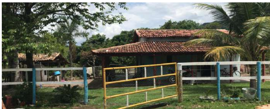
Foto 4.8 – Cobertura de telha de barro, identificada na Comunidade Santo Antônio das Areias, Faina-GO, 2018.
