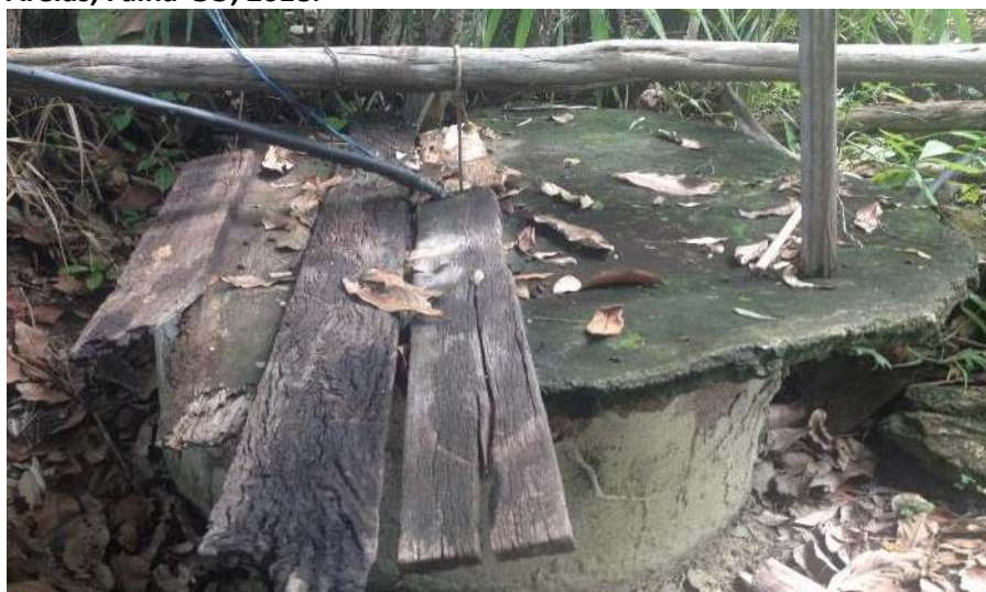
Foto 6.2 – Poço raso escavado com tampa de concreto e tábuas de madeira, na Comunidade Santo Antônio das Areias, Faina-GO, 2018.
