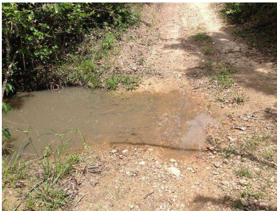
Foto 6.17 – Ponto de alagamento na via de acesso à Comunidade Santo Antônio das Areias, Faina-GO, 2018.
