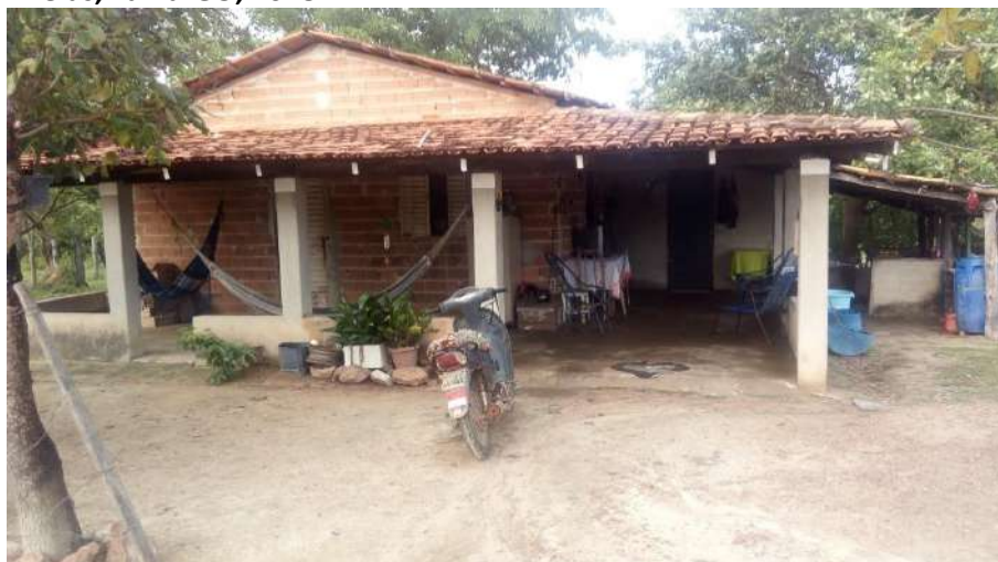
Foto 4.5 – Piso de residência constituído de concreto bruto, identificado na Comunidade Santo Antônio das Areias, Faina-GO, 2018.
