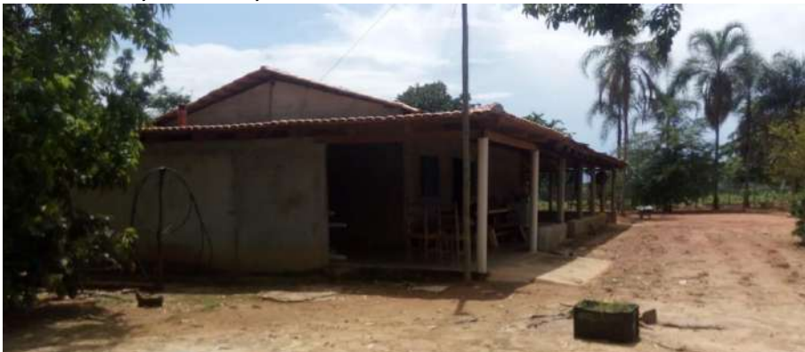
Foto 4.3 – Habitação construída de alvenaria com reboco sem pintura, identificada na Comunidade Santo Antônio das Areias, Faina-GO, 2018.
