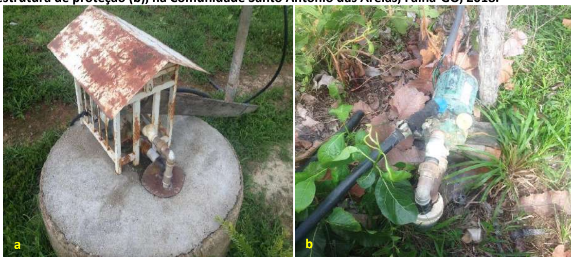
Foto 6.3 – Poço tubular raso com uma estrutura externa metálica (a) e poço tubular raso sem estrutura de proteção (b), na Comunidade Santo Antônio das Areias, Faina-GO, 2018.
