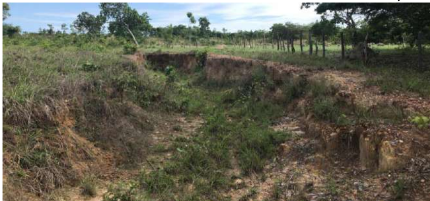
Foto 6.21 – Processo erosivo em lote da Comunidade Santo Antônio das Areias, Faina-GO, 2018.
