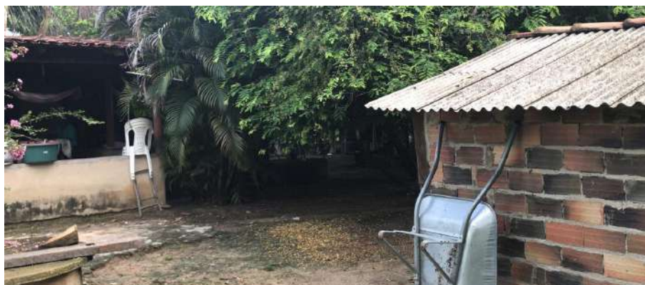
Foto 4.9 – Cobertura de fibrocimento, identificada na Comunidade Santo Antônio das Areias, Faina-GO, 2018.
