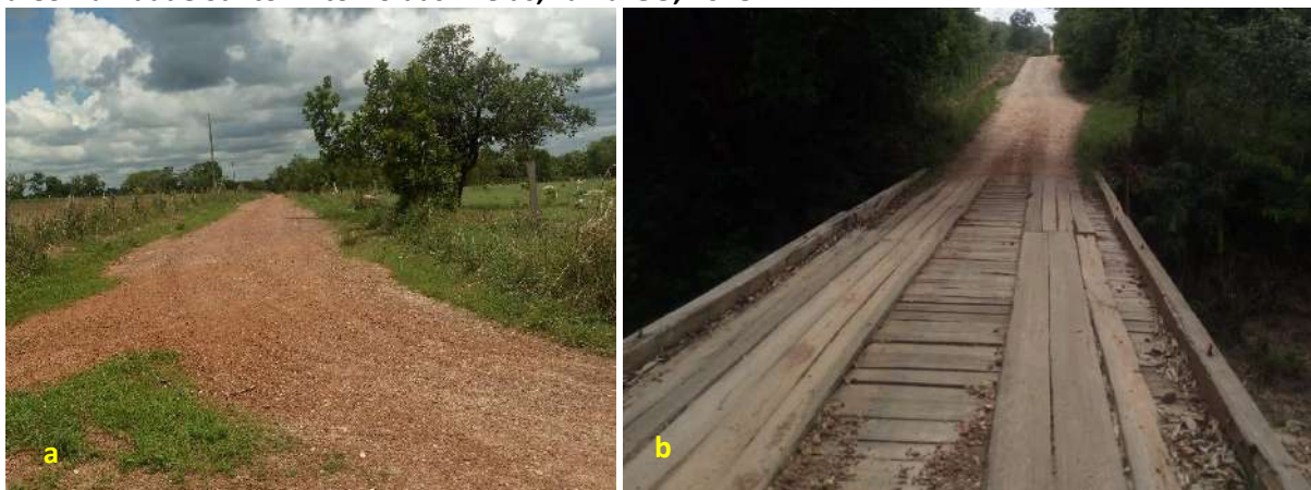
Foto 6.14 – Via de acesso não pavimentada (a) e ponte sobre córrego Taquaral na via de acesso (b) à Comunidade Santo Antônio das Areias, Faina-GO, 2018.
