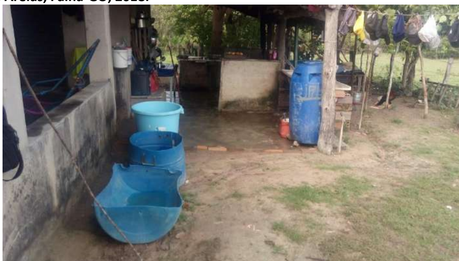
Foto 4.7 – Piso de residência constituído de cimento queimado, identificado na Comunidade Santo Antônio das Areias, Faina-GO, 2018.
