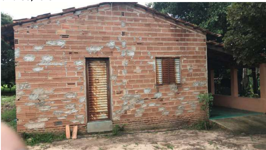
Foto 4.4 – Habitação construída de alvenaria sem reboco, identificada na Comunidade Santo Antônio das Areias, Faina-GO, 2018.
