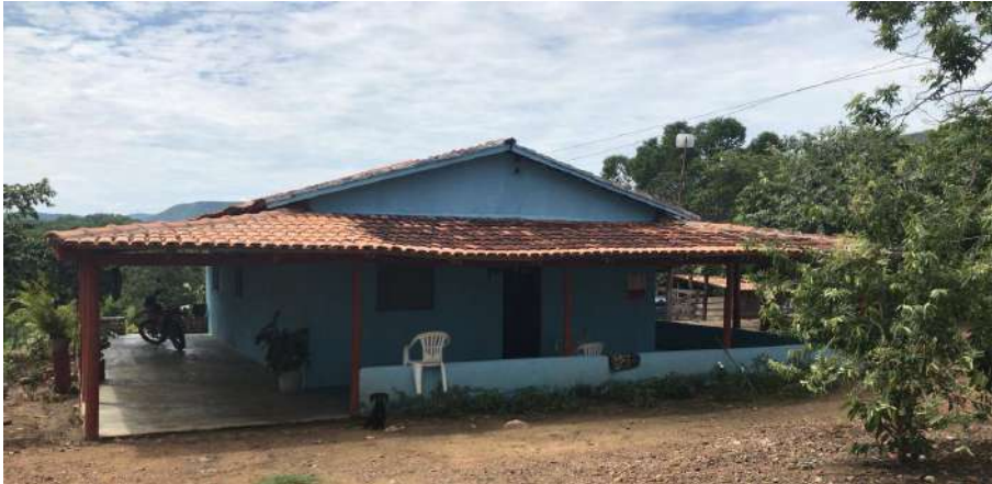
Foto 4.2 – Habitação construída de alvenaria com reboco e pintura, identificada na Comunidade Santo Antônio das Areias, Faina-GO, 2018.
