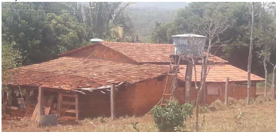
Foto 4.7 – Cobertura de telha de barro, identificada na Comunidade Santa Rita do Broeiro, Niquelândia-GO, 2018.
