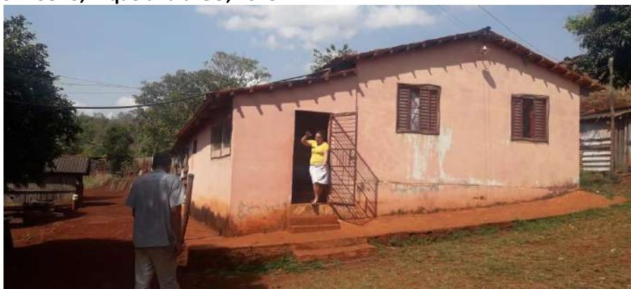
Foto 4.4 – Habitação construída de alvenaria com reboco e pintura, identificada na Comunidade Santa Rita do Broeiro, Niquelândia-GO, 2018.
