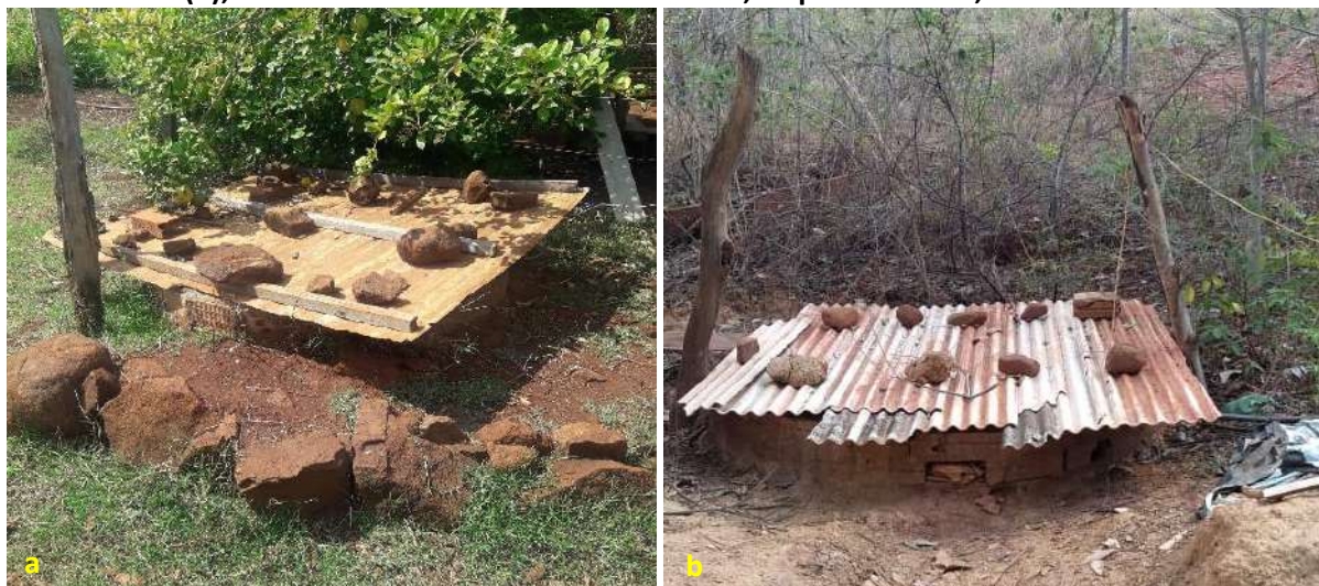
Foto 6.2 – Poço raso escavado tampado com material metálico (a) e outro tampado com telhas de fibrocimento (b), na Comunidade Santa Rita do Broeiro, Niquelândia-GO, 2018.
