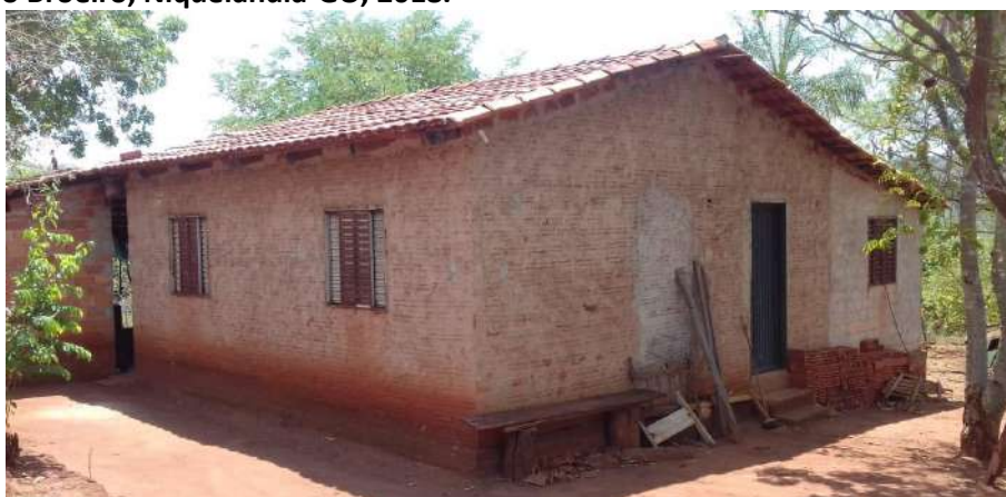
Foto 4.3 – Habitação construída de alvenaria com reboco sem pintura, identificada na Comunidade Santa Rita do Broeiro, Niquelândia-GO, 2018.
