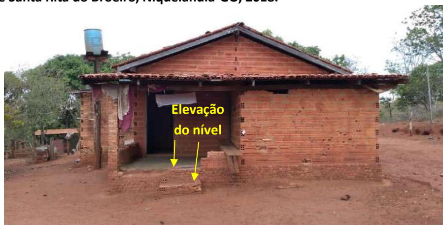
Foto 6.21 – Dispositivo de prevenção dos danos provocados pelas águas em residência da Comunidade Santa Rita do Broeiro, Niquelândia-GO, 2018.
