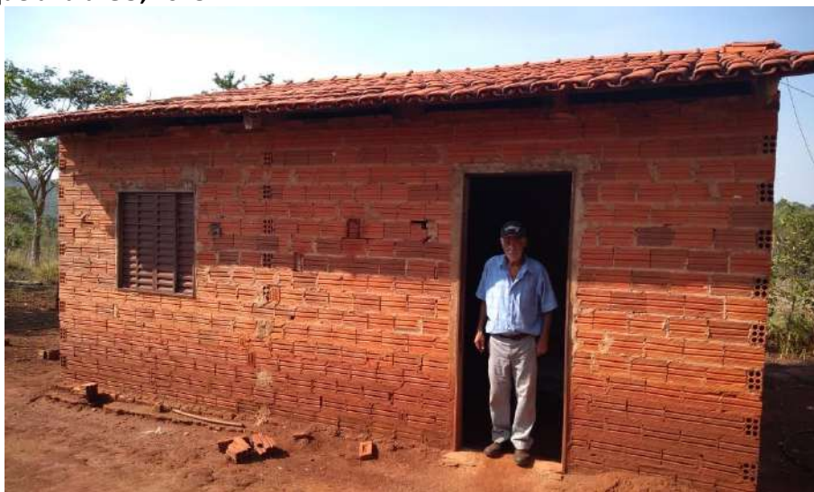
Foto 4.2 – Habitação construída de alvenaria sem reboco, identificada na Comunidade Santa Rita do Broeiro, Niquelândia-GO, 2018.
