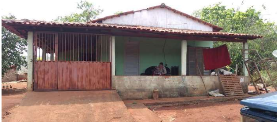
Foto 4.6 – Piso de residência constituído de concreto bruto, identificado na Comunidade Santa Rita do Broeiro, Niquelândia-GO, 2018.
