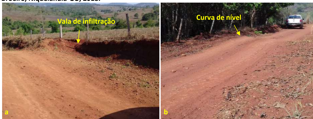
Foto 6.18 – Vala de infiltração (a) e curva de nível (b) na via de acesso à Comunidade Santa Rita do Broeiro, Niquelândia-GO, 2018.
