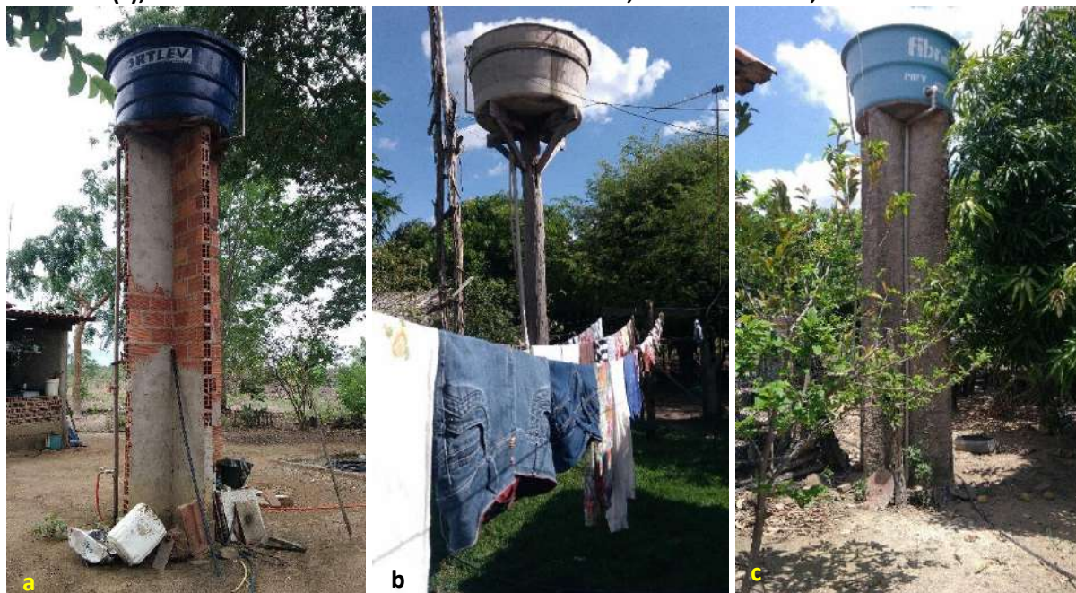
Foto 6.5 – Reservatório em polietileno sobre estrutura de alvenaria (a), reservatório em fibrocimento sobre estrutura de madeira (b), reservatório em fibra de vidro sobre estrutura de alvenaria (c), na Comunidade Santa Maria do Crixás-Assú, Nova Crixás-GO, 2018.
