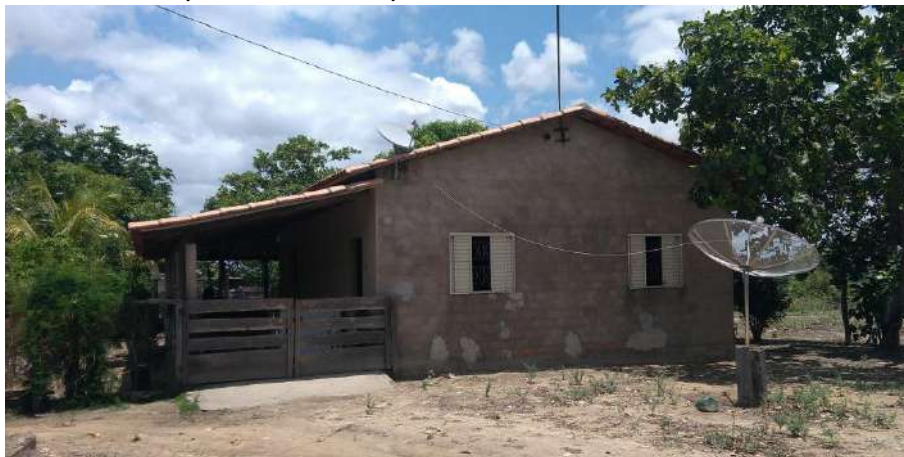
Foto 4.7 – Habitação construída de alvenaria com reboco sem pintura, identificada na Comunidade Santa Maria do Crixás-Assú, Nova Crixás-GO, 2018.
