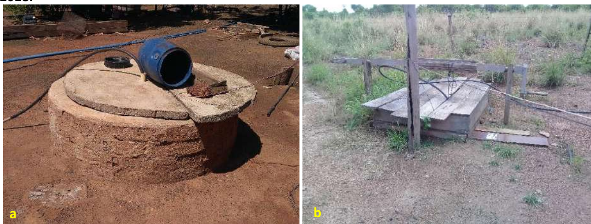
Foto 6.2 – Poço raso escavado com mureta de proteção e tampa de concreto (a) e poço raso escavado com mureta e tampa de madeira (b), na Comunidade Santa Maria do Crixás-Assú, Nova Crixás-GO, 2018.
