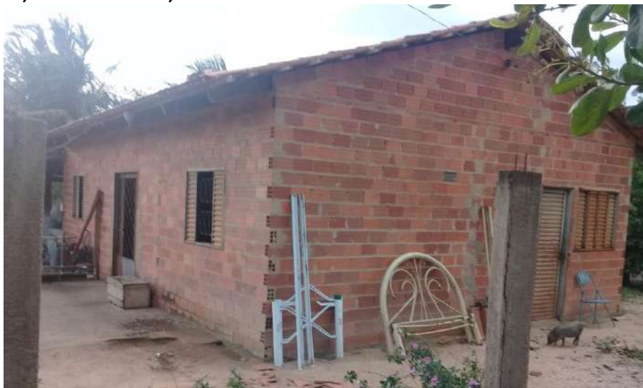
Foto 4.8 – Habitação construída de alvenaria sem reboco, identificada na Comunidade Santa Maria do Crixás-Assú, Nova Crixás-GO, 2018.
