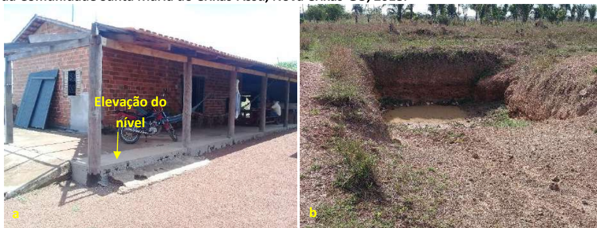
Foto 6.20 – Dispositivos de prevenção dos danos provocados pelas águas em residência (a) e lote (b) da Comunidade Santa Maria do Crixás-Assú, Nova Crixás-GO, 2018.
