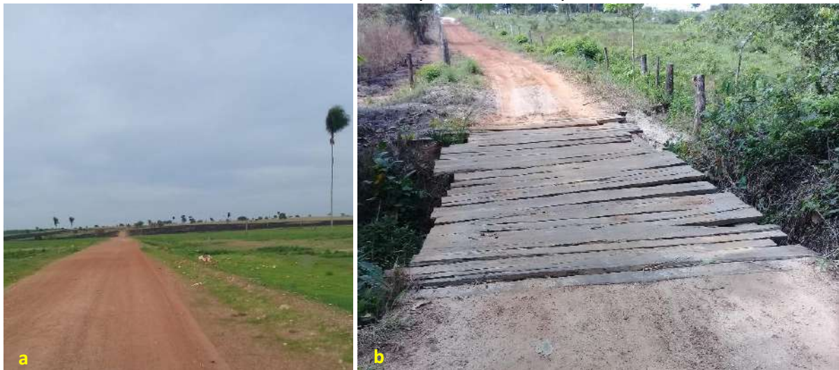
Foto 6.15 – Via de acesso não pavimentada (a) e ponte de madeira em fundo de vale (b) na via de acesso à Comunidade Santa Maria do Crixás-Assú, Nova Crixás-GO, 2018.
