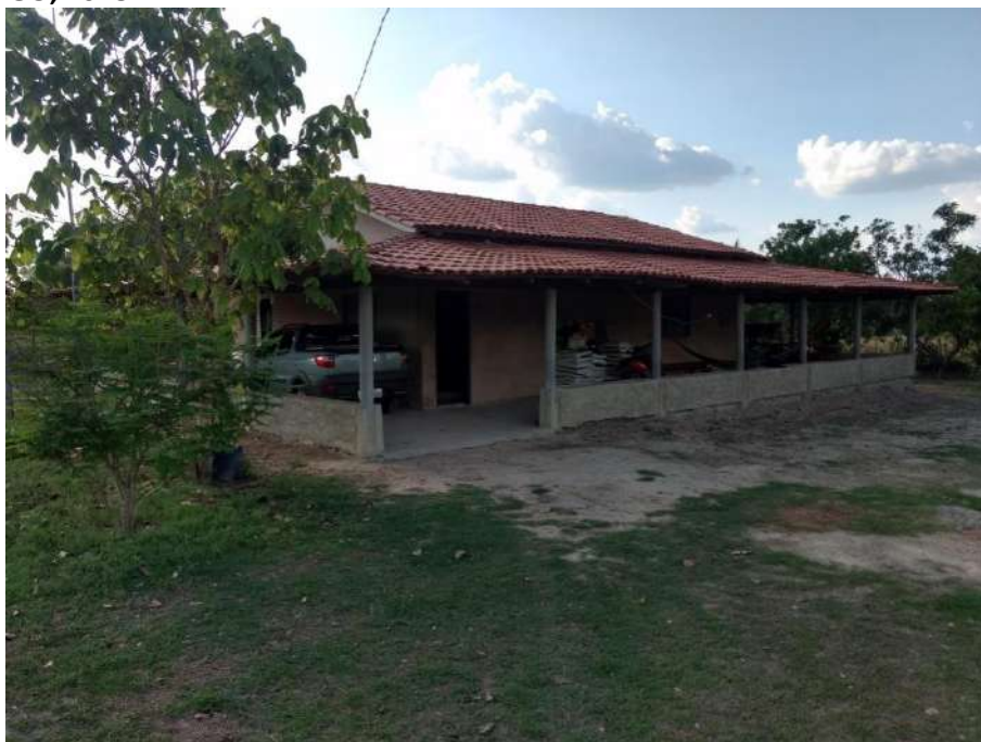
Foto 4.11 – Cobertura de telha de barro, identificada na Comunidade Santa Maria do Crixás-Assú, Nova Crixás-GO, 2018.
