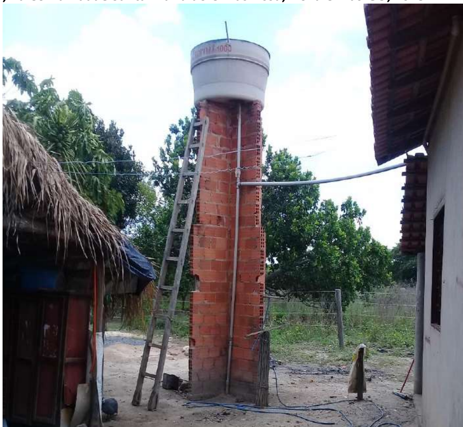
Foto 6.4 – Unidade familiar dotada de um único reservatório, sendo em fibrocimento e com presença de extrvasor, na Comunidade Santa Maria do Crixás-Assú, Nova Crixás-GO, 2018.
