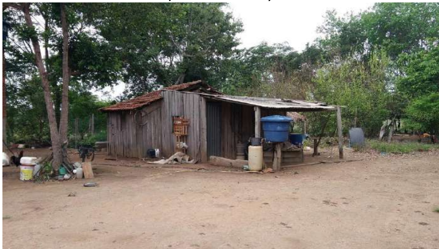
Foto 4.12 – Cobertura de telha de barro em associação com telha de fibrocimento, identificada na Comunidade Santa Maria do Crixás-Assú, Nova Crixás-GO, 2018.
